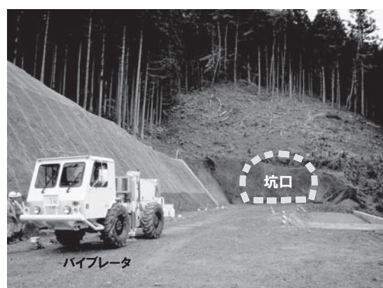
写真—2 トンネル坑外からの探査事例 [バイブレータ震源]
