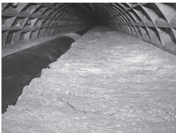
写真—1 アワモルの流動、充填状況
