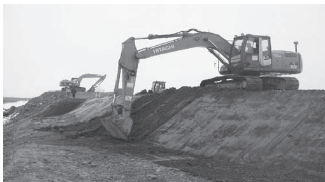
写真—1 ICT バックホウを用いた掘削状況
