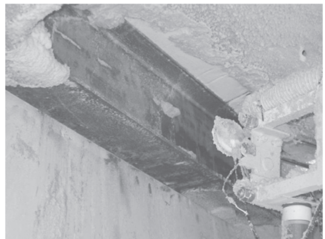
写真-1 除去後のH鋼梁面
