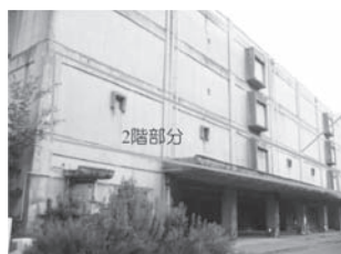
写真一 2 適用現場外観
