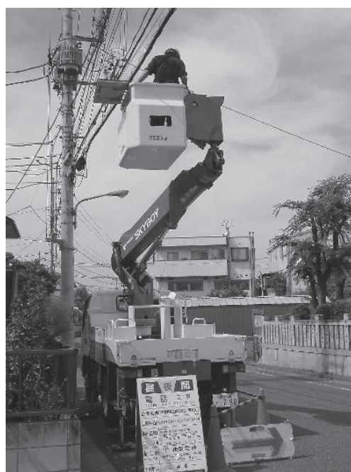
写真—1 光ファイバ接続工事
