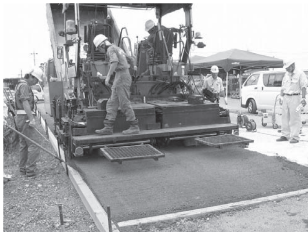
写真—10 アスファルトフィニッシャによる敷均し
