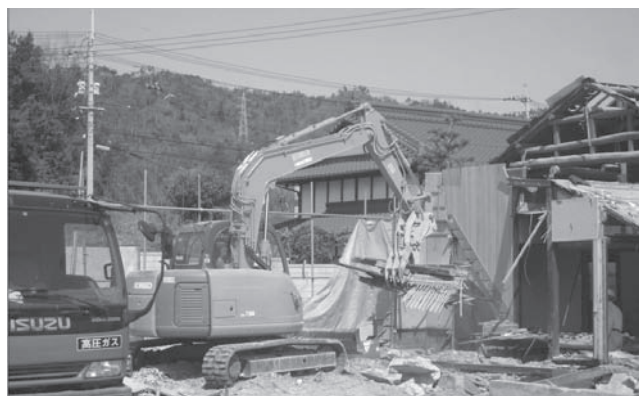
写真—2 稼働状況（家屋解体）
