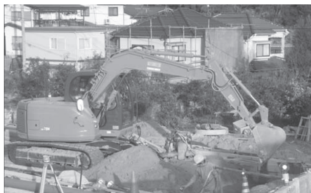
写真—4 稼働状況（宅地造成）
