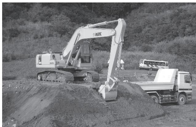
写真1 油圧ショベル省燃費運転講習
