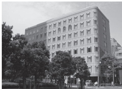
写真—1 建物外観（改修後）
