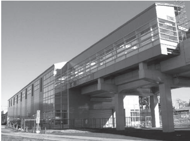
写真 2—1 流山セントラルパーク駅外観
