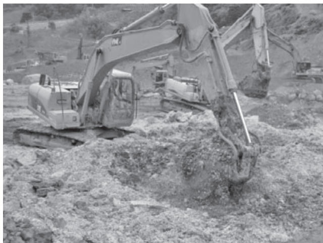
図一 3 殿ダム建設工事現場における沈砂地堆積泥土再資源化の様子
