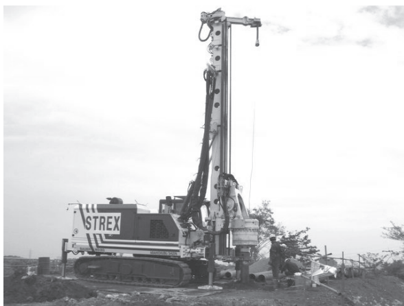
写真—1 STREX 工法施工機械
