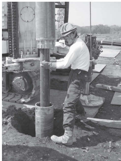
写真—2 施工状況(多目的管設置状況)
