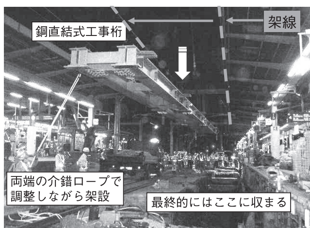
図一五 工事桁設置状況
