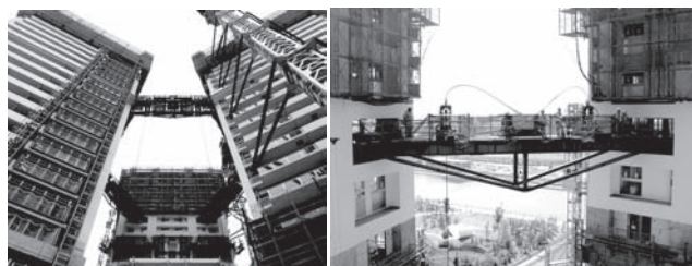
写真-3 リフティングガーター架設状況
