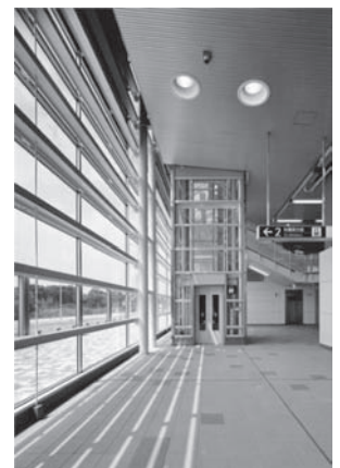
写真—5 柏の葉キャンパス駅 EV 部
