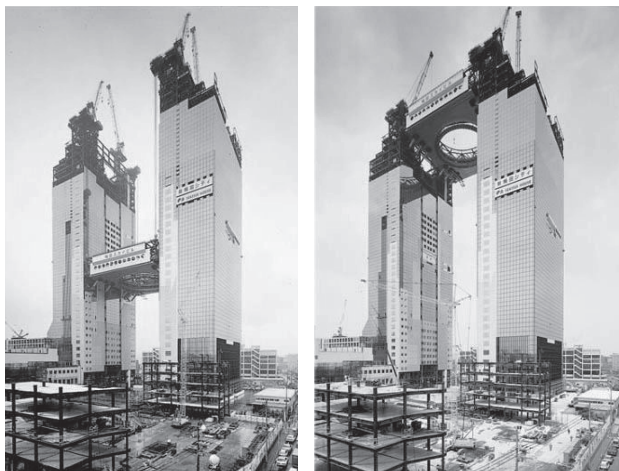
a. リフトアップ前 b. リフトアップ後 写真—1 梅田スカイビル
