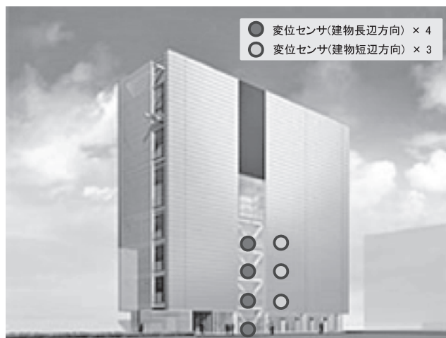
図一7 建物全景と設置センサ
