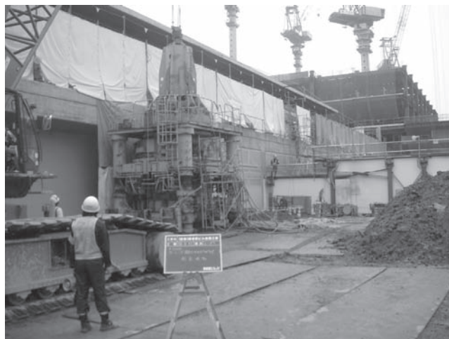
図—14 杭施工状況
