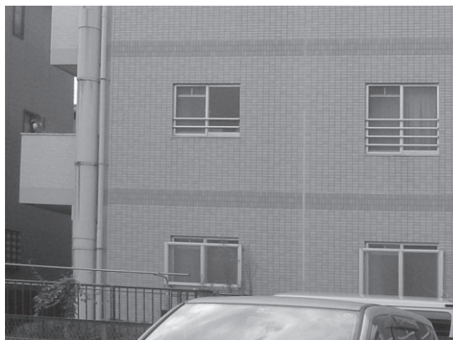
写真—5 可視写真（タイル張り）
