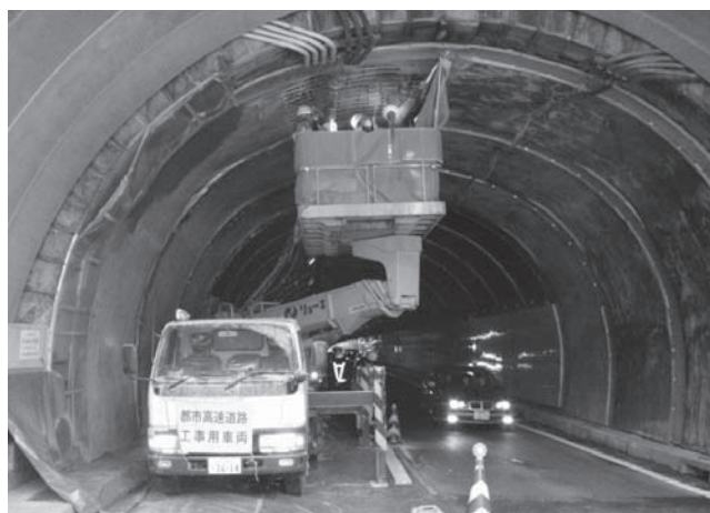
写真一 トンネル坑口補強状況
