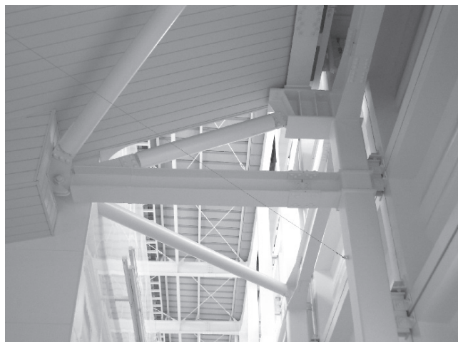
写真—1 高架橋と鉄骨フレーム
