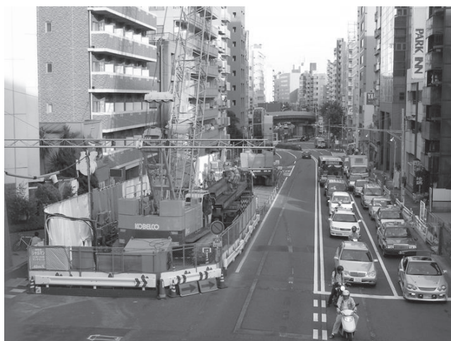
写真一 2 作業帯状況
