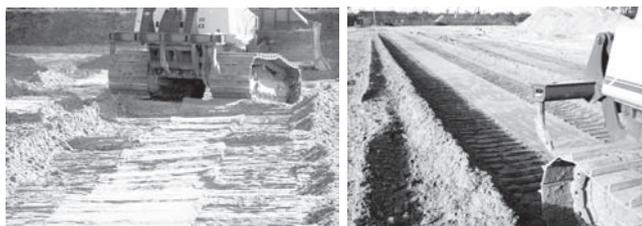
(a)従来のAMGブル (b)新型AMGブル (3速での施工)
