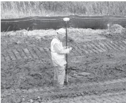
写真3-9 GNSSローバでの出来形計測
