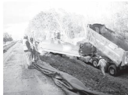
写真 3-7 AMG ブルドーザでの盛り土工
