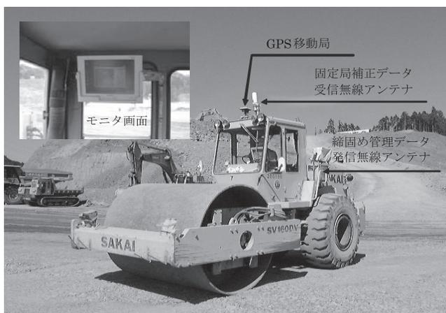
写真—8 GPSを用いた施工状況
