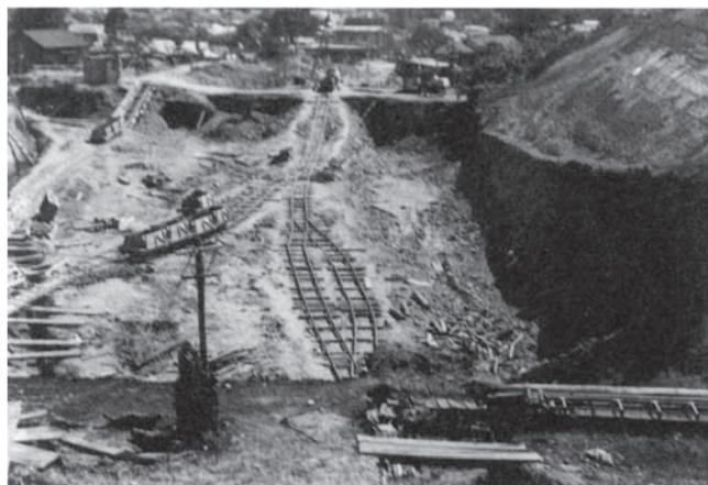
写真—2 横浜新道のディーゼルロコでの施工
