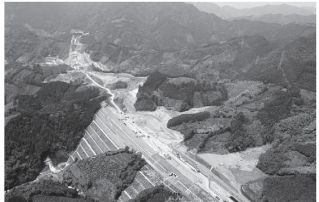
写真—5 高盛土の施工例(新東名高速道路静岡県内)
