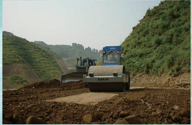
⇨ 2：320 kN 級振動ローラによる転圧作業と，32 t 級ブルドーザによる盛土材料のまき出し
