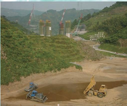
⇨ 5：60 m 級の高盛土施工箇所における大型機械による盛土（盛土初期段階）
