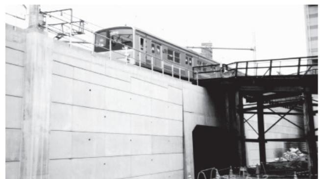
図一九 RRR工法の適用例<sup>15)</sup> (山手線, 新宿駅付近)
