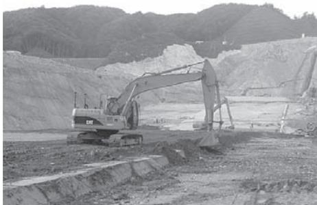
写真一4 GPS 搭載油圧ショベル
