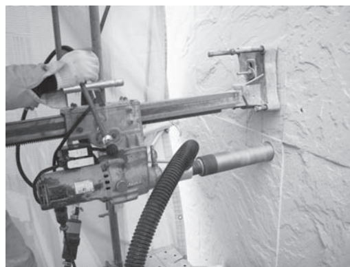
写真—7 乾式コアドリリング工法
