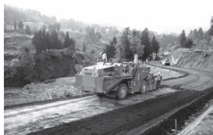
写真—2 新潟県中越地震災害復旧工事 (2004 年 5 月山古志村)
