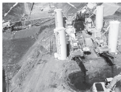
写真—3 不溶化処理状況
