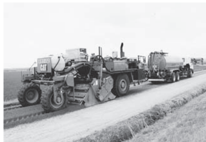
写真—5 秋田県八郎湯大規模農道表面処理施工現場
