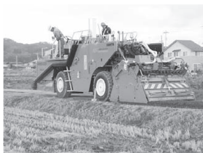
写真—6 農道表面処理施工現場
