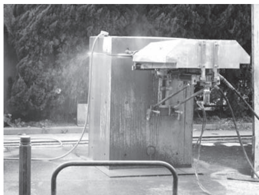
写真-4 ワイヤソーイング工法
