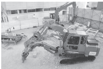
図—10 実証実験状況
