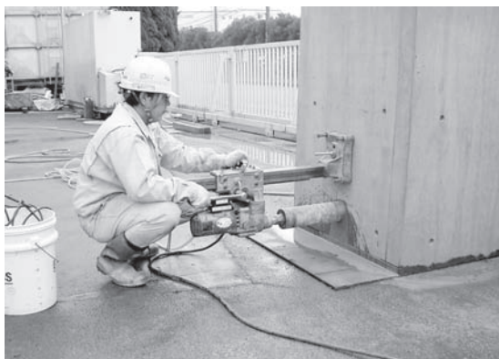
写真-2 コアドリリング工法
