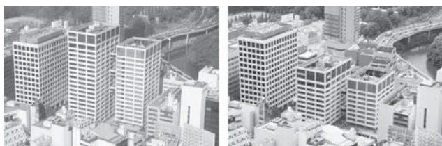
写真—1 旧本社ビル解体工事全景 (左：2月23日、右：5月28日撮影)
