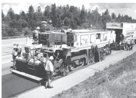
写真—4 敷き均し装置を装着したフォームドスタビライザ
