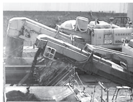
写真—1 石灰系固化材の混合攪拌状況
