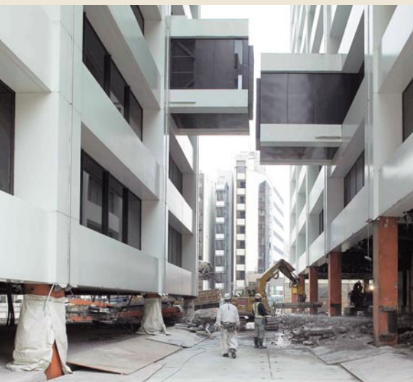
第1棟(左側) ジャッキダウン中
