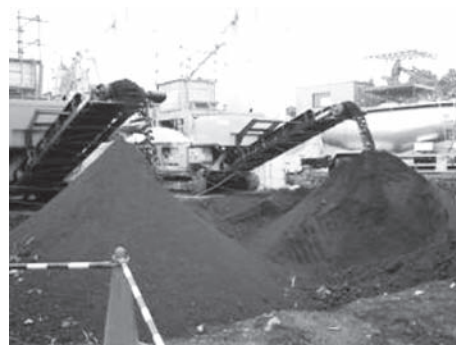
写真—2 アルミ系固化助剤の混合攪拌状況
