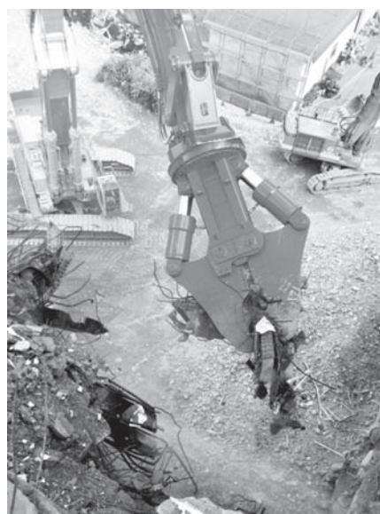
写真—5 稼働中のKR1600TPR
