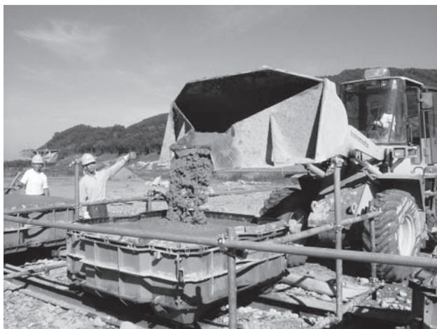
写真-4 ブロックの打設状況
