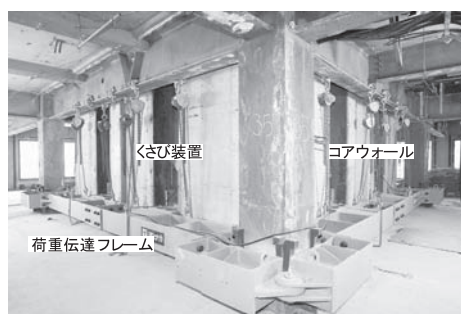
写真ー3 コアウォールと荷重伝達フレーム
