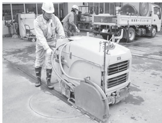
写真―1 フラットソーイング工法
