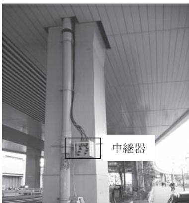
図一九 橋脚基部における中継機の設置状況
