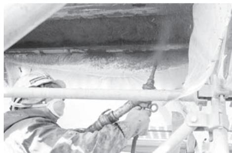
写真-5 吹付けによる断面修復の状況
