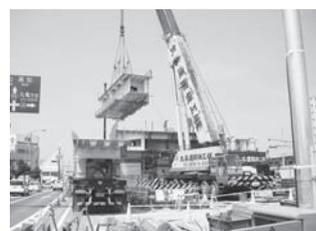
写真一3 上部工の架設 (鋼製橋脚)
