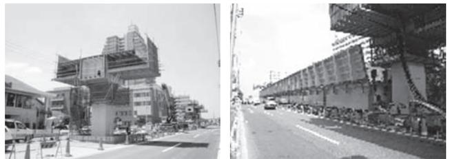
写真—7 橋脚柱部架設状況
