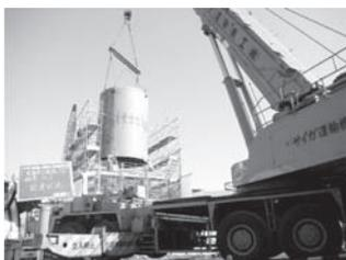
写真-16 鋼管ソケットの設置
