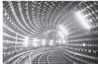
写真一 1 鋼製セグメント区間状況
