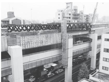
写真一3 架設用トラス桁
