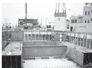
写真一2 下部工・基礎の架設 (鋼製橋脚)
