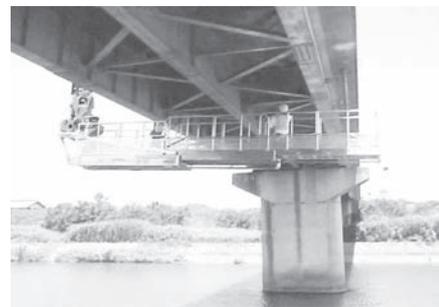
写真一7 橋梁点検作業風景
