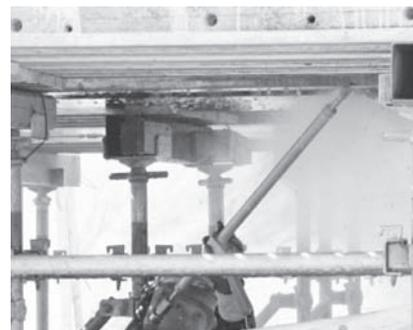
写真一3 ウォータージェットによる脆弱部のはつり状況
