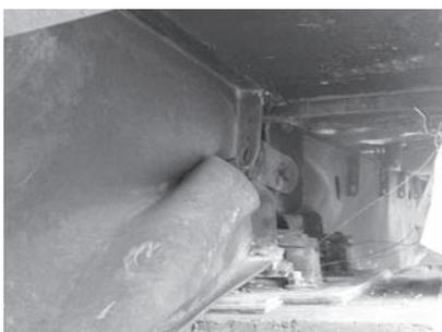
写真—2 上層主桁変形損傷状況
