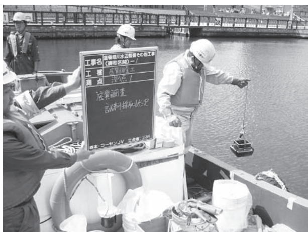
写真一3 概略調査の状況
