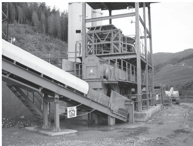
写真一 2 稼働状況 (中国地方整備局 尾原ダム工事現場)
