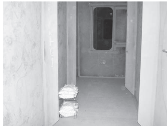
図一 7 箱桁内部状況 (竣工後 1 年)
