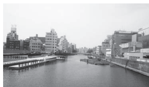
写真1 着手前の状況
