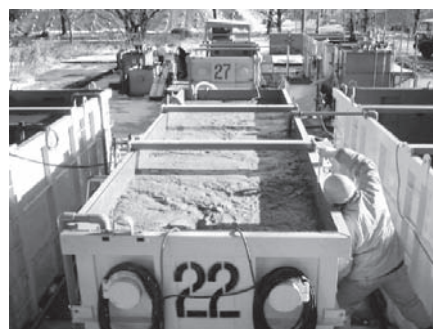
写真一 粘性土の洗浄無害化処理実施状況
