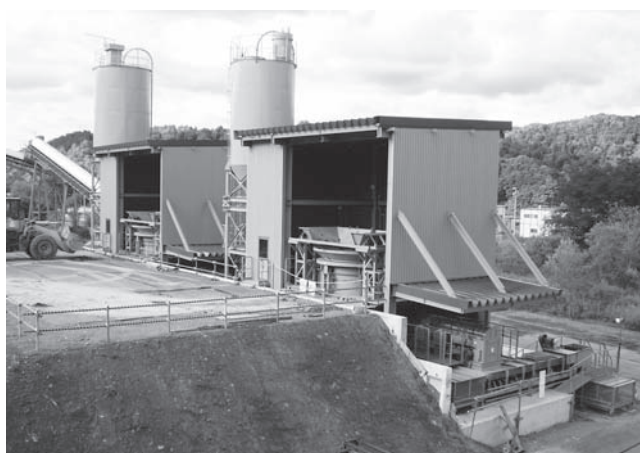
写真一 4 稼働状況 (北海道開発局 タ張シューバロダム工事現場)
