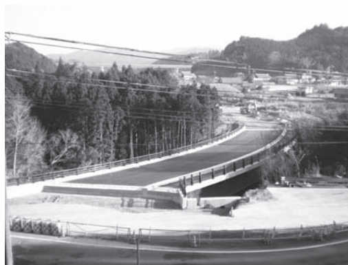
図—1 唐戸川新橋全景
