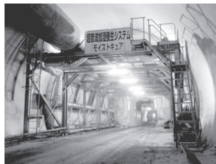
写真一 「モイストキュア」施工状況
