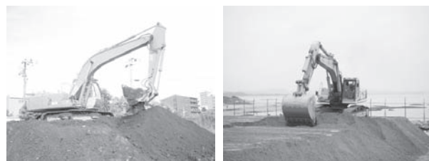
写真—1 ランドファーマーミングによる浄化の様子
