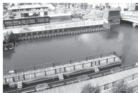
写真2 護岸矢板打設後の状況
