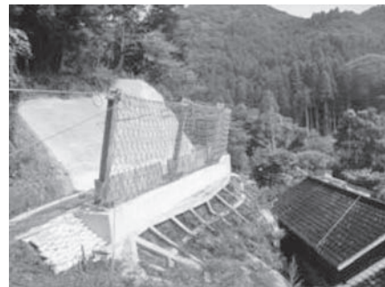
写真—9 インパクトバリア設置事例②（宮崎県）
