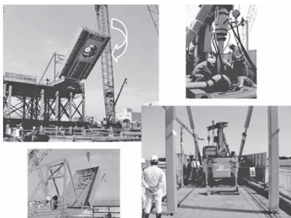
写真-1 ポータブルステージ設置・掘削状況
