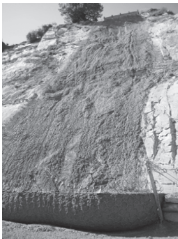
写真—7 2008年8月にスイスにて実施された実物大実験の様子
