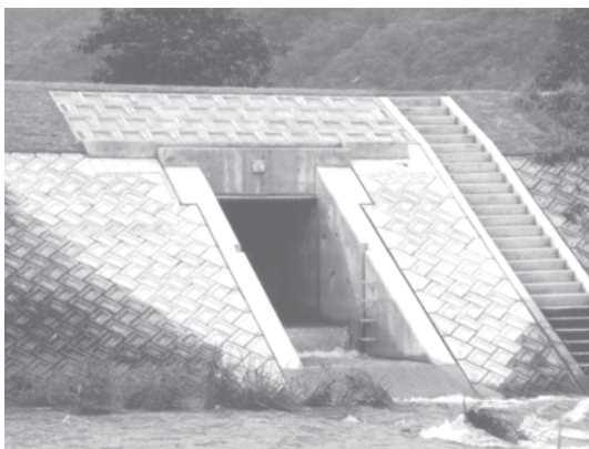
写真—3 改修後（KaNaF ゲート）
