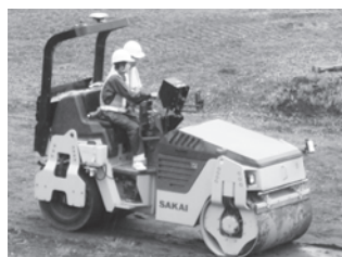
締固め管理システム
