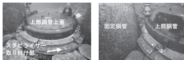
写真-4 上部鋼管格納時の状況
