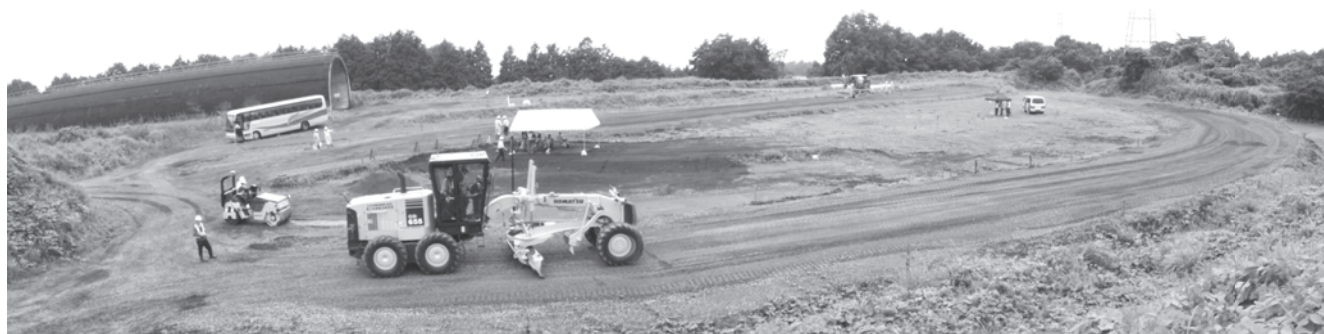
写真—2 屋外実習ヤード状況
