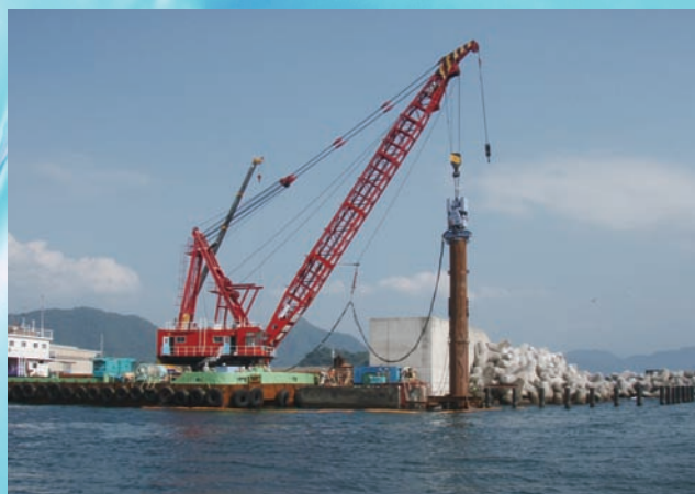
⇩実海域実証試験（下部鋼管打設状況）
