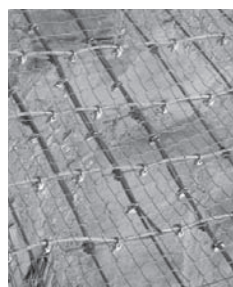
写真－3 (2) ネット補修後の状況
