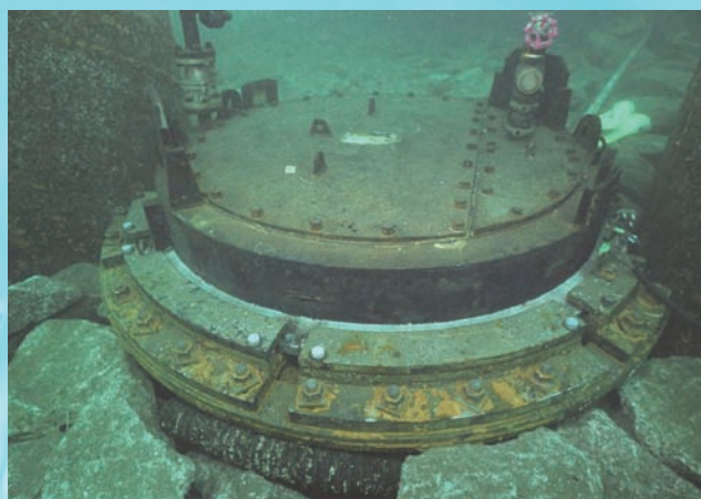
⇩実海域実証試験（海底格納状況）
