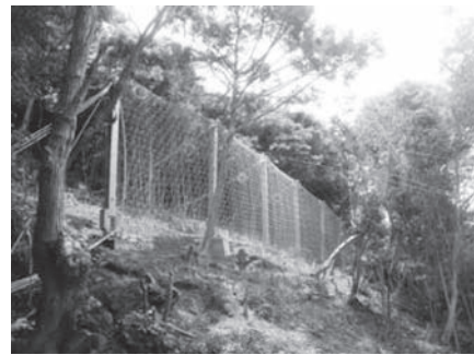
写真—8 インパクトバリア設置事例①（長崎県）
