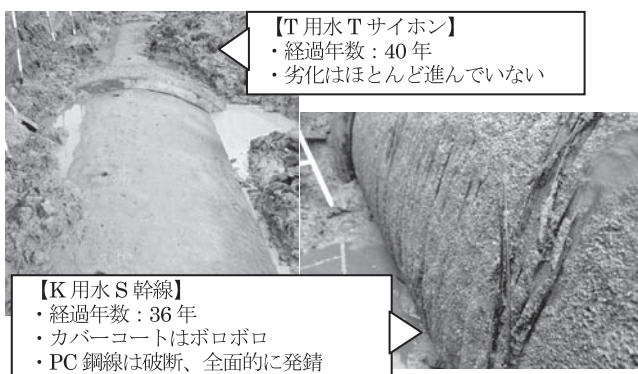
写真—2 同様の経過年数で劣化状況が異なる例
