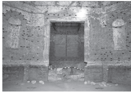
図一 14 貴賓広室（内装撤去後）
