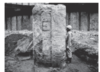
写真-3 出来形確認状況
