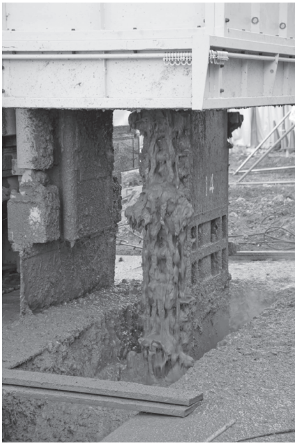
写真-3 掘削中のカッターポスト
