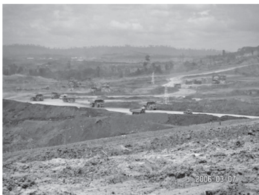
写真一 現場風景
