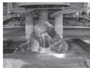
写真-2 施工状況（削孔時）
