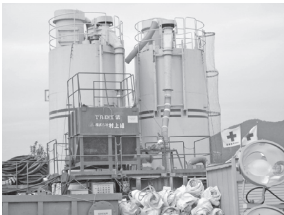
写真-4 プラント設備
