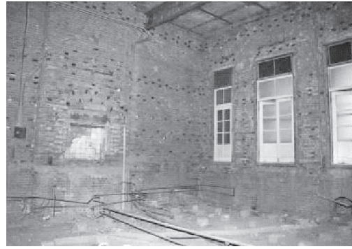
図一 13 貴賓待合室（内装撤去後）
