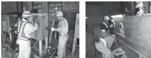
図一6 擬石の試験施工
