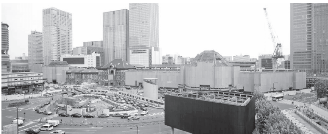
図-1 工事の全景（平成21年9月現在）
