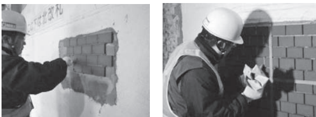
図-2 覆輪目地の試験施工
