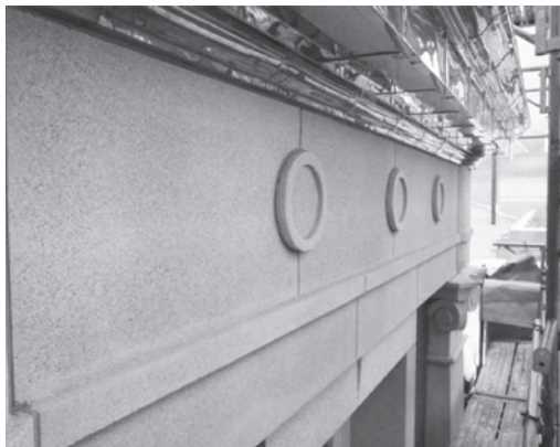
図一7 現地での擬石の施工
