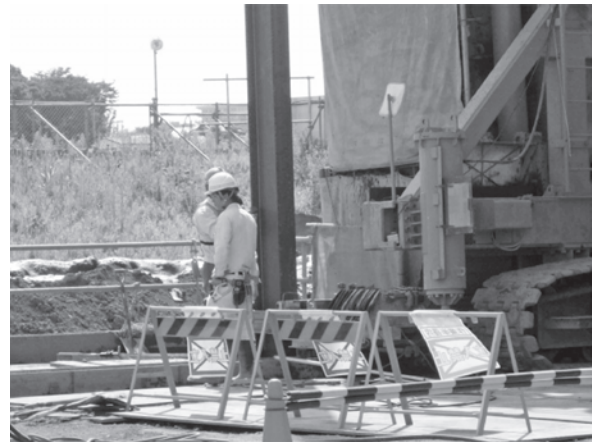
写真-5 芯材投入状況（後日撮影）
