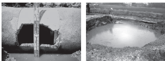
写真—1 PC 管破裂と地表面陥没事例
