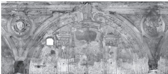
図—10 オルソ画像（南ドーム南東面）
