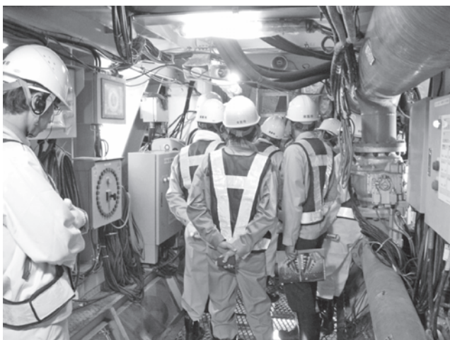
写真一 三 シールドマシン機内
