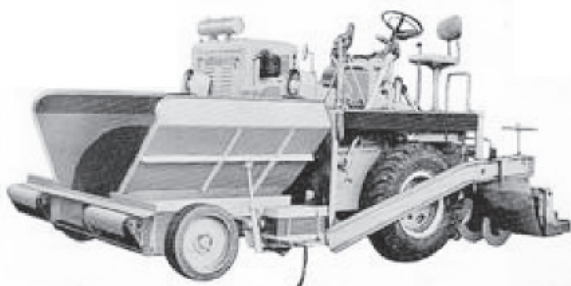
写真6-1 昭和30年頃のホイール式アスファルトフィニッシャ
