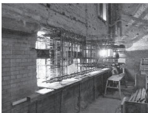
図一19 縦梁配筋状況
