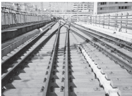
図—12 合成まくらぎ直結分岐器
