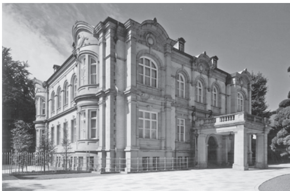
東・北面車寄せ外観
