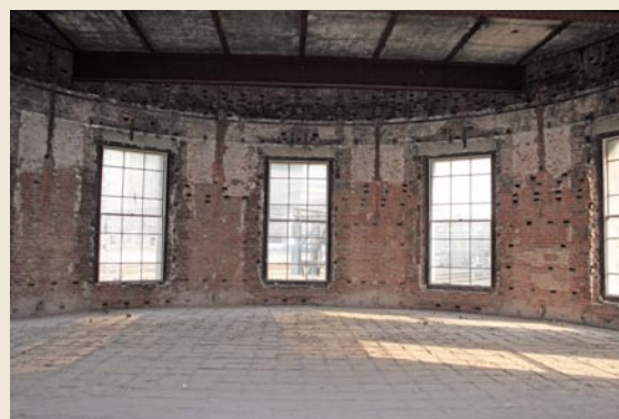
改装中の室内
