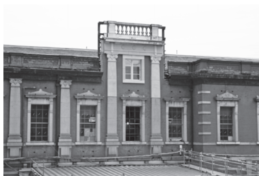
図一8 外壁モックアップの全景
