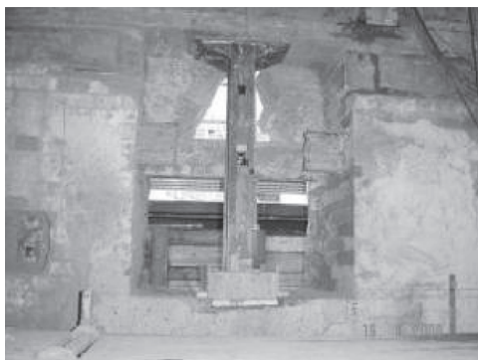
図一18 仮受支柱設置状況
