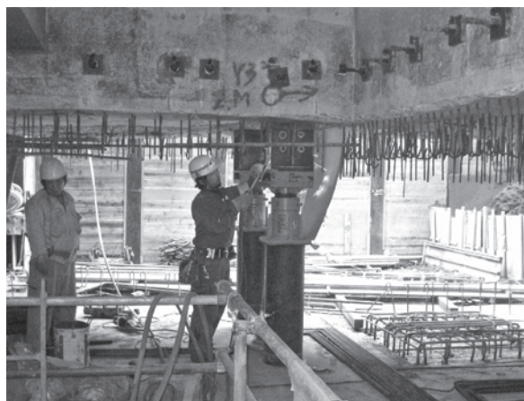
既存基礎下扁平補強梁配筋
