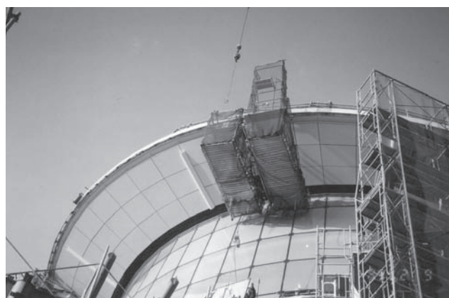
写真—19 東京国際空港第2ターミナルビル
