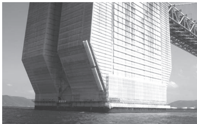
写真—11 瀬戸大橋アンカレイジ
