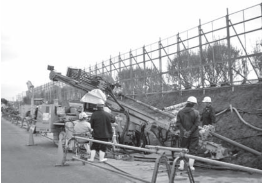
写真—2 片側通行を確保して施工
