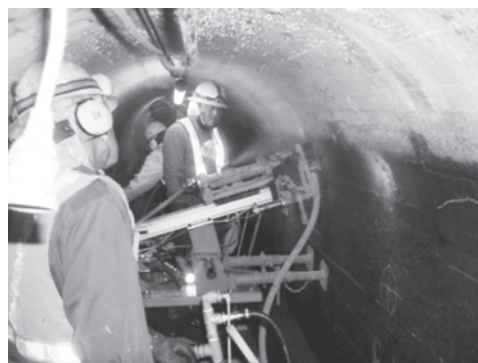
写真—2 モールボルティング工法 ロックボルト施工状況
