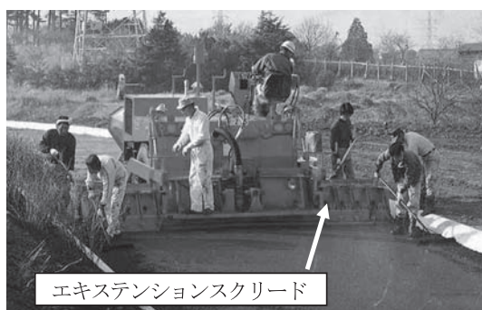
写真 11—1 エクステンションスクリードを取付けたアスファルトフィニッシャ
