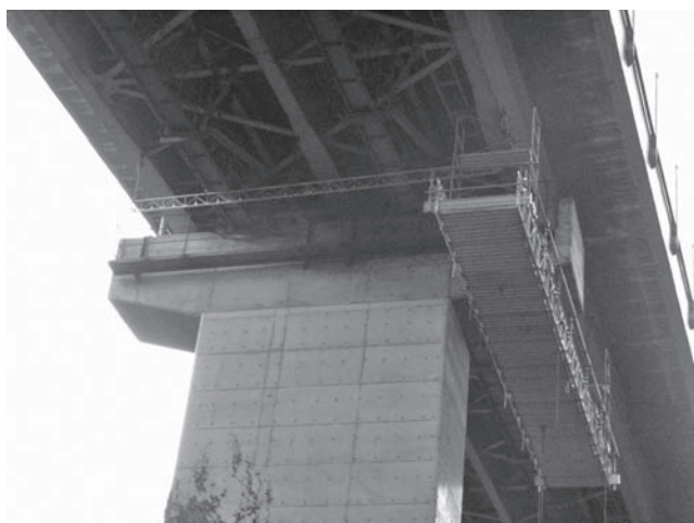
写真—4 滝沢川橋（次径間へ盛替中）
