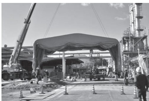
写真-5 テント移動状況
