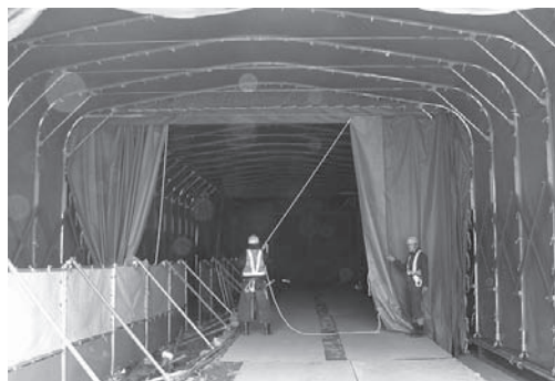
写真—1 間仕切り膜取付状況
