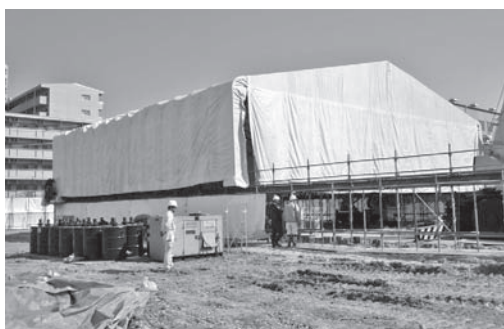
写真-3 テント嵩上げ状況
