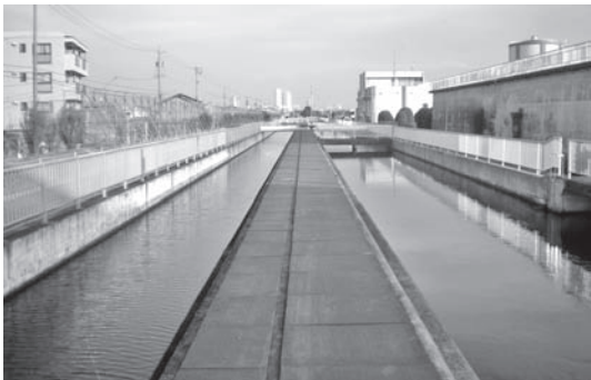
写真—1 原水開渠
