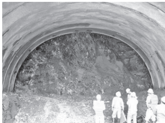
写真—2 第二伊勢道路 4 号トンネル
