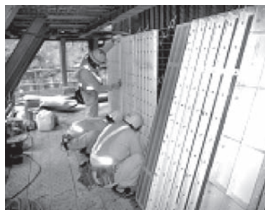
写真—2 HSF 装置内での型枠組立状況
