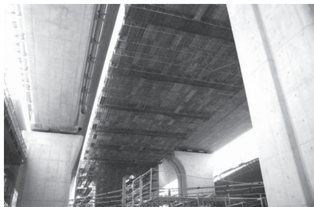
写真—8 第二京阪国道
