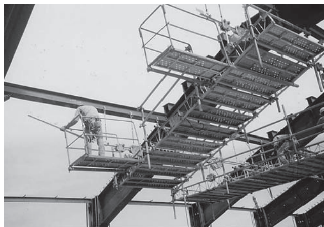
写真—2 手摺り内での作業状況
