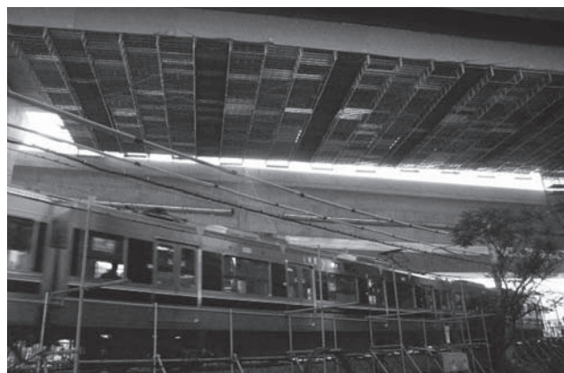
写真—7 第二京阪国道
