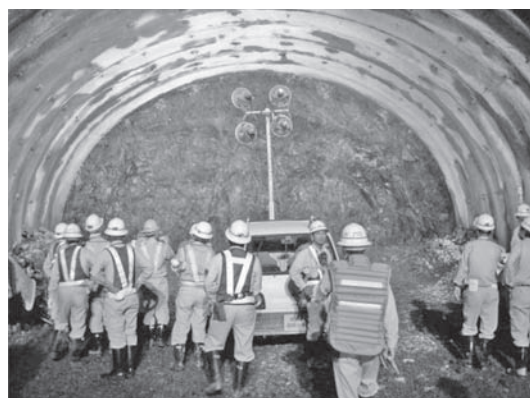
写真—4 東紀州トンネル
