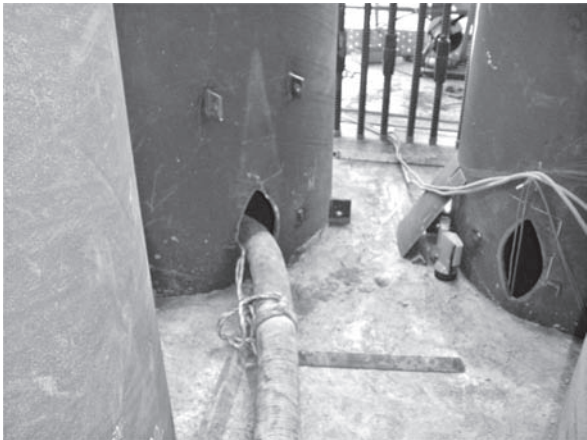
写真―3 鋼管中詰コンクリート打設状況
