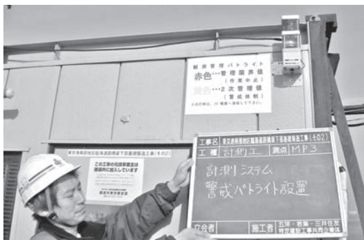
写真一1 警報機（回転灯）設置状況
