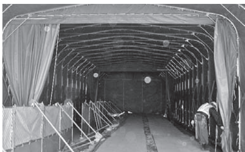
写真-2 間仕切り膜取付状況
