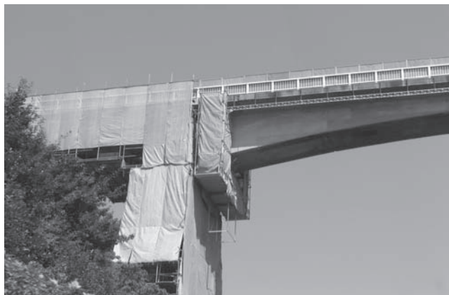
写真—13 名田跨道橋
