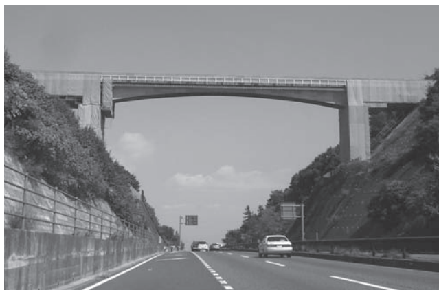
写真—12 名田跨道橋
