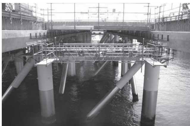
写真—15 東京国際空港D滑走路
