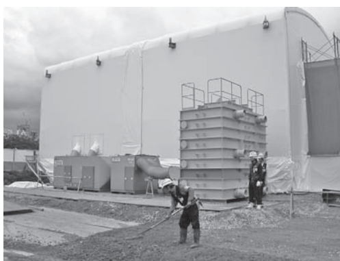
写真-7 集塵機設置状況
