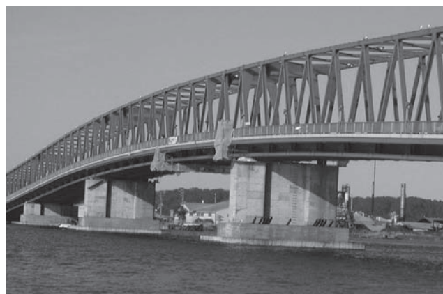
写真—17 厚岸大橋
