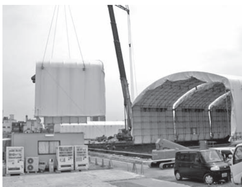
写真-6 テント移動状況
