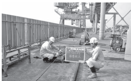
写真-4 「曲がり削孔」探査孔からの磁気探査
