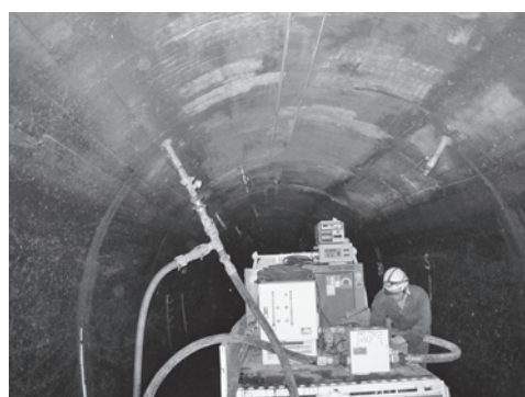
写真—3 モールグラウト工法 充填作業状況
