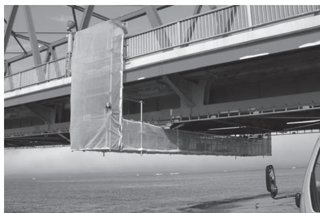
写真—18 厚岸大橋
