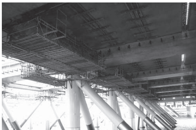
写真—14 東京国際空港D滑走路
