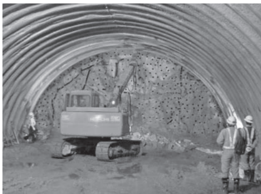
写真—3 安永川トンネル
