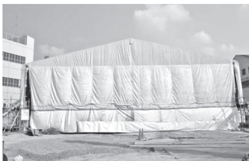
写真-4 テント嵩上げ状況
