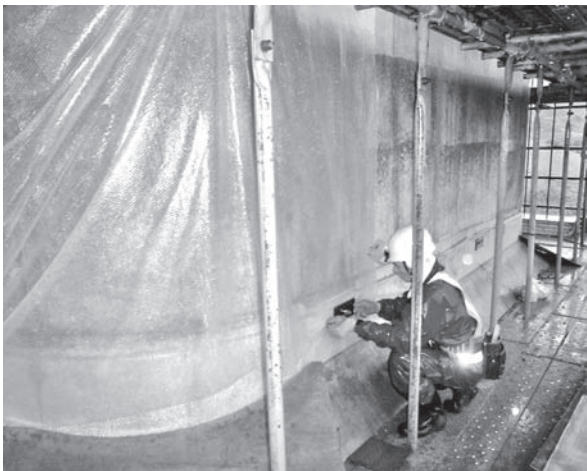
写真―4 気泡緩衝材巻付け状況
