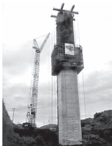
写真—1 施工状況全景
