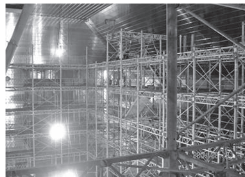
写真—4 最上階足場解体風景
