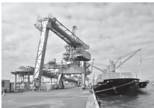
写真－3 岸壁の荷役作業状況
