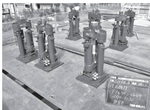
写真—3 ダブルツインジャッキ概要
