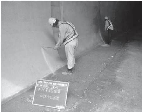
写真—1 センサーラインの設置状況
