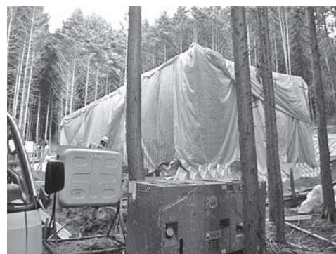
写真—3 養生システムの実用化
