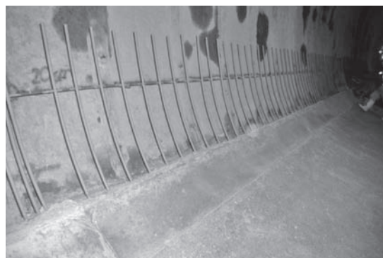
写真一5 FS フォーム脱型後状況
