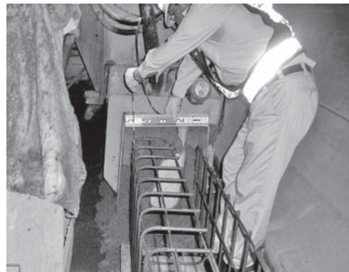
写真—4 打設成型状況
