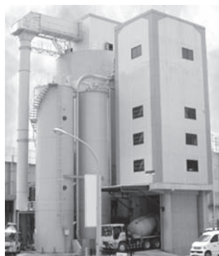
写真—7 コンクリートプラント-1
