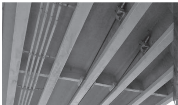
写真—3 塩害を受け、アウトケーブルで補強した橋梁
