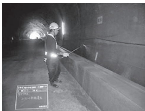
写真—7 養生剤散布状況
