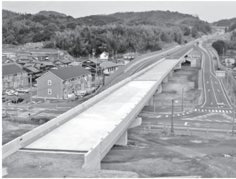
写真—7 完成した上部工（竣工時にひび割れは確認されていない）
