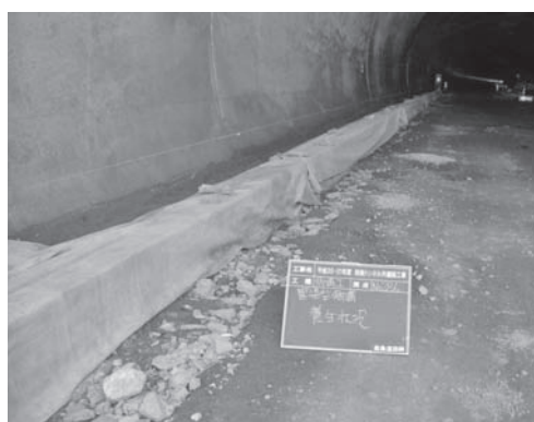
写真—8 養生マットによる養生状況
