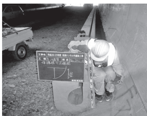
写真—9 管渠型側溝設置完了
