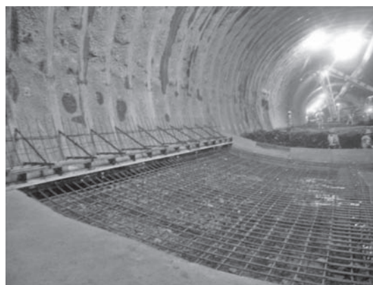
写真一4 FS フォームの設置完了
