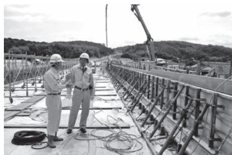
写真—5 養生システムを採用した国道バイパス上部工
