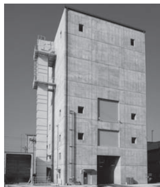
写真—8 コンクリートプラント-2
