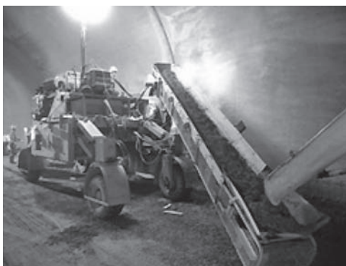
写真—3 コンクリート投入状況
