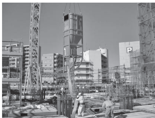
写真—2 バケット打設状況
