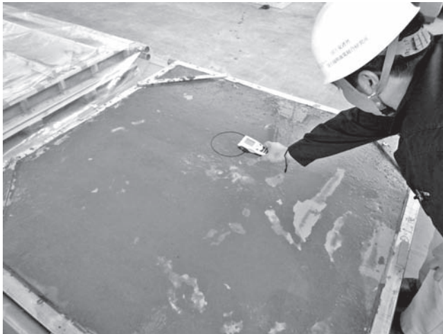
写真—5 コンクリート中に埋め込んだ IC タグとの通信性調査
