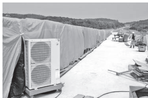
写真—6 養生システムの設置状況
