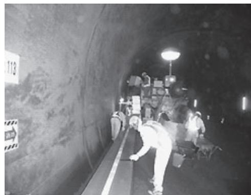
写真—5 コテ仕上げ状況
