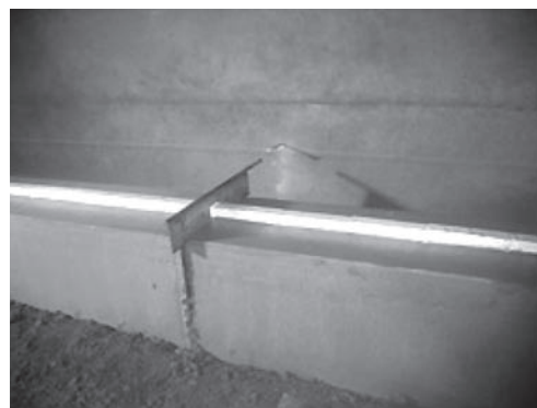
写真—6 目地設置状況
