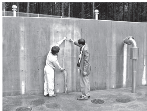
写真—4 練炭とジェットヒーターによって養生された貯水槽でひび割れ調査
