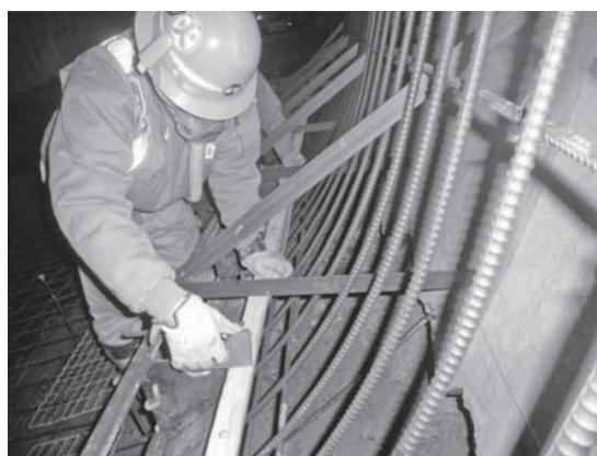
写真一2 シート取り付け (タッカー使用) 状況
