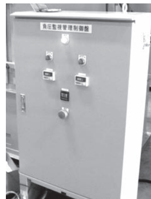
写真-3 バキュームコントローラー
