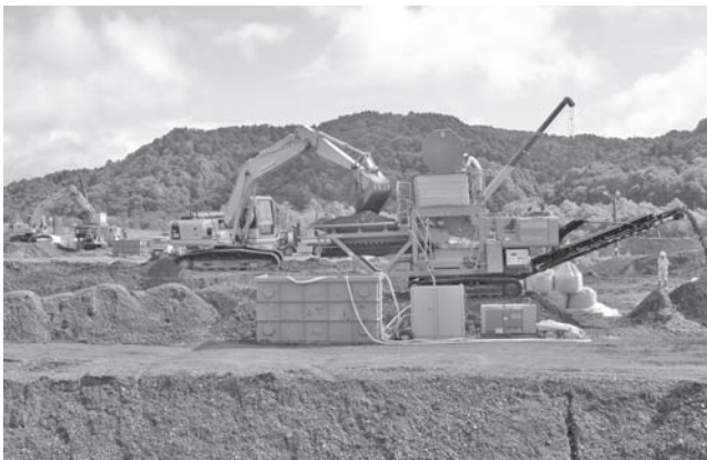
写真一 2 自走式土質改良機によるCSG製造
