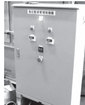
写真-2 負圧自動制御装置
