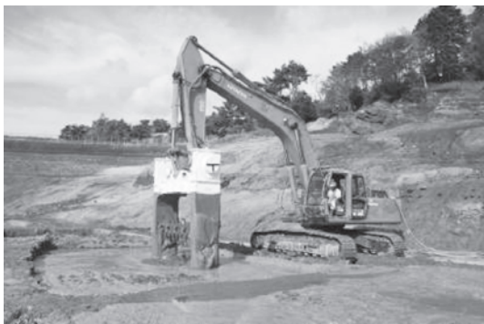
写真—2 DAM機による攪拌状況
