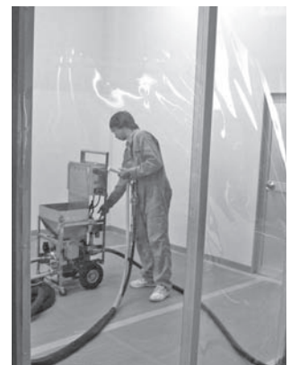
写真-4 作動確認試験風景
