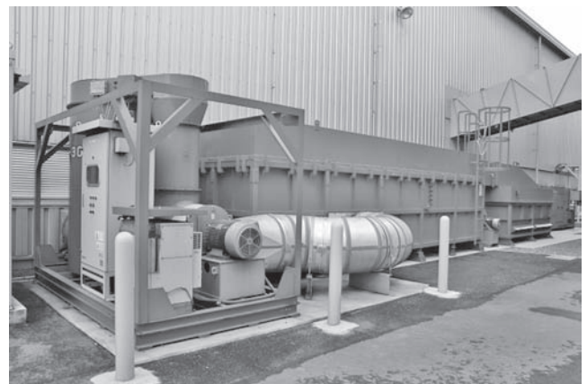
写真—5 前処理室用集塵機
