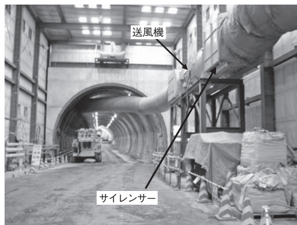
写真-1 送風機設置状況（防音シェルター内）
