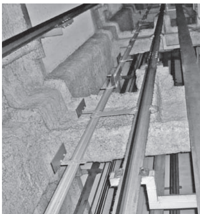
写真-1 エレベーターシャフト内部
