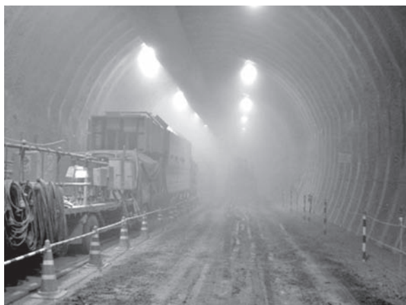
写真—3 掘削時状況写真
