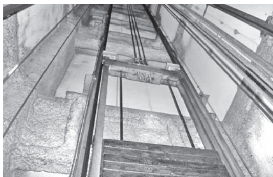
写真—1 エレベーターシャフト内部
