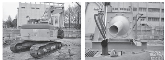
写真-2 2次音源およびエラーマイク設置状況(建設現場)
