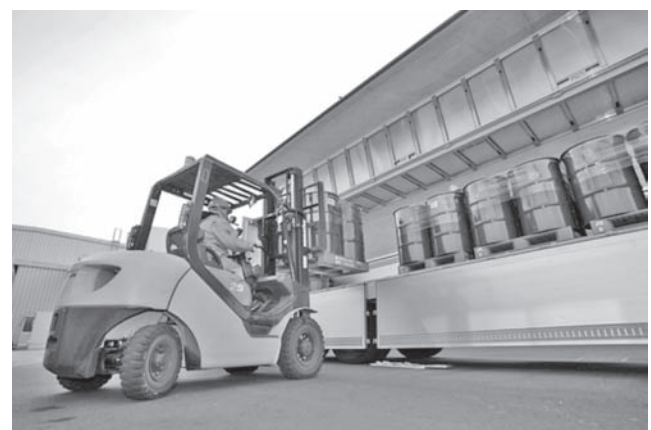
写真—1 汚染土壌の搬入
