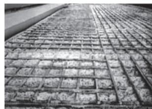
写真—1 鉄筋までの除去
