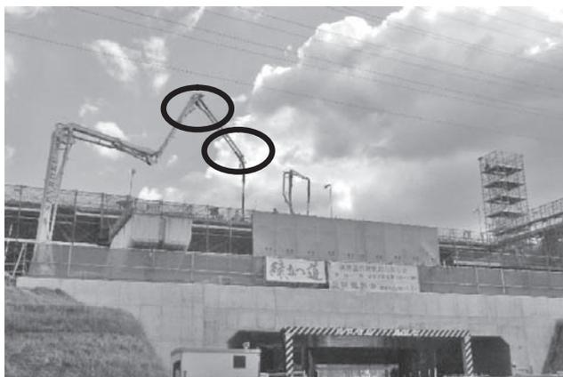
写真一6 球面リフレクタ取付けポンプ車による施工状況
