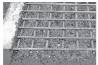
写真—2 鉄筋以深までの除去
