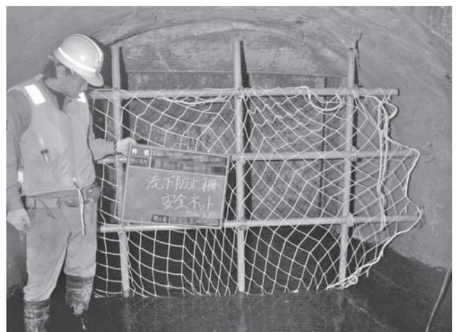
写真—1 安全対策の例（流出防止柵）
