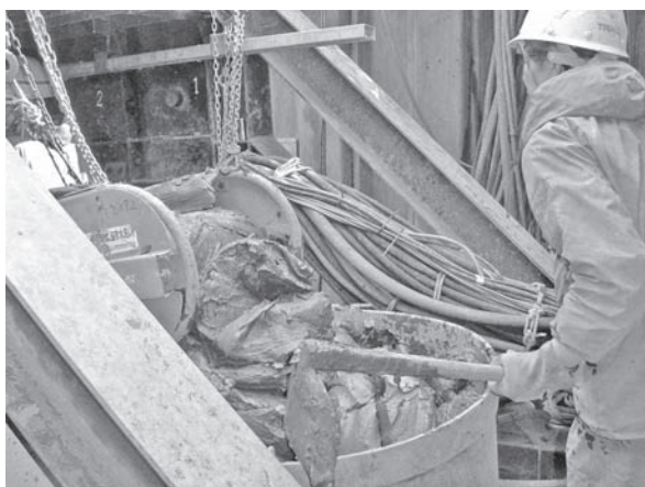
写真—5 排土状況
