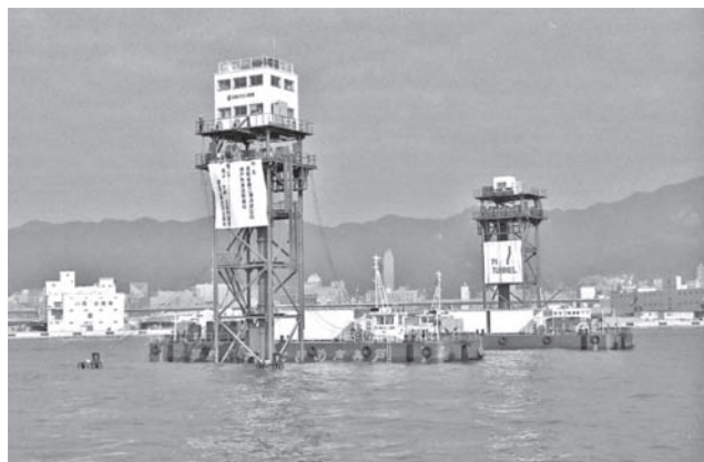
写真—1 従来のツータワーボンツーン沈設方式 (神戸港港島トンネルの例)
