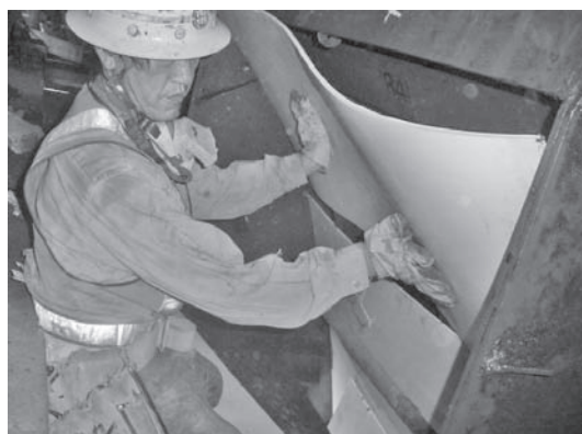
写真—2 構造板取付け状況
