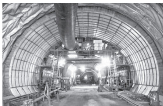
写真—5 うるおい養生全景
