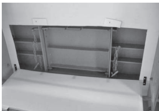
写真—4 側フォーム部（打設窓箇所）
