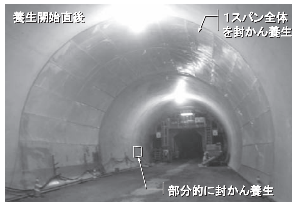
写真—1 プラスチックフィルムの設置状況
