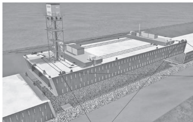
図一 12 キーエレメント工法による最終函の沈設
