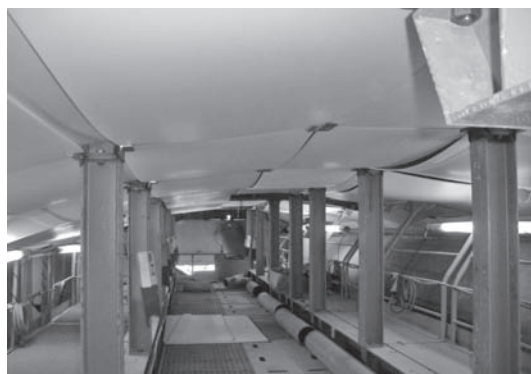
写真—1 温ぬく養生状況（例：セントル天端部）
