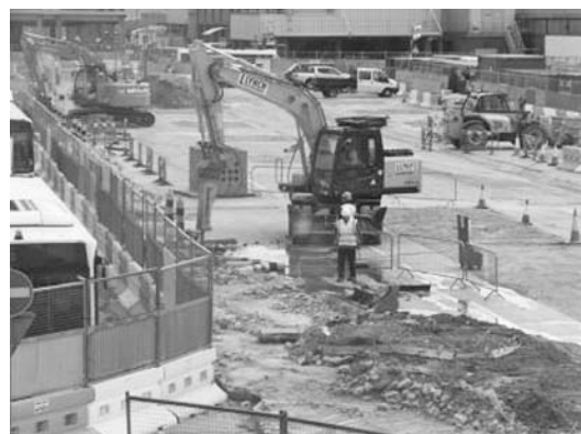
写真一 4 拡張整備中のヒースロー国際空港
