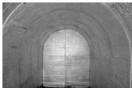
LHT 設置 (大鰐広帯域地震観測施設建設工事)
