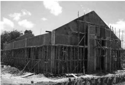
写真－8 分析室建設中
