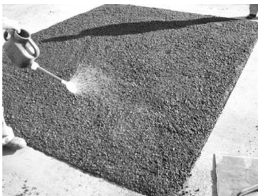
写真—3 散水状況
