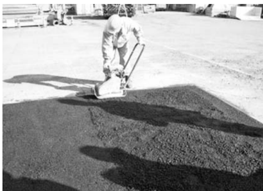
写真—4 転圧状況
