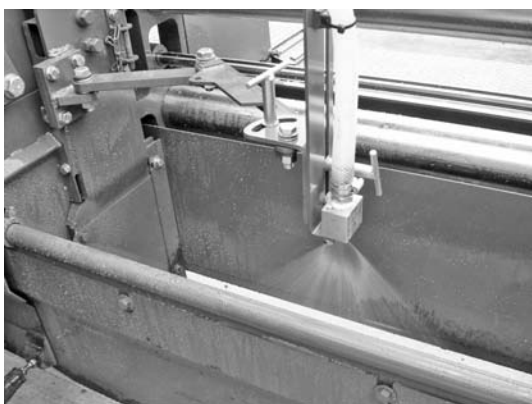
写真—6 散水状況
