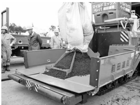
写真—8 フレコンバック貯蔵合材の施工状況
