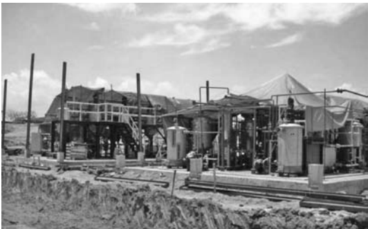
写真－7 パイロットプラント建設中
