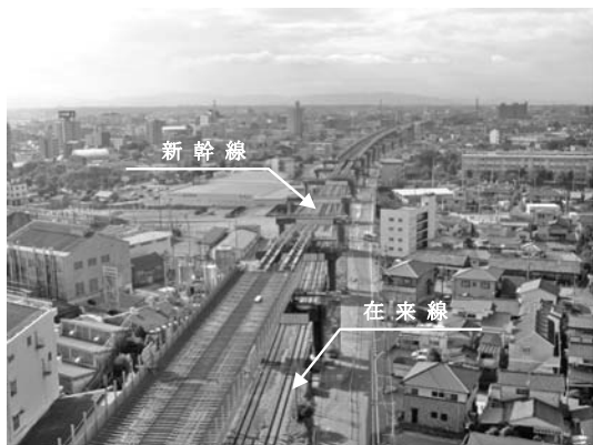
写真—12 桁送出し（中央部）全景
