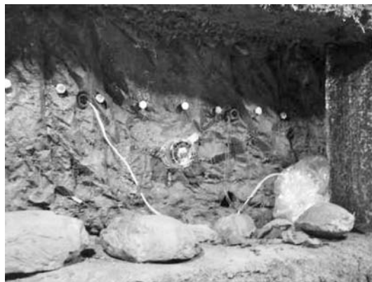
写真—17 坑内窓開き部原位置岩片
