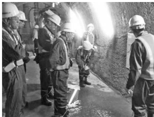
写真-13 坑道内での説明状況
