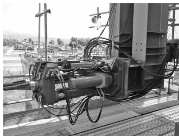
写真-3 ダブルツインジャッキ
