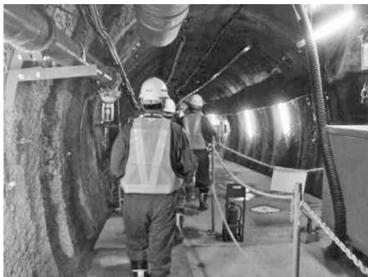
写真—15 坑内移動状況
