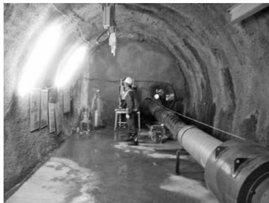
写真-14 坑内状況
