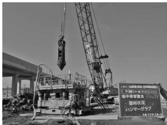
写真—5 転石撤去施工状況 (機械：全周回転チューピングマシン)
