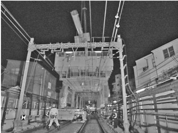
写真－３ 架設施工機
