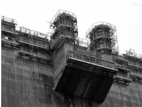
写真—7 大山ダム 常用洪水吐き上流側呑口部 プレキャスト型枠と鋼製ダム型枠
