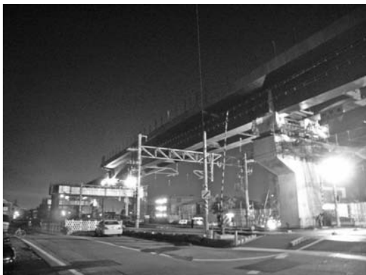
写真—11 夜間送出し施工状況
