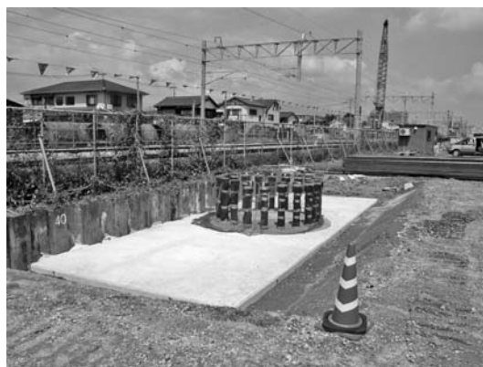
写真—5 門型橋脚基礎完了（場所打ち杭）
