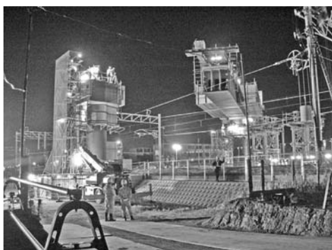
写真—9 夜間橋梁回転施工状況
