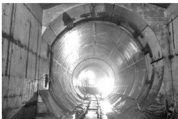
写真—6 トンネル接続部（覆工終了後）
