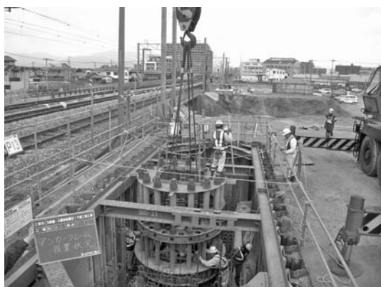
写真—4 アンカーフレーム設置状況
