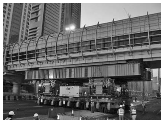
写真－2 橋桁運搬状況（桁は油圧サスペンションで水平保持）
