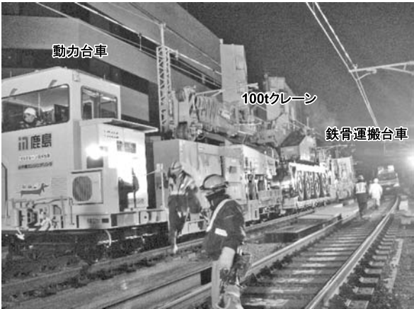
図一 7 鉄骨架設編成
