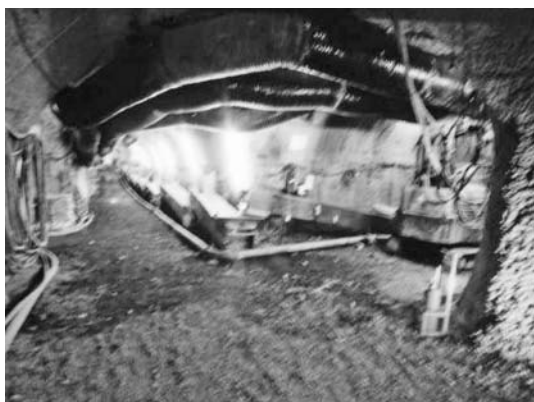
写真—16 坑道分岐部
