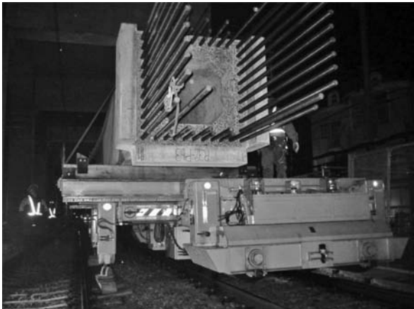
写真―6 荷台スライド機構による積み降ろし
