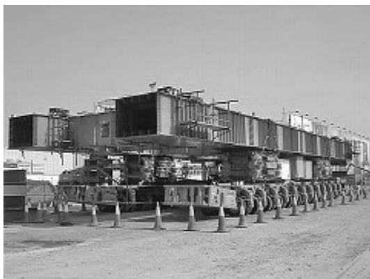
写真—4 SPMT (SJと工事桁を積載した状態)
