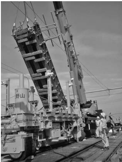
図－６ 試験施工（柱吊上げ）
