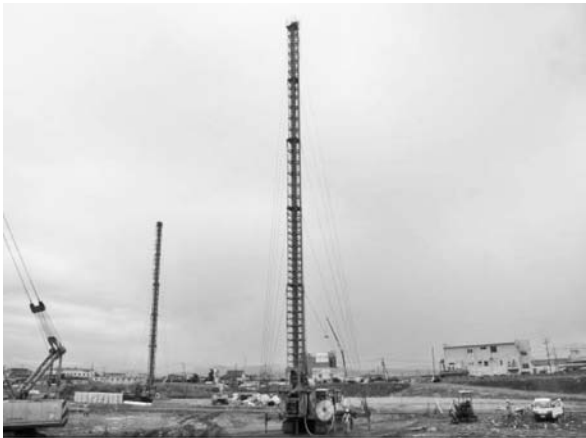
写真一 鉛直ドレーン打設状況 (機械：鉛直ドレーン打設機)
