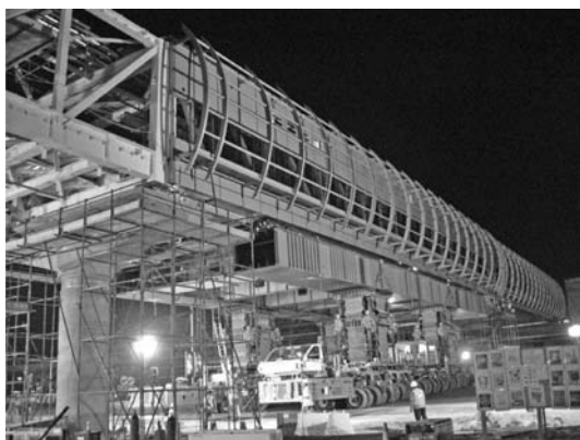
写真—3 橋桁の架設状況
