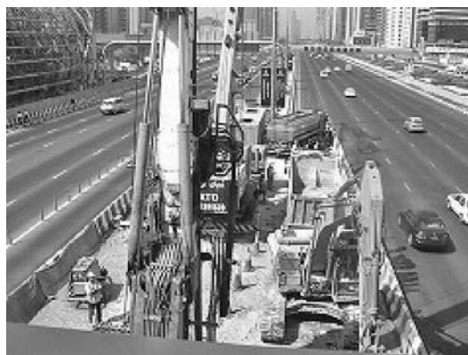
写真一7 基礎杭工事状況 (中央分離帯)
