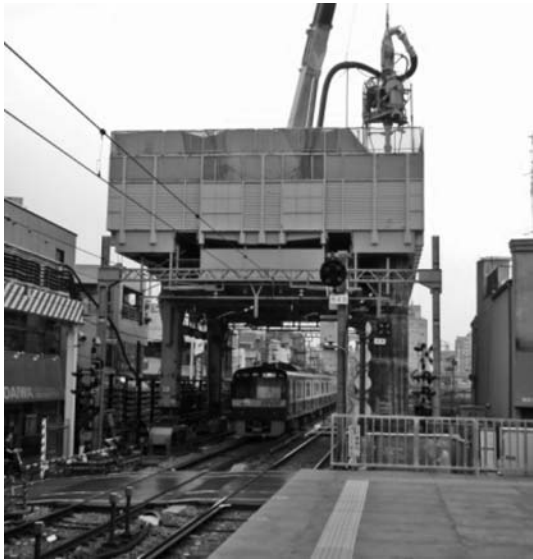
写真－２ 杭施工機
