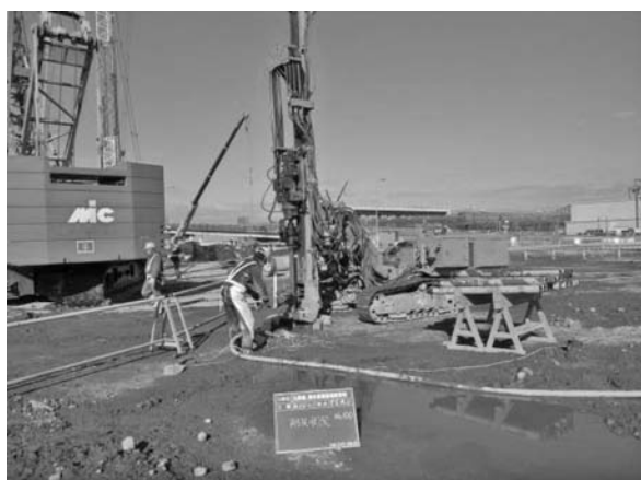
写真—4 転石チェックボーリング施工状況 (機械：ロータリーパーカッションドリル)
