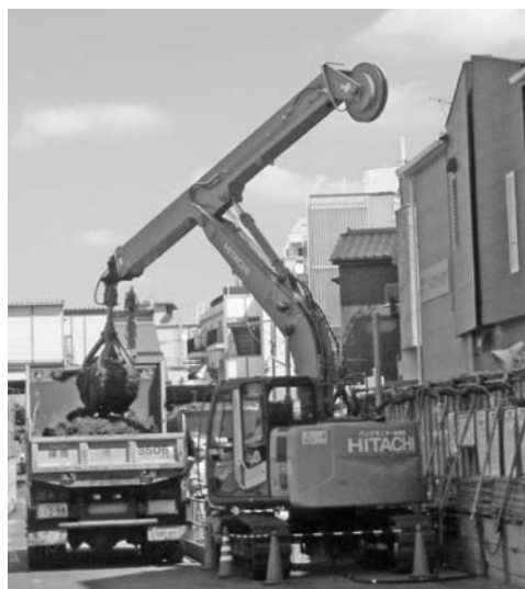
写真-2 電動式テレスコラム
