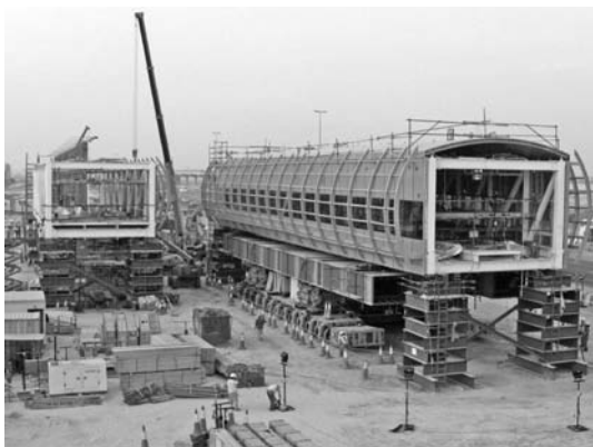
写真一6 地組みヤードでの施工状況
