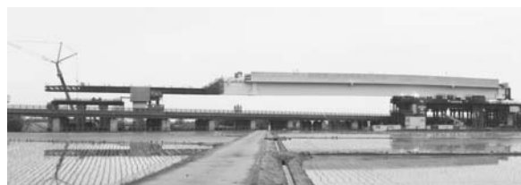
①送出し1日目完了後
