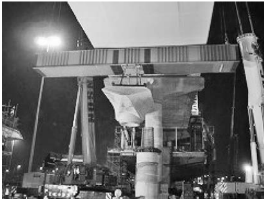
写真—8 柱頭部架設状況
