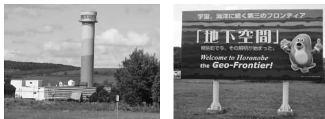
写真-3 展望台と道路沿いの案内看板
