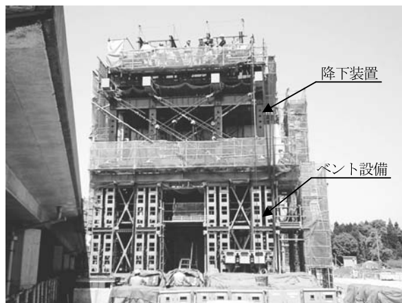
写真一4 長ストローク降下装置
