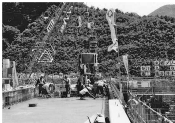
写真-1 東郷ダムコンクリート打設状況 200tクローラークレーン及び3m 3 バケットにて
