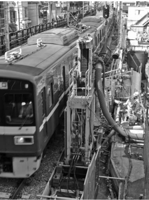
写真－４ 狭隘型リバース杭施工機
