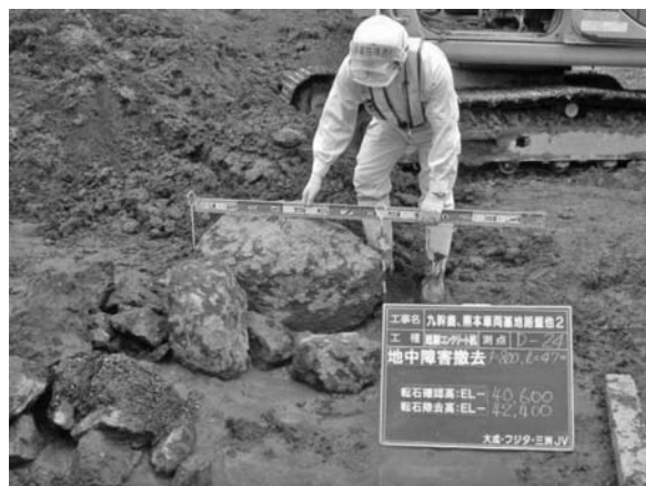
写真—6 転石撤去確認
