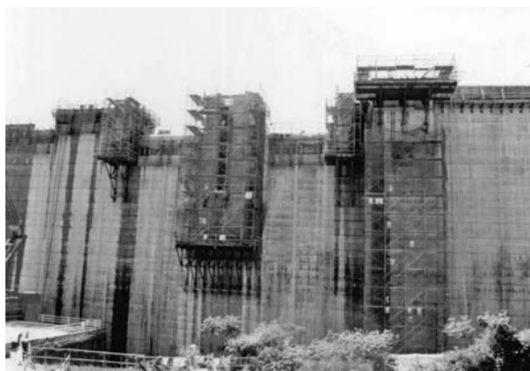
写真—2 東郷ダム施工中の上流面
