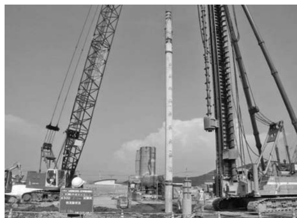
写真一 3 PHC 杭沈設状況
