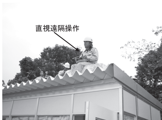
写真一 4 直視遠隔操作
