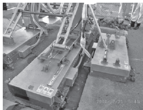
写真—5 加熱状況
