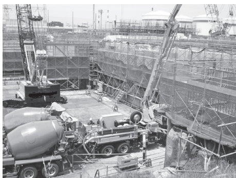
写真－7 打設状況
