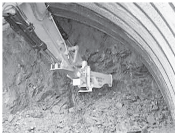
写真ー3 トンネル坑口、縦型 SS-box
