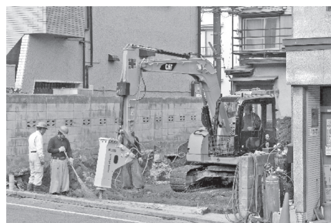
住宅隣接地での基礎解体
