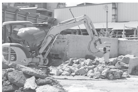
廃コンクリート解体
