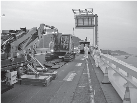
写真－11 広島呉道路／広島大橋施工
