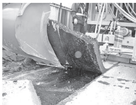
写真—6 剥ぎ取り状況
