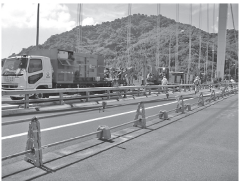
写真－12 しまなみ海道／伯方・大島大橋施工
