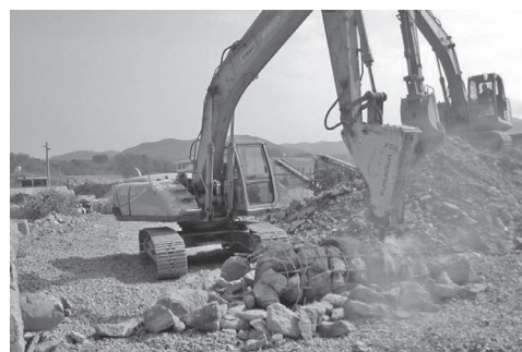
廃コンクリートガラ解体
