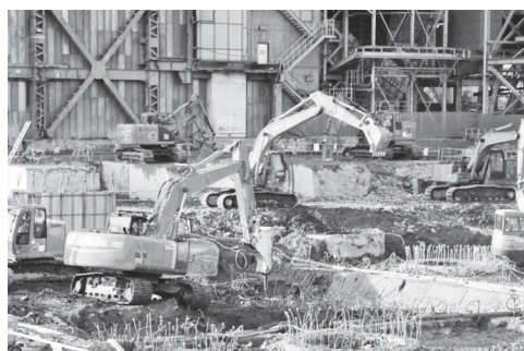
大規模設備の基礎解体
