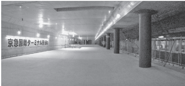
写真-28 躯体構築完了 (B2F；軌道階ホーム部)
