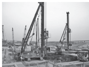
写真—8 地盤改良工（SDM-Dy）
