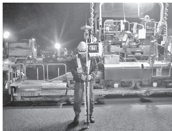
写真一 2 敷き均し高さ確認状況
