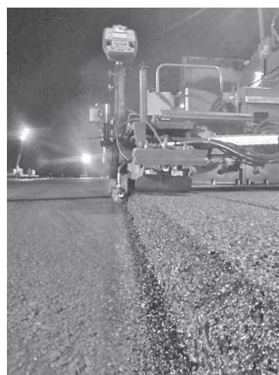
写真-6 無型枠施工装置施工状況②
