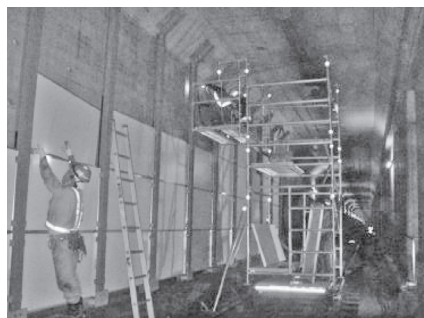
写真一 18 列車防護柵組立状況 (パネル設置)
