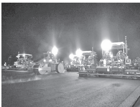
写真一 1 施工状況
