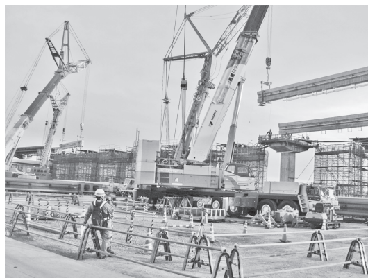
写真—2 PC 軌道桁の架設状況（羽田空港方）
