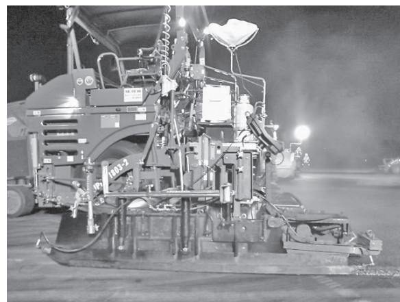
写真-5 無型枠施工装置施工状況①
