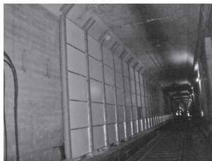
写真一 20 列車防護柵組立完了全景
