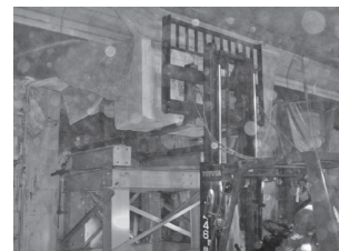
写真—23 切断ブロック荷取状況 （10tフォークリフト）
