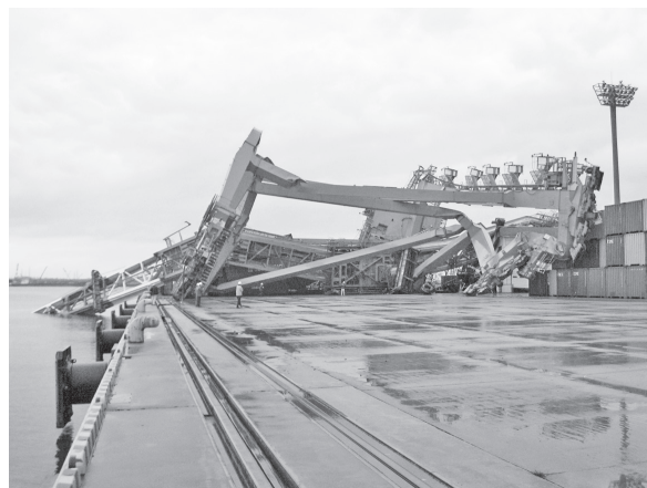
写真—7 コンテナクレーンの逸走事故
