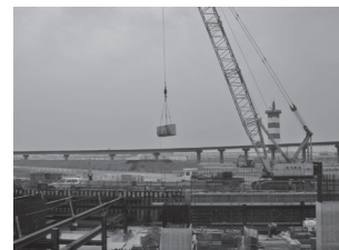
写真—25 切断ブロック荷揚げ 状況（地上部）
