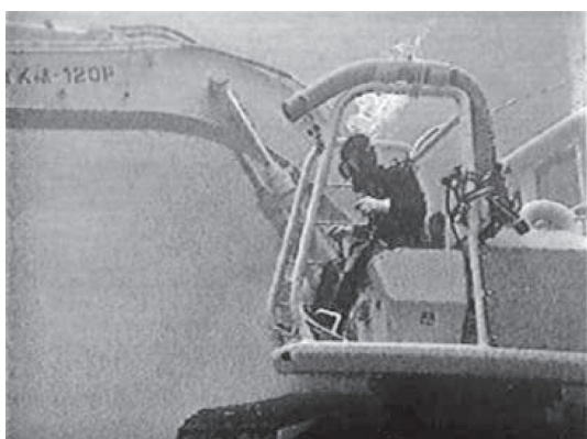
写真—2 潜水士搭乗時の施工状況
