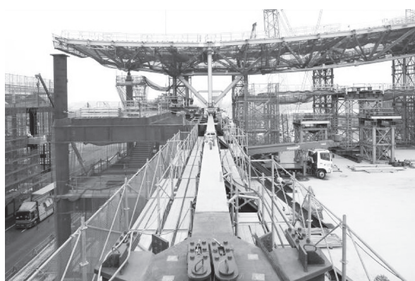
写真—10 牽引装置 (尻手)
