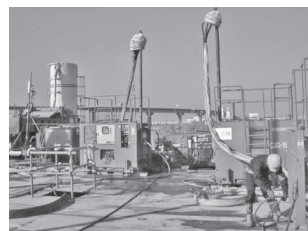
写真—9 地盤改良工（CJG）
