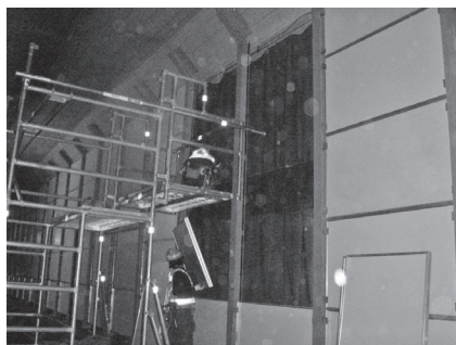
写真一 19 列車防護柵組立状況 (防護シート設置)
