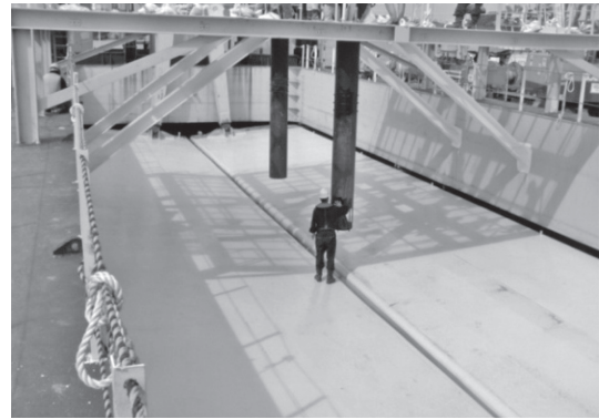
写真一2 フレームおよびシャッター
