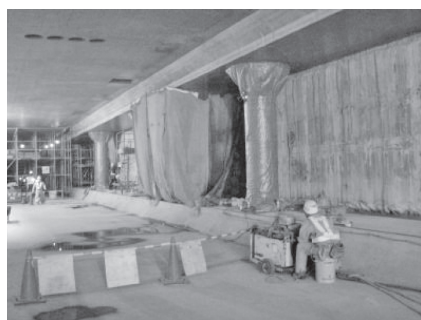
写真—21 ワイヤーソー切断状況
