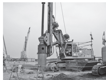
写真一 5 障害物撤去（BG 機掘削）
