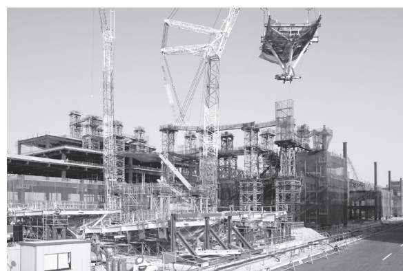
写真—5 クレーン配置と建方状況
