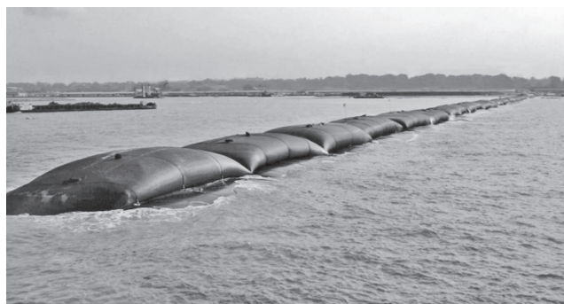
写真—1 ジオバンド施工完了時
