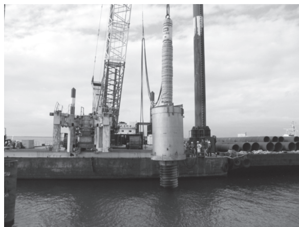
写真ー1 施工状況（鋼管杭打設）
