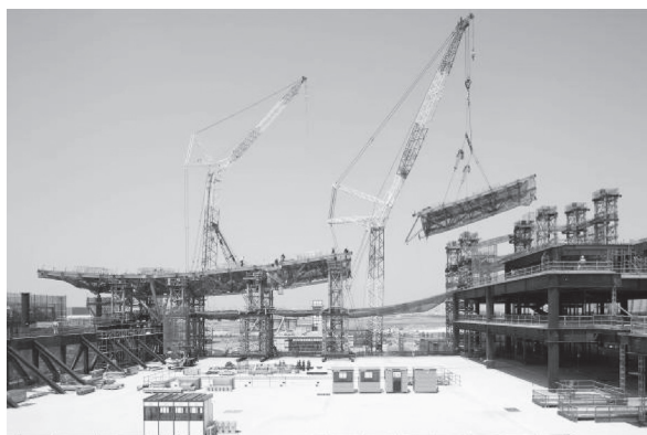
写真—7 トラス鉄骨建方
