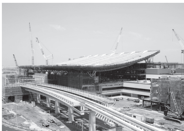
写真一 施工中のターミナルビル全景
