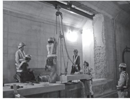
写真-27 プレキャストホーム床版設置状況 (狹隘部；人力架設)
