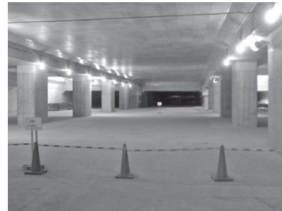
写真-29 躯体構築完了 (B1F；機械室部)
