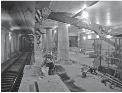
写真-26 プレキャストホーム床版設置状況 (一般部；クレーン架設)
