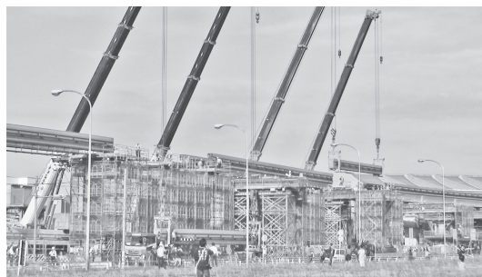
写真—1 既設 PC 軌道桁の撤去状況（浜松町方）
