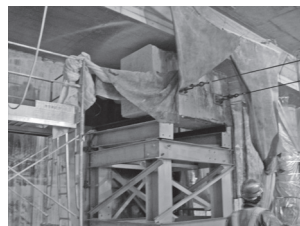
写真—22 切断ブロック引出し状況
