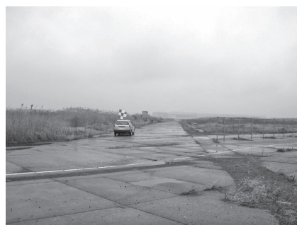
写真二 地上部全景（着工前）
