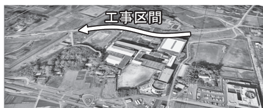
写真—1 施工場所全景
