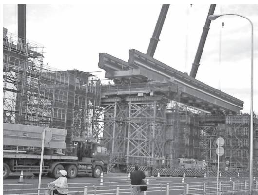
写真—3 既設合成軌道桁の撤去状況（浜松町方）
