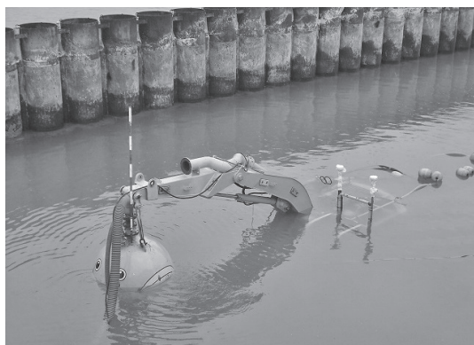
写真一八 水中バックホウ遠隔操縦状況
