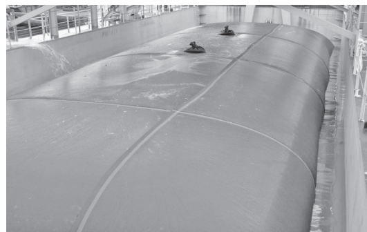
写真—11 充填が完了したジオチューブ
