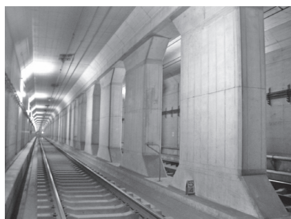
写真一 既設トンネル（着工前）
