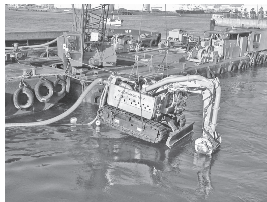
写真—5 水中バックホウ投入状況
