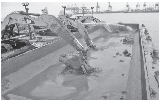
写真—9 解泥・攪拌作業
