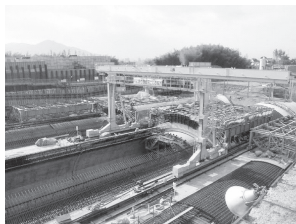
写真—7 橋型クレーン
