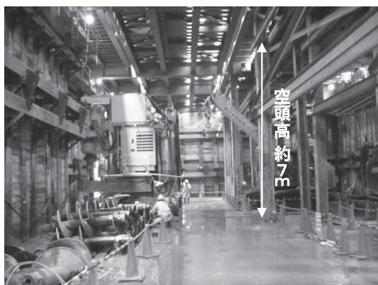
写真二 2 SMW 機路下作業状況
