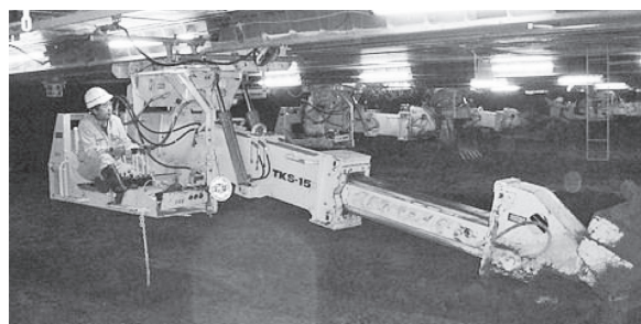
写真一3 有人掘削状況
