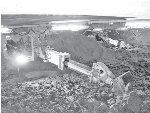
写真—8 沈下掘削状況（有人掘削）
