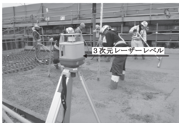
写真—6 函体コンクリート頂版仕上状況
