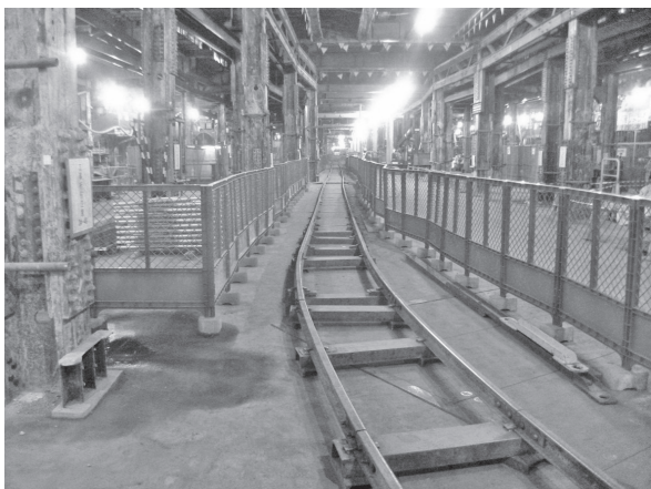
写真一5 軌条設備設置状況
