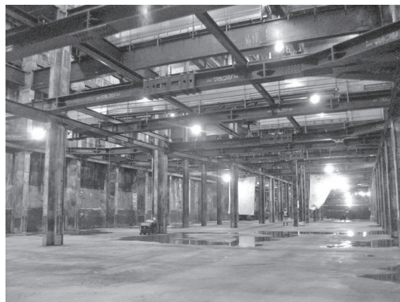
写真一6 掘削完了状況
