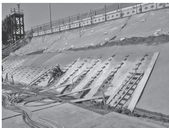
写真—2 薬液注入状況
