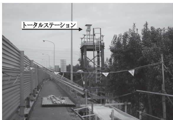
写真—7 自動路面計測
