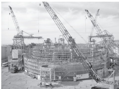
写真一3 沈下掘削状況
