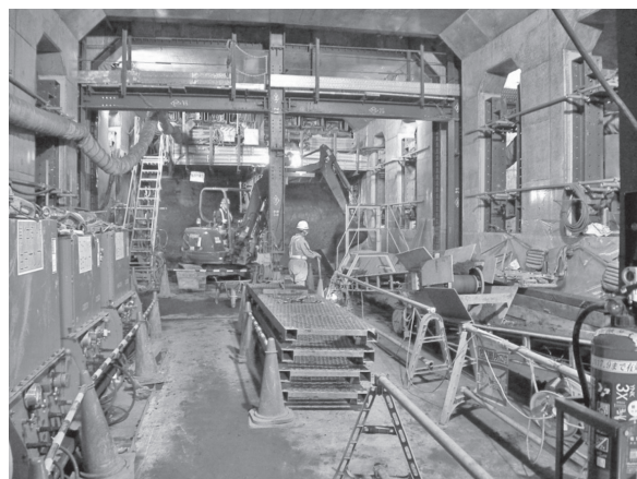
写真—8 函体推進状況（夜間）
