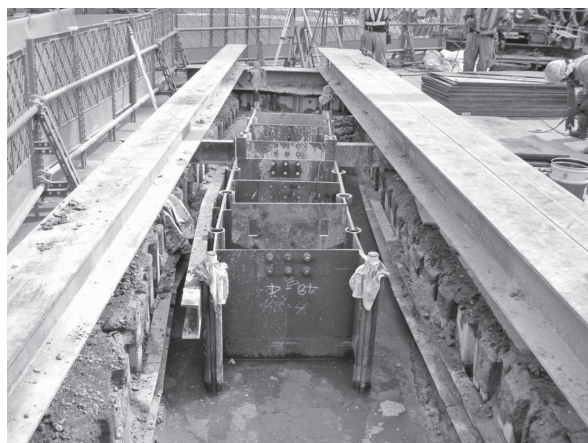
図ー8 ソイルセメント鋼製地中連続壁施工状況
