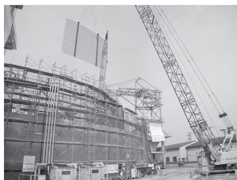
写真2 ひび割れ制御鉄筋建込み状況
