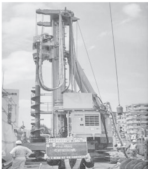
写真一 1 SMW 機路上作業状況
