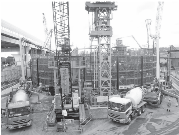
写真—7 第3ロットコンクリート打設状況
