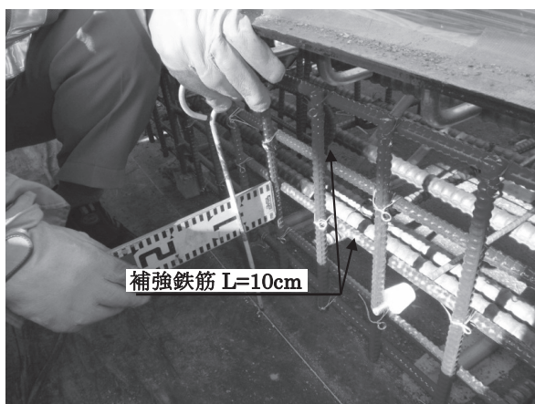
写真—3 補強鉄筋配置状況
