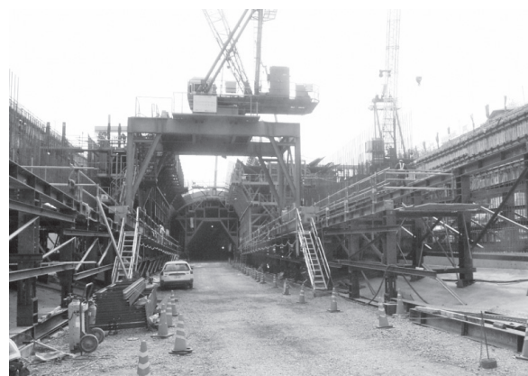
写真—6 ジブクレーン・クレーン台車
