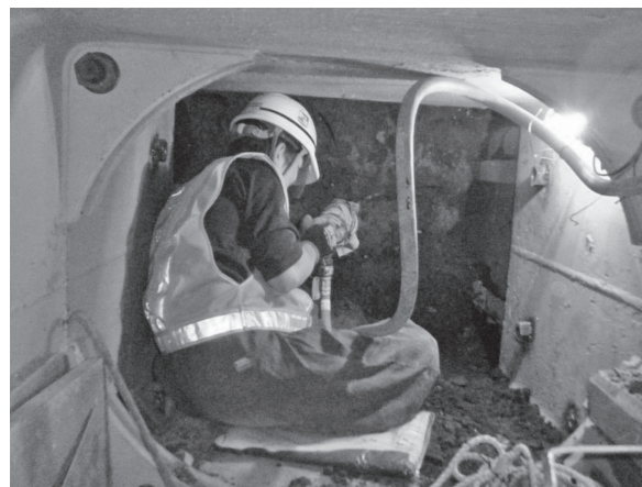
写真—4 箱形ルーフ内掘削状況
