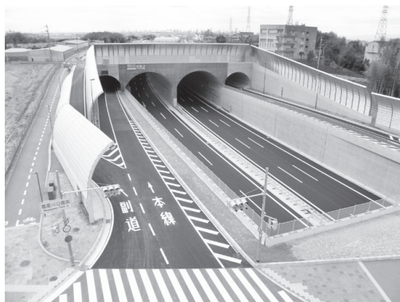
写真一10 完成写真
