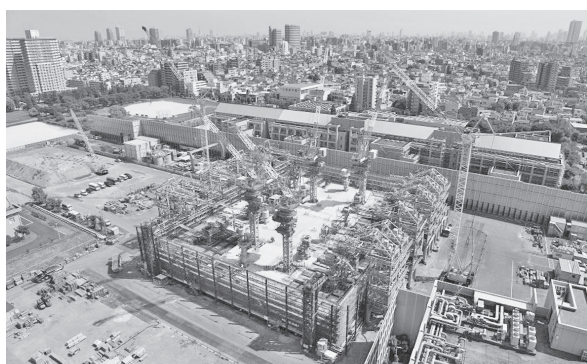
写真一2 ケーソン掘削状況
