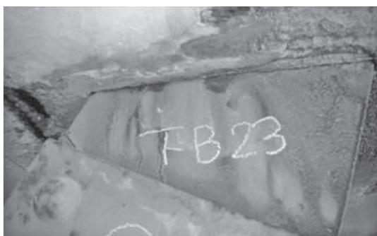
写真二 コンクリート部材の中での局所的な腐食
