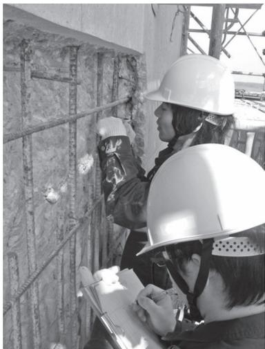
写真—4 塩害橋脚の鋼材腐食状況調査（瀬底大橋）
