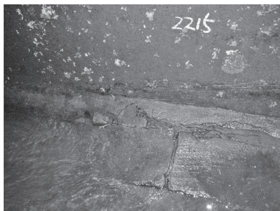
写真一1 インバートの浮上り
