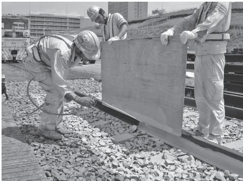
写真-2 人力による塗布施工例
