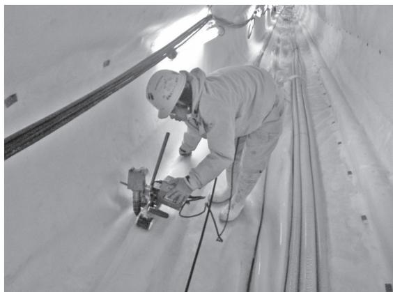
写真一7 遮水シート溶着状況
