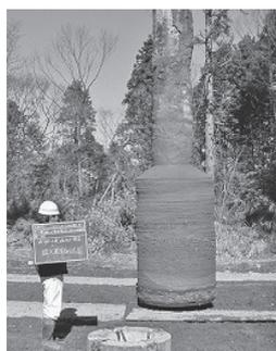
写真—2 拡大根固め球根
