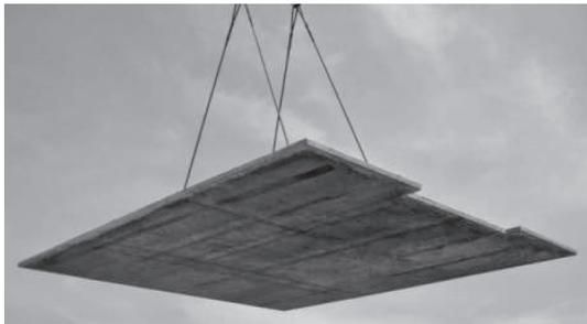
写真二 長寿命化コンクリートプレキャスト埋設型枠の運搬
