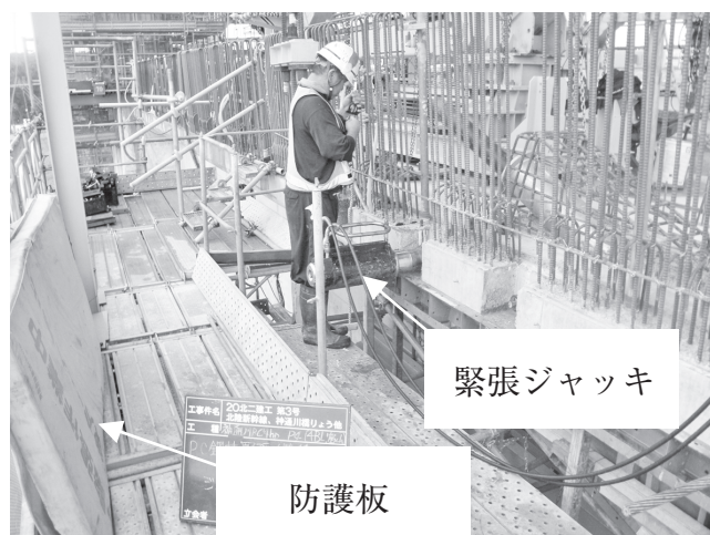
写真—14 緊張ジャッキセット状況
