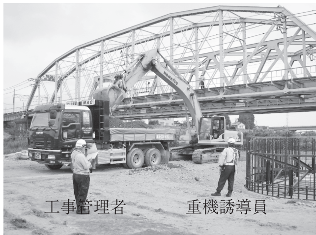
写真—3 工事管理者・重機誘導員配置状況
