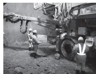
写真―13 前方探査ボーリング
