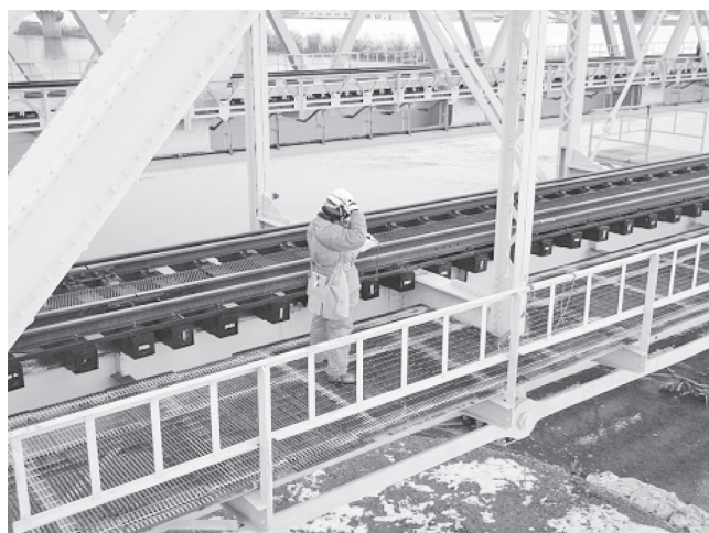
写真—2 列車見張り員配置状況
