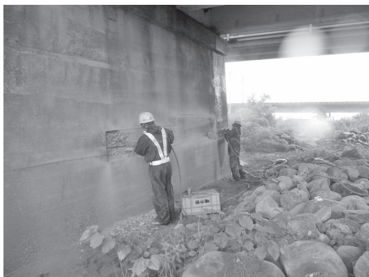
写真—1 境橋 下部工はつり作業
