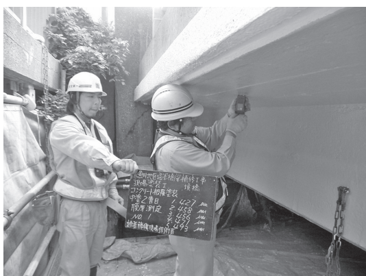
写真—3 境橋 現場塗装工段階確認
