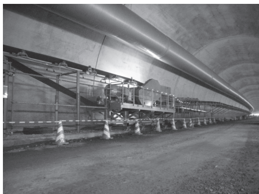
写真—12 中間ブースター安全通路
