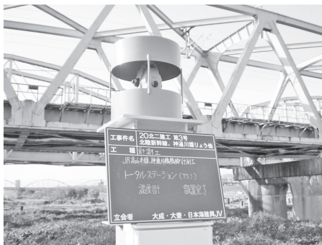
写真—4 トータルステーション設置状況
