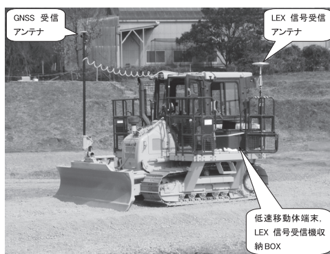
写真—1 実証試験用ブルドーザ
