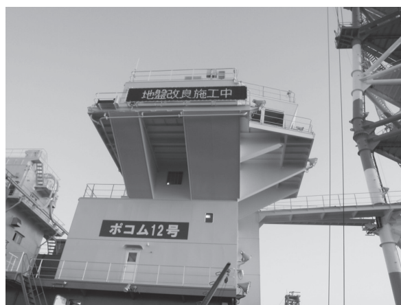
写真-13 電光掲示板と全方位視野確保型操作室
