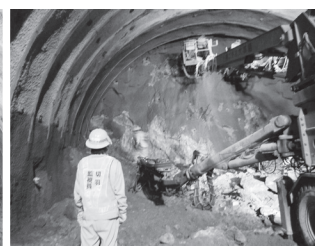
写真―12 切羽監視状況
