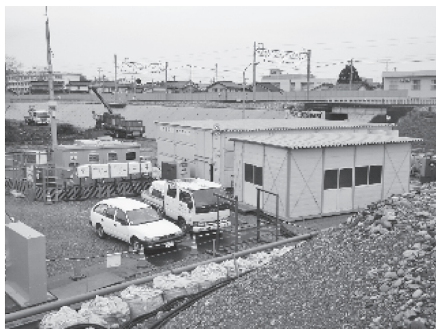
写真—12 防音ハウス
