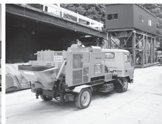
写真—6 電動コンクリートポンプ
