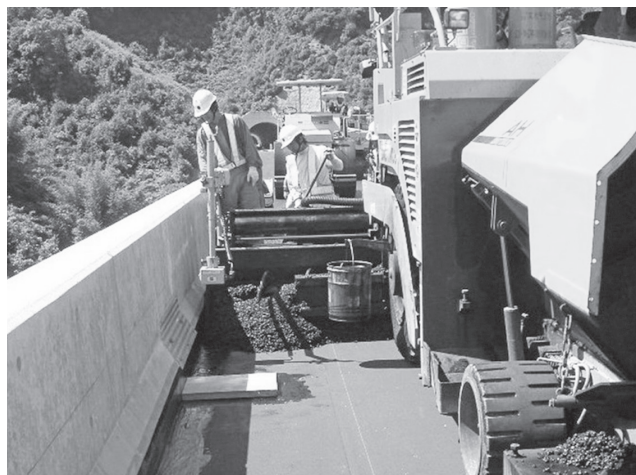
写真一２ ラインリーダによる施工状況
