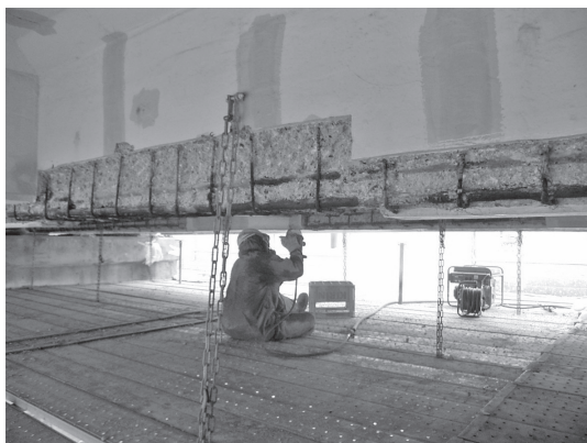
写真—2 境橋 上部工はつり作業
