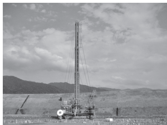
写真-1 PBDの施工状況
