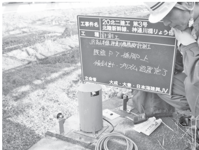
写真—5 プリズム・傾斜計設置状況
