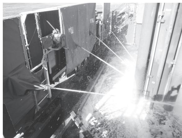
写真—9 遠隔放水銃
