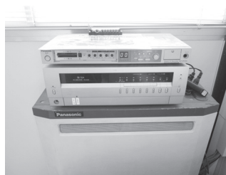
写真—14 坑内放送設備
