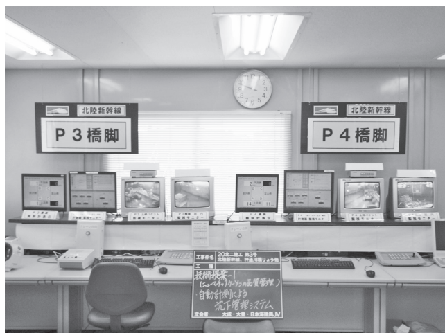
写真—9 中央監視室（無人掘削機操作箇所）
