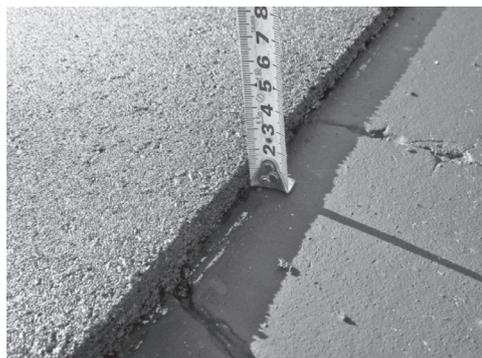
写真-3 平均施工厚さ15mm
