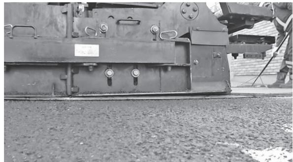
写真-2 薄層施工状況
