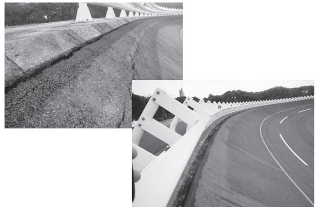
写真一1 バンク上端部損傷
