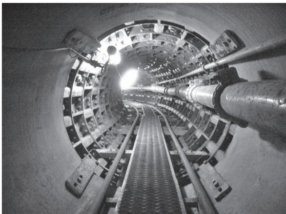
写真一 推進管・セグメント切替部
