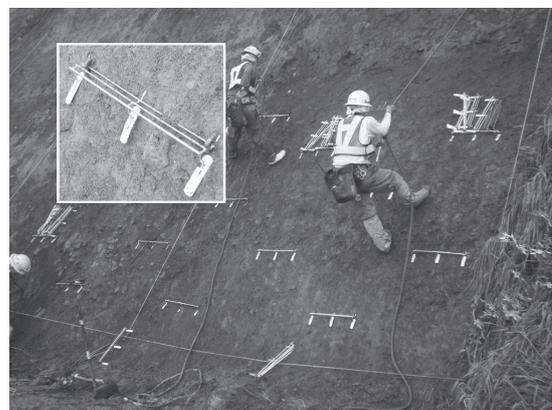
写真-3 基盤キャッチャーの設置状況
