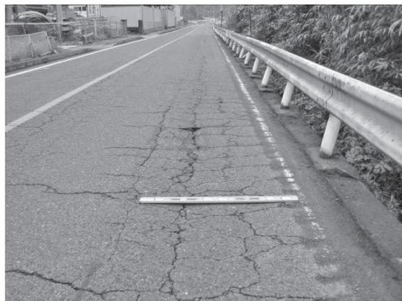
写真—5 施工前の路面状態
