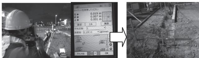
図-7 出来形管理用TSを用いた丁張り設置状況
