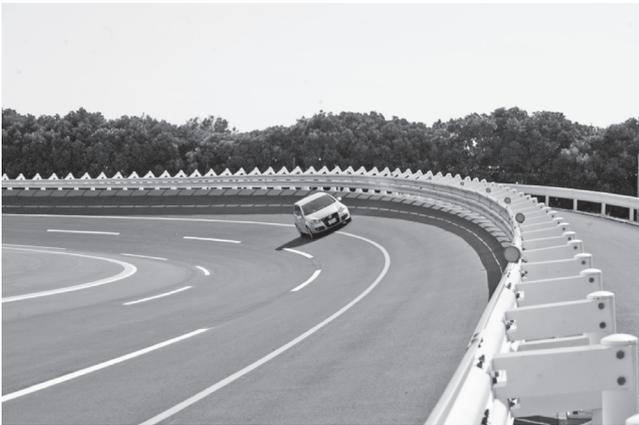
写真一五 完成した旋回傾斜路（大バンク）を試走
