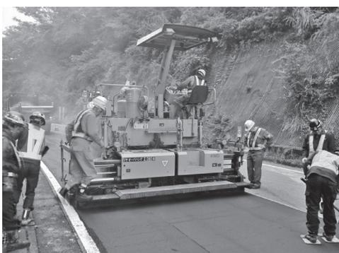
写真—9 アスファルトフィニッシャーによる敷均し
