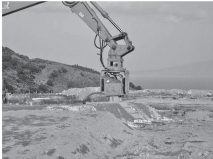
写真一七 特殊振動締固め機械
