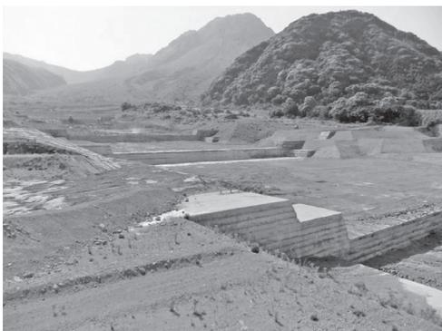
写真一2 RCC工法による床固工
