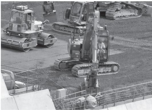
図一 14 端部法面締固め実施状況
