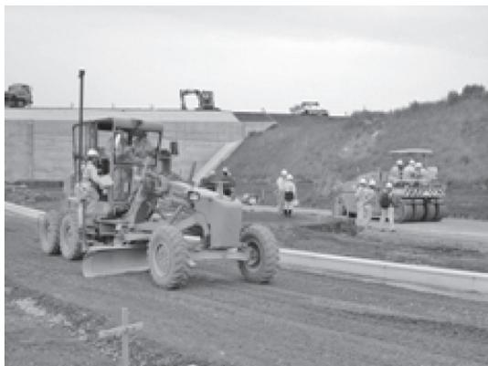
写真—1 MC モータグレーダと GNSS 締固め管理技術
