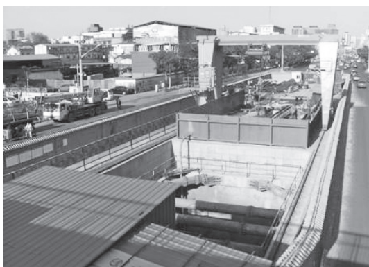
写真—5 プライムホテル付近で建設中の地下鉄工事現場
