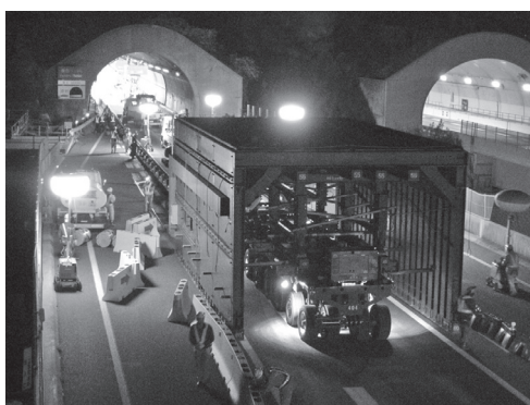
写真—3 多軸台車運搬・据付け状況
