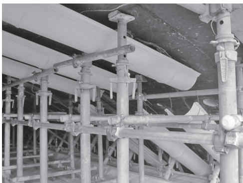
写真—4 ミドルサポート設置状況
