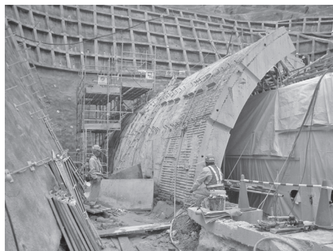
写真—8 縦切り状況
