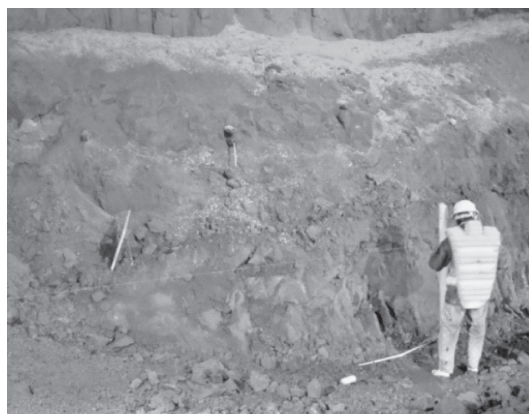
写真一 3 水系による掘削高さ確認状況
