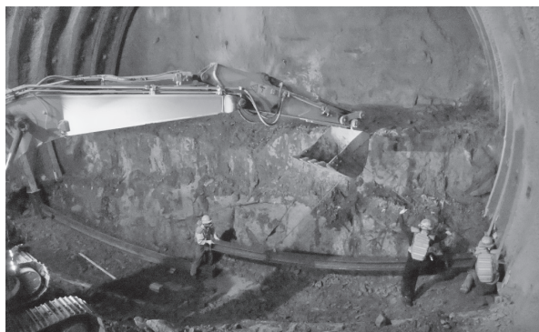
写真一2 鋼製ストラット設置状況
