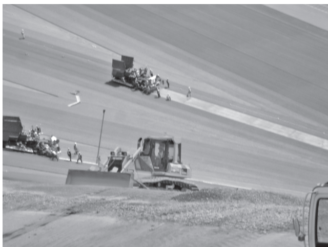
写真一 上層路盤の施工状況 (3D-MC システムを搭載したブルドーザ)
