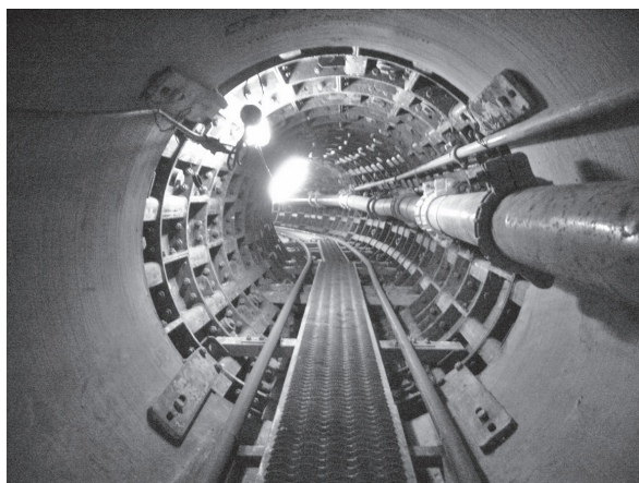
写真—1 推進工法とシールド工法の切替状況
