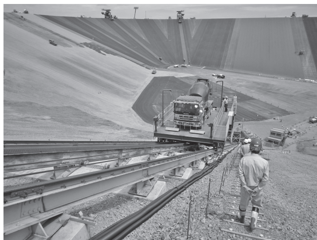
写真一 インクラインによる輸送状況
