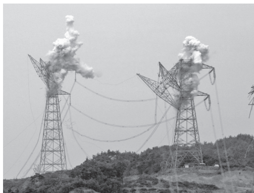
写真—4 災害を受けた送電線鉄塔の復旧工事
