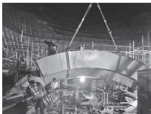
写真—9 吊り出し状況
