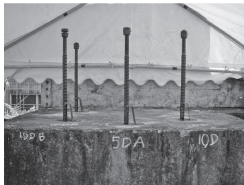
写真一3 試験に用いたアンカーボルト（躯体1）
