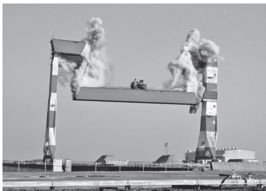
写真—3 大型クレーンの発破解体事例
