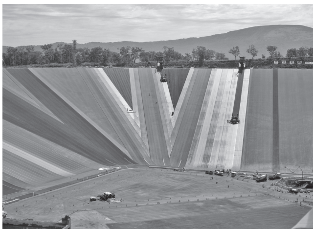
写真一 斜面部の施工状況
