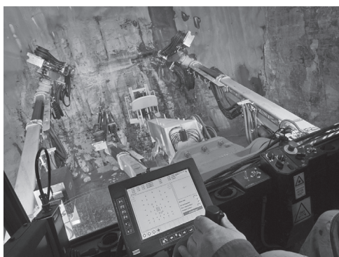
写真—5 RCS ドリルジャンボの操作状況
