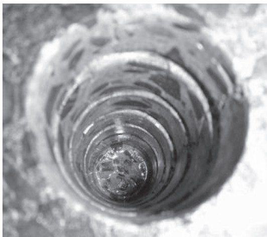
写真一2 溝切削孔後の孔内
