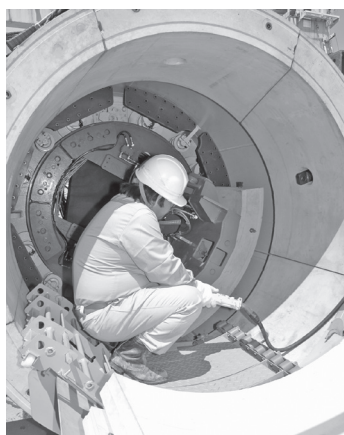
写真—2 セグメント組立状況
