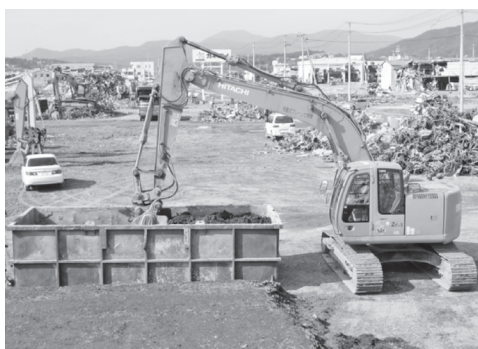
図一19 気仙沼市における再資源化施工の様子
