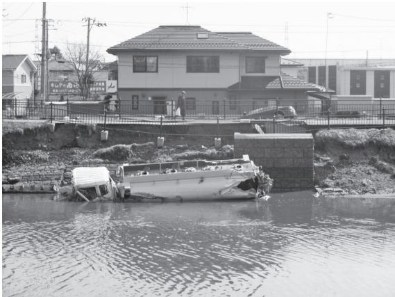
写真― 10 タンクローリー 流された残骸
