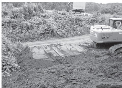
図-7 ショベルによる改良土の転圧
