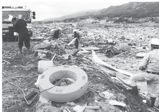
写真—6 人力による設置状況
