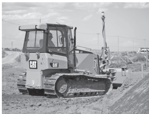
図—13 津波堆積物の剥ぎ取りに用いたブルドーザ（D3K）
