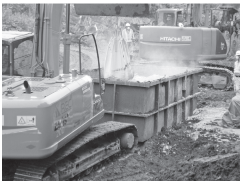
図-6 セメント系固化材の添加
