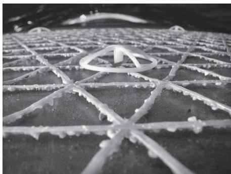
写真—1 アラミド三軸メッシュシートの配置状況
