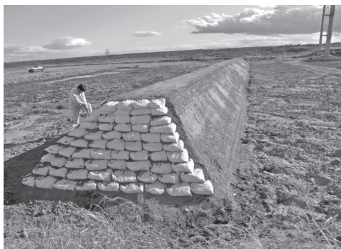
図一 15 施工後の現場の様子（仙台市若林区藤塚）
