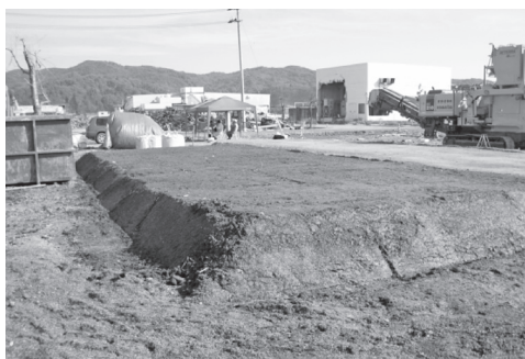
図一20 地盤沈下箇所を嵩上げするために造成した人工地盤
