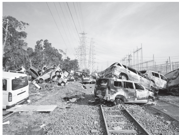
写真一7 仙台港 臨海鉄道の線路上
