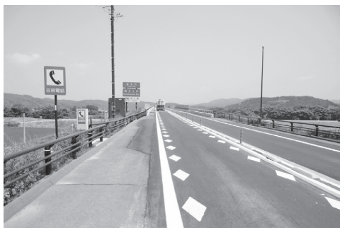
写真—12 日高見橋 (A1 橋台)
