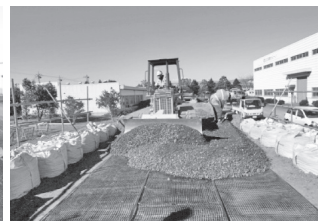
②粒状材の施工
