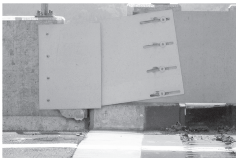
写真—13 新米谷橋 (A2 橋台)
