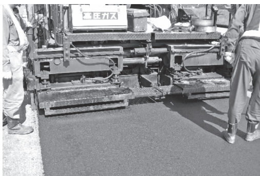
写真-5 敷きならし・締固め (スクリード)
