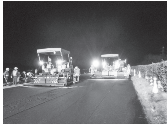
写真—9 アスファルト舗装工
