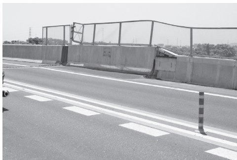
写真—10 天王橋 (A2 橋台)
