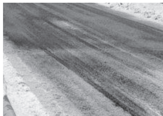
写真-9 物理系凍結抑制舗装の冬期路面
