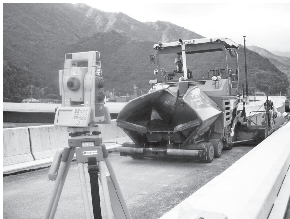
写真—5 片リフト・片スロープ方式で舗装中のAF
