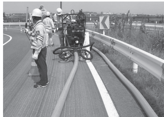
写真-6 グルーピング施工状況
