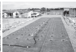
⑥施工完了
