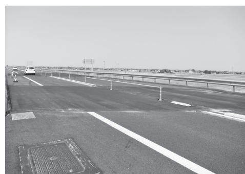
写真—7 鐙川橋周辺すり付け補修状況
