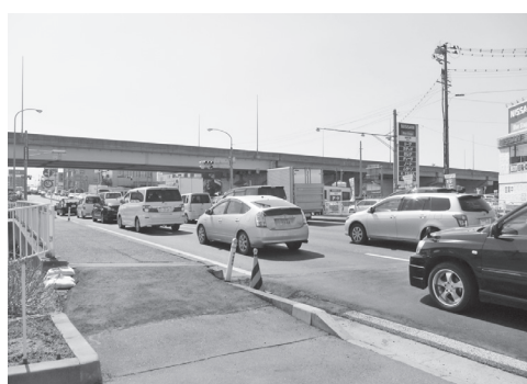
写真—5 橋台土工部側の段差補修状況
