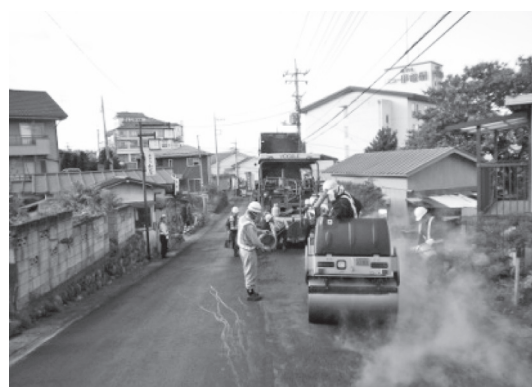
写真一3 施工状況
