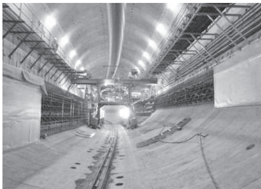
写真—1 床版受部の構築状況（中央環状品川線）
