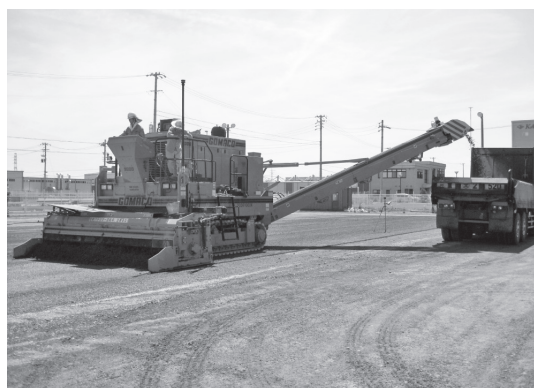
写真―4 施工状況
