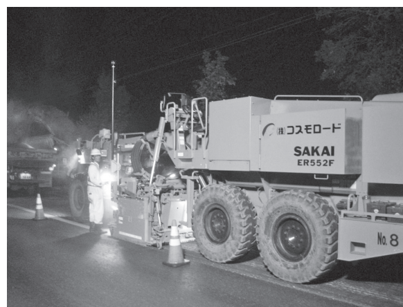
写真一〇 3D-MC で切削作業中のタイヤ式 RP
