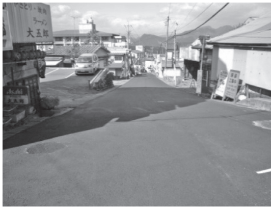
写真-4 施工完了
