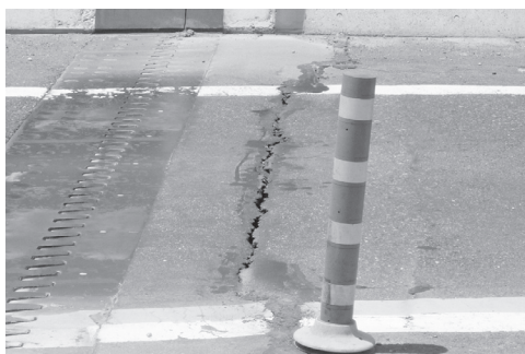
写真—11 稲荷橋 (A2 橋台)
