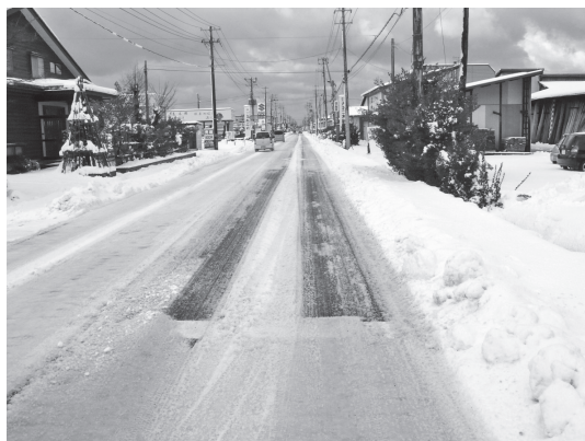
写真—10 物理化学系凍結抑制の舗装の冬期路面
