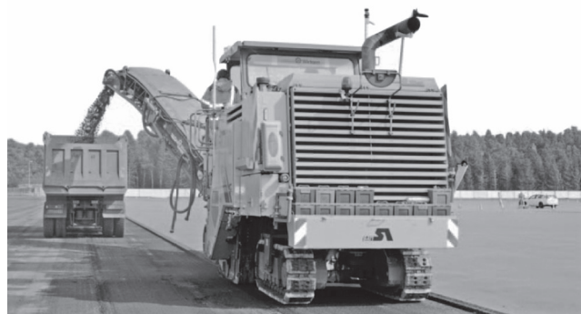
写真一 作業に使用したクローラ式大型路面切削機（施工幅 2.2 m）
