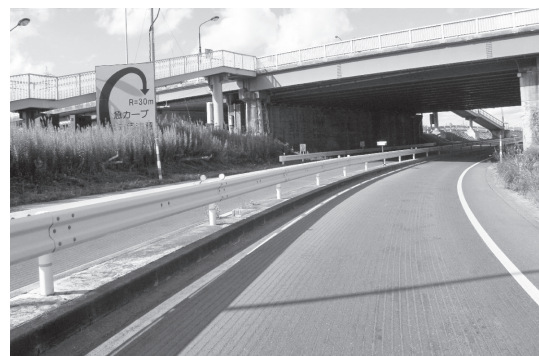
写真-8 施工完了
