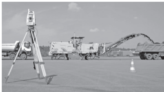
写真一2 トータルステーションによる路面切削機3D制御の状況
