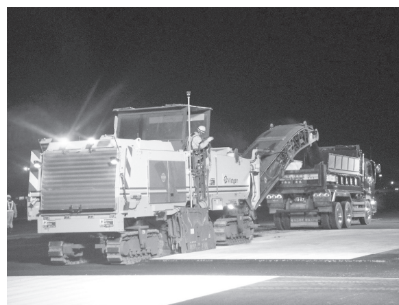
写真一九 3D-MC で切削作業中のクローラ式 RP
