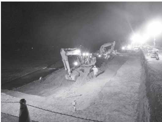
写真—6 土砂撤去・仮置き（夜間作業）
