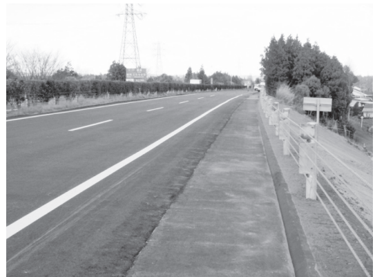
写真—10 復旧完了
