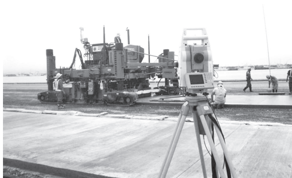
写真一八 3D-MC で舗設を行う CSP
