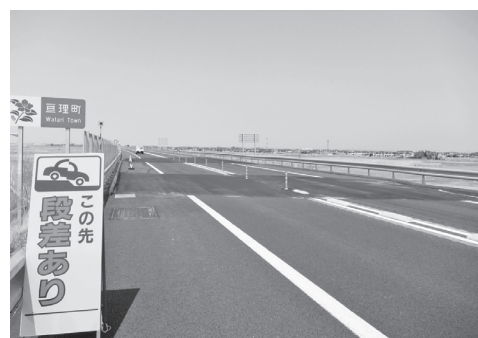
写真—8 鐙川橋周辺すり付け補修状況
