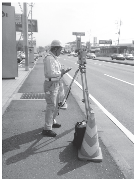
写真—2 計測作業風景
