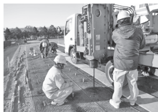
③拘束部材の打込み
