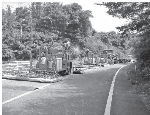
写真—7 小型ヒータ車による路面加熱状況
