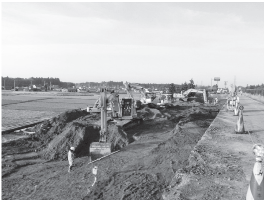
写真—5 土砂撤去・仮置き
