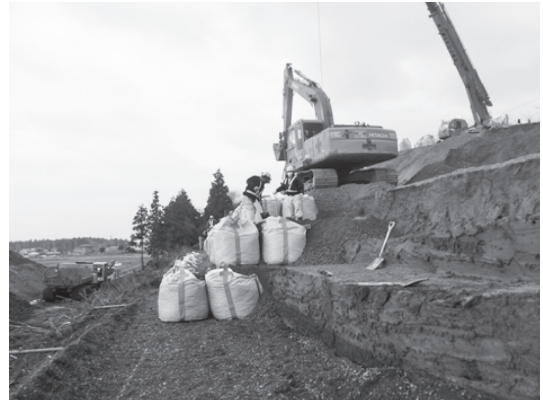
写真—8 大型土嚢設置
