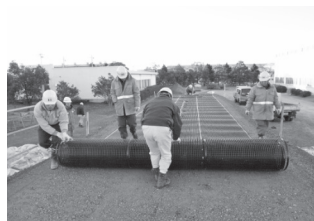
①面状補強材の敷設
