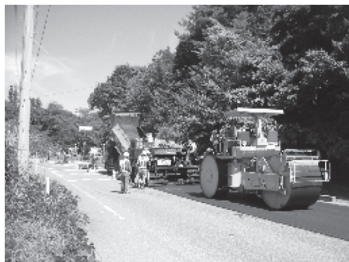
写真—8 敷きならし・転圧状況
