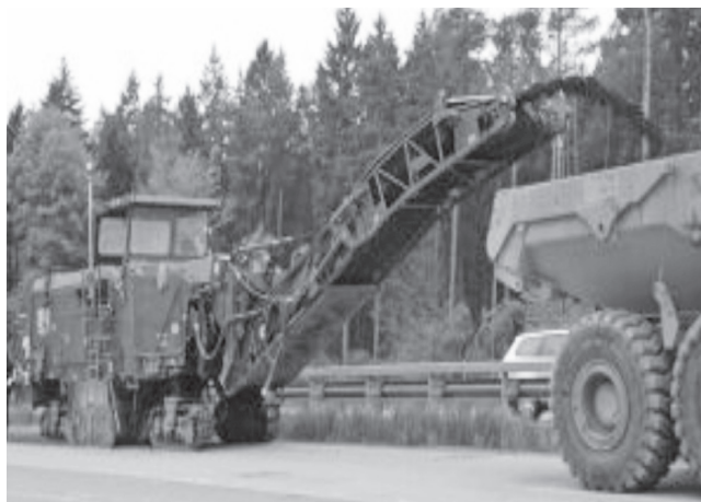
写真一五 高速道路1号線施工状況
