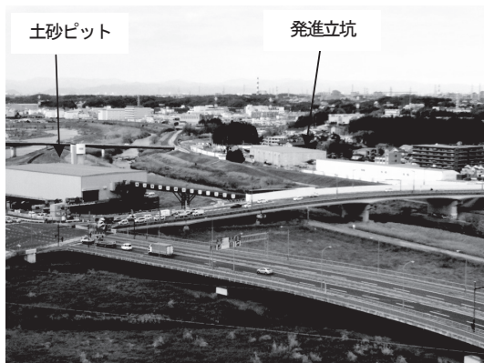
写真—3 土砂ピット（左）と発進立坑（奥）
