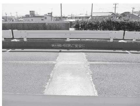
写真—4 亀田大橋伸縮装置緊急補修状況
