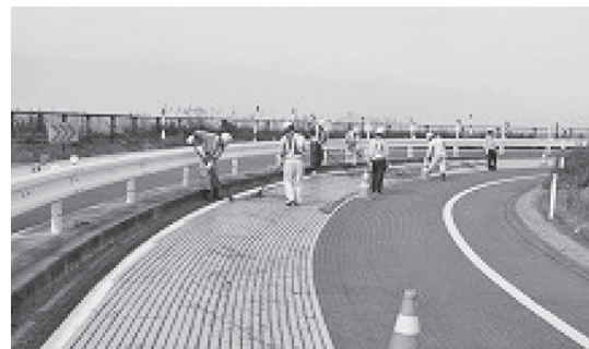
写真-7 凍結抑制材充填状況
