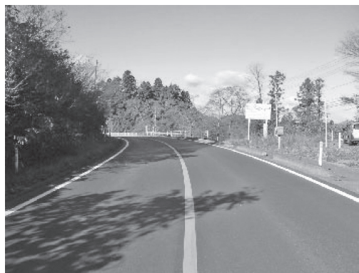
写真—11 路面状況（施工後）
