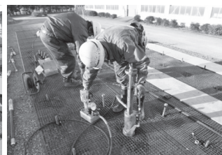
④拘束部材先端部の拡張
