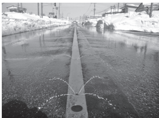
写真—1 散水消雪施設の消雪状況
