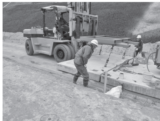
図一11 リフトによる運搬・据付作業状況
