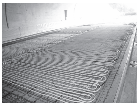
写真—3 放熱管敷設状況
