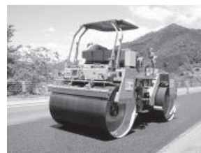
写真 7-12 鹿島道路(株) 酒井重工業 SW750B 改
