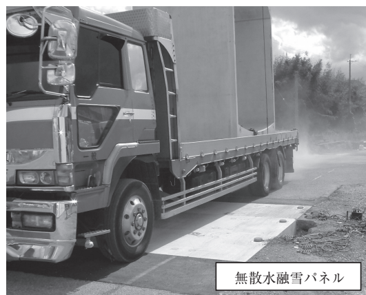
図一5 車両走行によるせん断キーの効果確認実験状況
