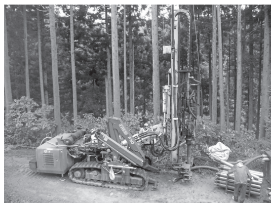
写真—1 ボーリングマシン (150 kW 級)
