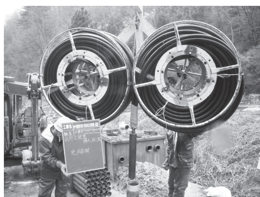
写真—2 ポリエチレン管挿入状況
