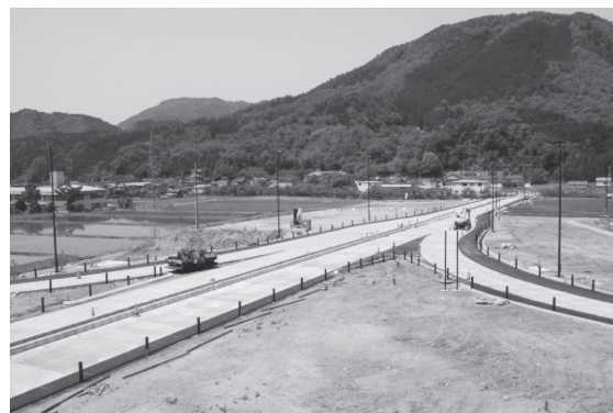
図一12 無散水融雪パネルの据付完了時の状況
