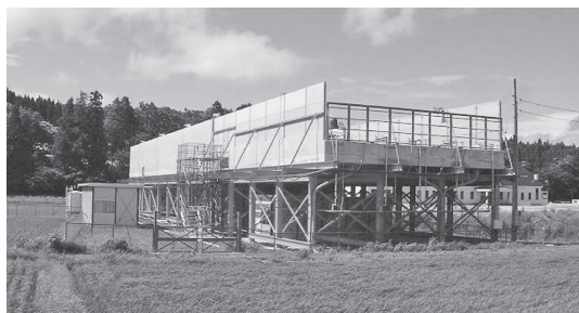
写真一 七戸消雪試験場全景
