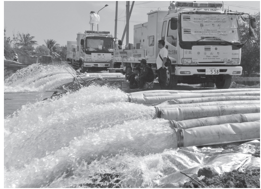
写真—5 排水状況
