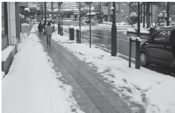
図一3 セット融雪工法の融雪状況
