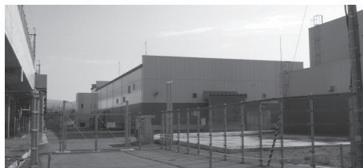
写真-5 金浜消雪基地外観
