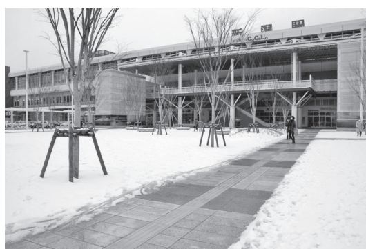
写真—5 地中熱ヒートパイプ方式の融雪状況
