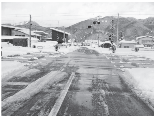
写真—5 融雪状況（踏切）
