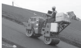
写真 7-55 鹿島道路(株) 酒井重工業 SW250 改
