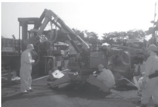
写真—4 BROKK330D の除染作業
