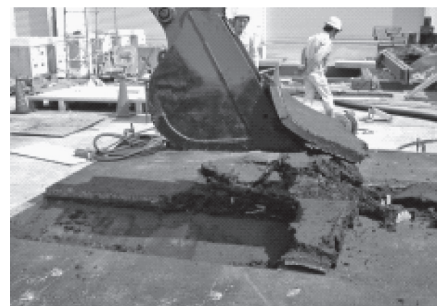
図一十一 舗装剥離状況
