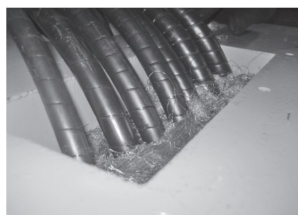
写真－5 配管・配線の貫通部遮蔽(鉛毛を充填)
