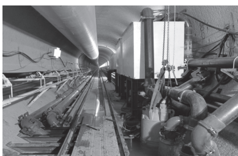
写真—14 TBM-1 坑内排水設備
