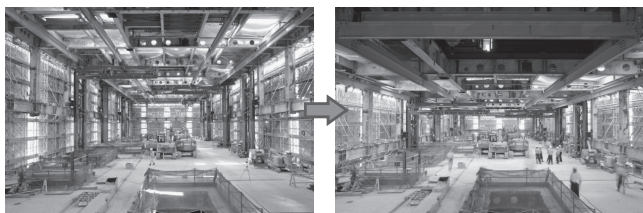
図一 11 テコレップシステム内観 左：ジャッキダウン前，右：ジャッキダウン後
