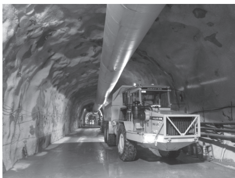
写真—13 坑内拡幅部とインパート仮舗装
