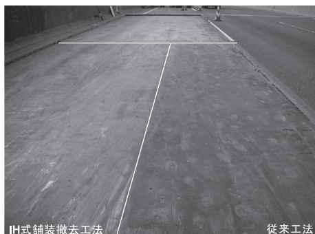
図—15 舗装撤去完了状況の比較
