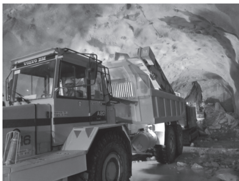
写真—12 ズリ出し状況（シャフローダー KL41, 20t ダンプトラック）
