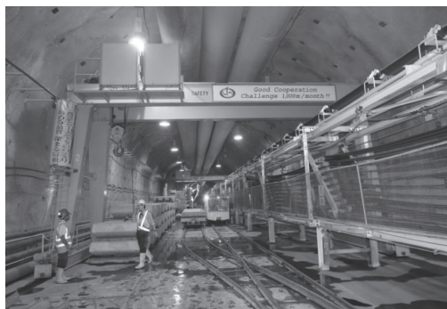
写真－2 TBM 発進基地
