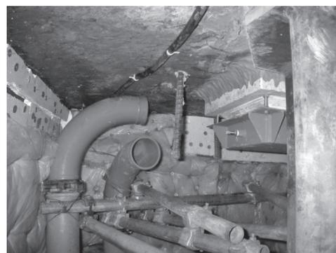
写真一七 コンクリート打込み用配管
