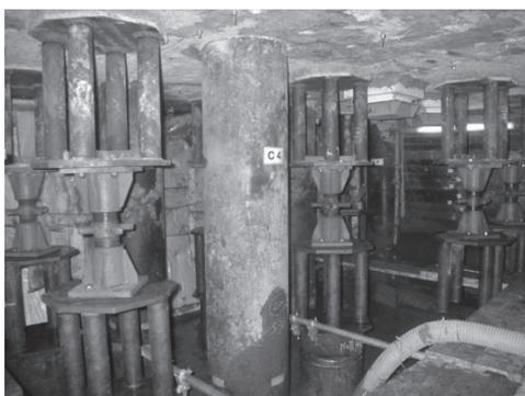
写真一六 鋼管杭打設・プレロード導入完了
