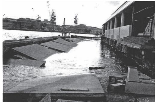
写真-3 埠頭南側岸壁の被害状況
