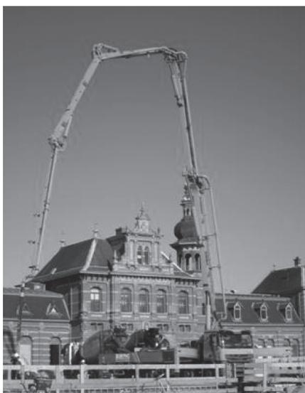
写真一八 デルフト駅舎前の工事現場で稼働中のコンクリートブーム付きポンプ車とトラックミキサ
