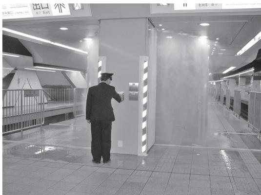
写真—6 地下駅ホーム階の階段下部に設置された本防火設備作動の様子
