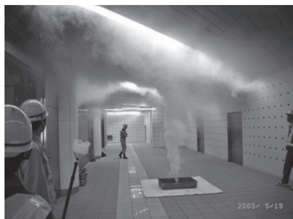
写真—3 コンコースでの発煙試験
