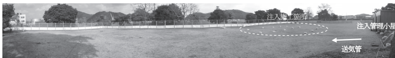
写真-4 空気注入状況 全景
