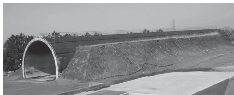
写真—9 模擬トンネルの全景
