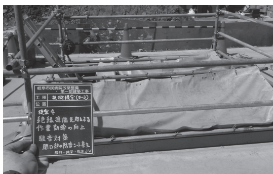
写真-8 防音シートによる開口部騒音対策
