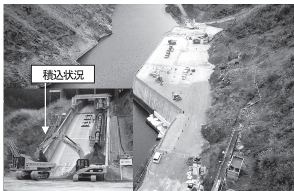
写真—10 CSG 施工状況
