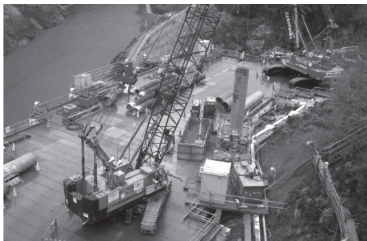
写真—12 全周回転式オールケーシング施工状況
