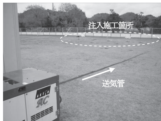
写真-3 空気注入状況
