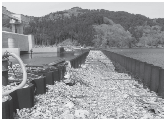
写真一 二重締切り内部
