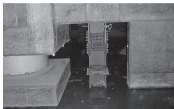
写真—4 仮設支柱・仮設壁による拘束状況
