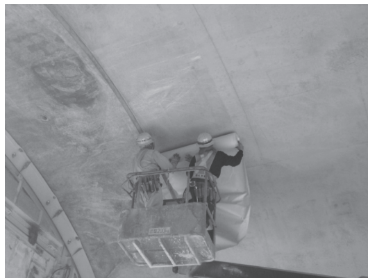
写真—2 施工状況
