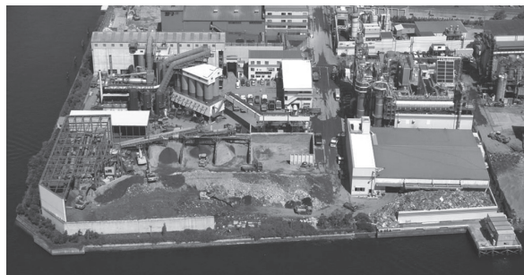
写真—1 工場全景
