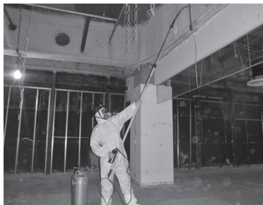
写真—7 高所への作業（伸縮式ロングノズル）
