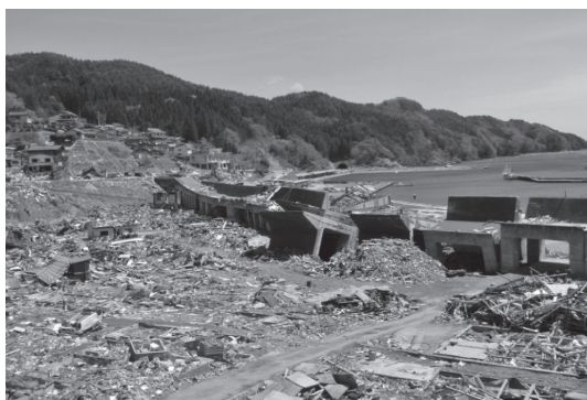
写真—1 津波により倒壊した防潮堤
