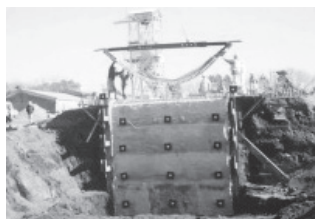
③鉄筋補強工の効果確認試験
