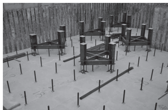
写真—3 仮設支柱設置状況
