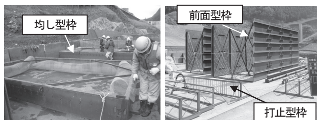
写真—5 使用型枠
