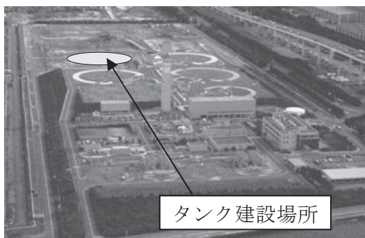
写真—1 建設現場全景
