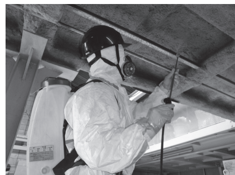
写真—4 施工箇所近傍での作業
