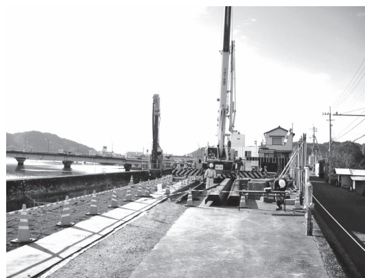
写真-5 鋼矢板圧入状況
