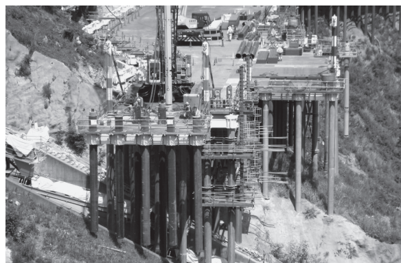
写真—11 LIBRA 工法施工状況
