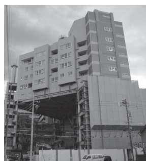
写真－1 西側全景（下部解体中）
