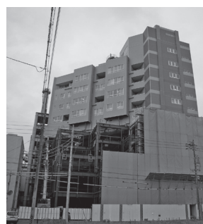
写真－2 西側全景（下部建方中）
