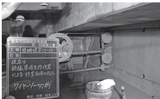
写真-7 ワイヤーソーでの仮設壁切断状況
