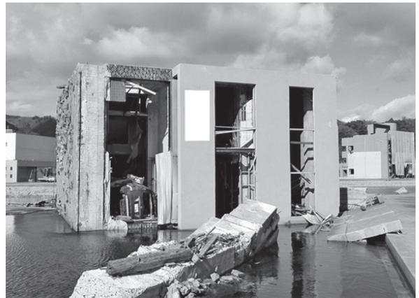
写真-1 建物の転倒被害例
