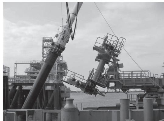
写真-5 油圧ハンマ打設状況
