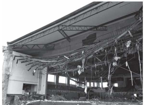
写真-2 鉄筋コンクリート壁の内部からの大規模崩壊
