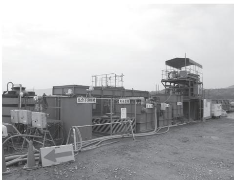
写真—16 濁水処理設備
