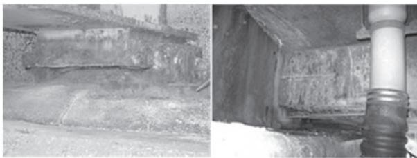
写真—8 伸縮装置からの漏水による桁端の損傷
