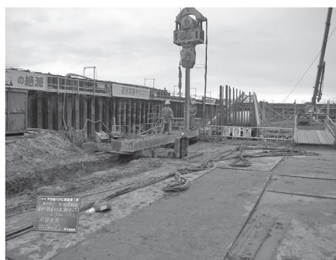
写真—6 遮水鋼矢板打設
