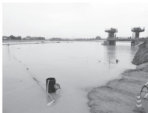
写真-14 仮締切内冠水状況
