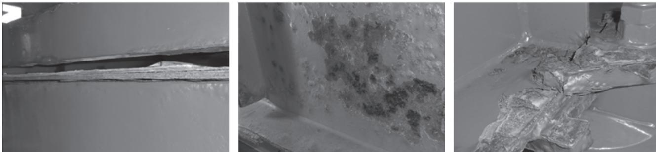
写真—1 塗装後数年して発見された不良工事 左：ウェッジの面取りをしていない，中：塗装時に十分にケレンしていなかった，右：さびの上から塗っていた
