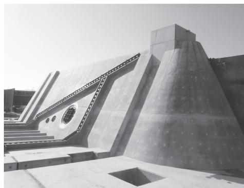
写真一8 堰柱コンクリート脱型後
