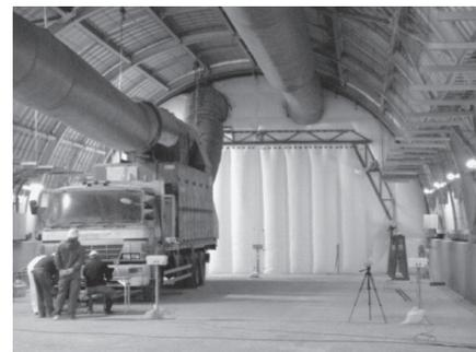
写真一3 隔離壁車両通行部 閉
