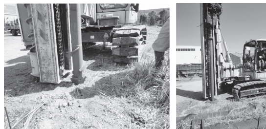
写真—1 ケーシング、先端ビット及び削孔状況
