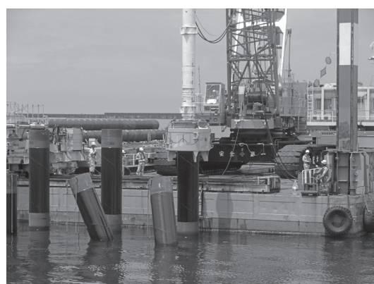
写真—4 低減装置付き油圧ハンマによる打設状況 (直江津)
