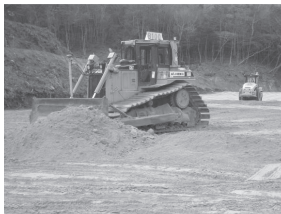
写真—4 B100 で稼働するブルドーザ
