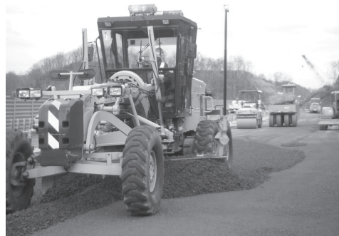
写真-1 ICT施工による車道路盤工数均し状況
