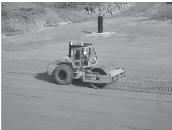
写真—5 B100 で稼働する振動ローラ
