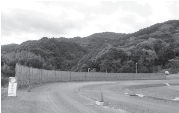
写真—16 防塵シート
