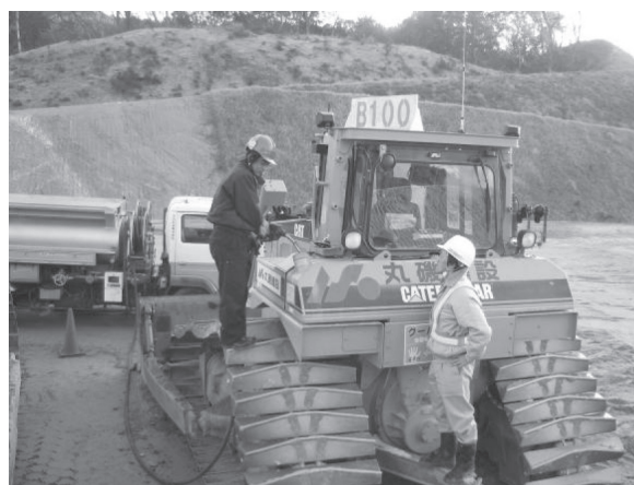
写真—3 B100 の給油状況
