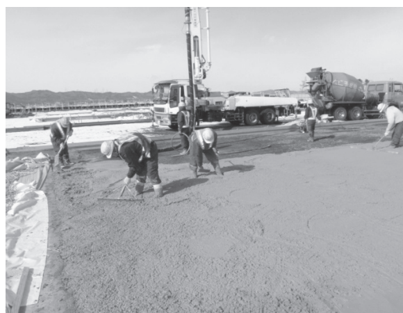
写真一2 打設状況
