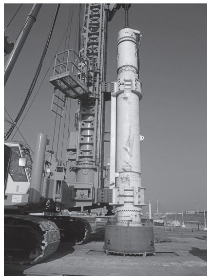
写真—5 装置なしの油圧ハンマ（本牧地区）
