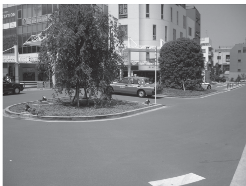
写真一 4 駅前ロータリーでの施工例
