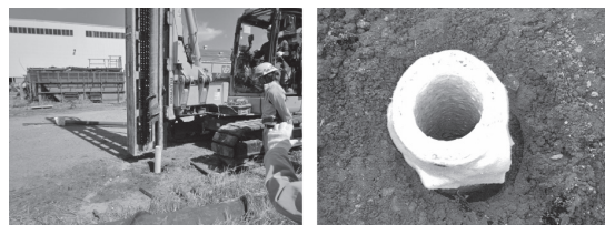
写真—2 ドレーン材の埋設完了状況
