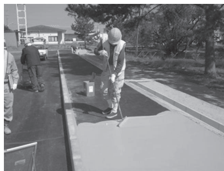
写真—2 遮熱性舗装の施工 (a) MMA系2液硬化型, (b) 水系1液型
