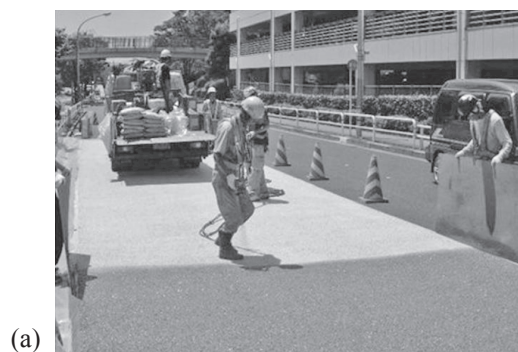
写真—2 遮熱性舗装の施工 (a) MMA系2液硬化型, (b) 水系1液型
