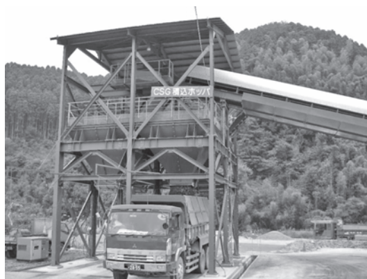
写真—3 積込ホッパからの積み込み状況
