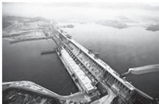
写真—1 三峡ダムの全景
