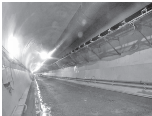
写真ー2 ベルコン設置(覆工完了部)
