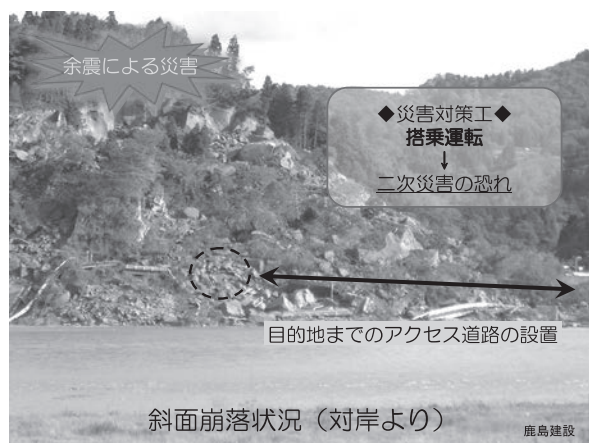
図—30 中越地震による斜面崩落状況
