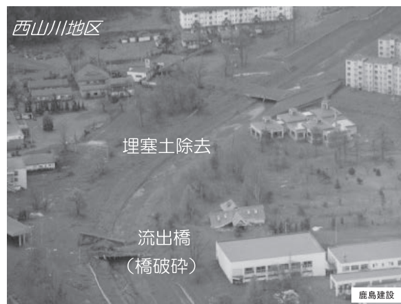
図—25 西山川地区の被災状況
