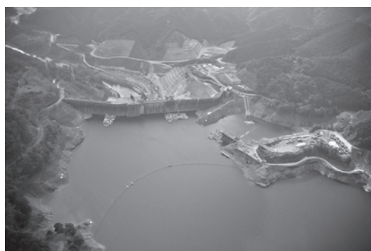
写真一 4 貯水池内の施工状況（平成 24 年 12 月）
