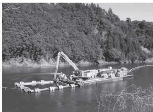
写真—1 浚渫台船
