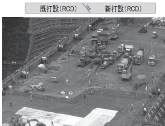
写真一 3 1:0.8 端部法面による打止め施工状況
