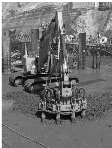
写真-3 コンクリート打設風景
