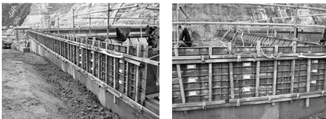
図ー4 ダム・コンクリート工事現場へのセンサ搭載型枠の試験導入事例
