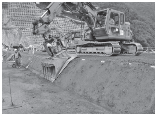
写真一 2 端部法面締固め状況
