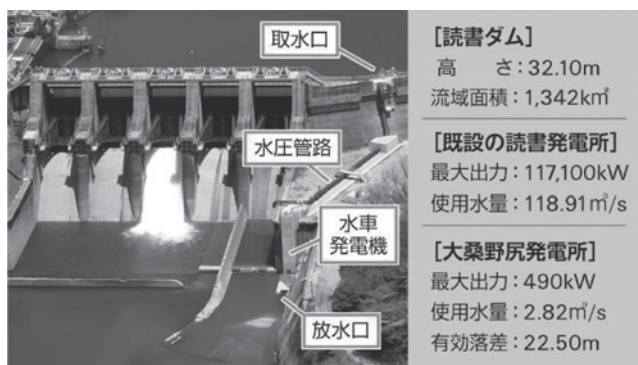
写真—1 大桑野尻発電所の概要
