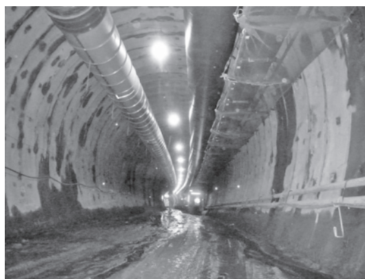
写真ー1 ベルコン設置(掘削完了部)
