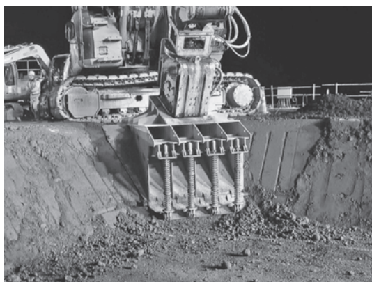
写真—6 入隅部の締め固め状況
