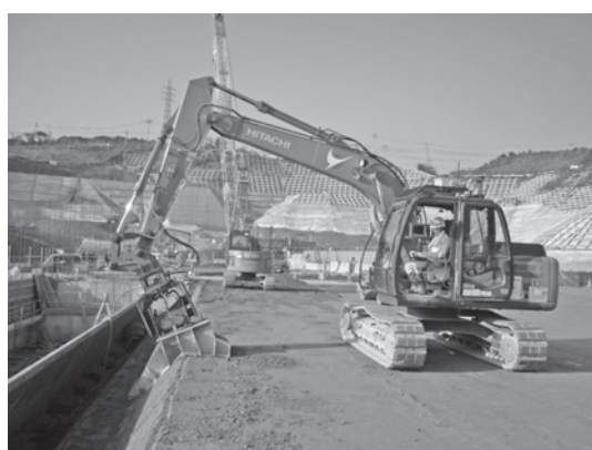
写真-2 端部法面締固め実施状況
