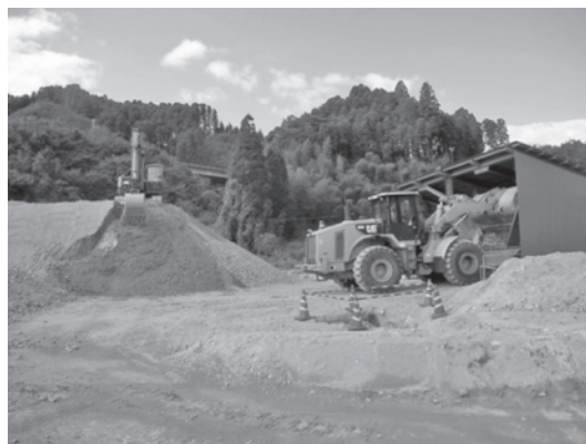
写真—1 CSG 材ホッパ投入
