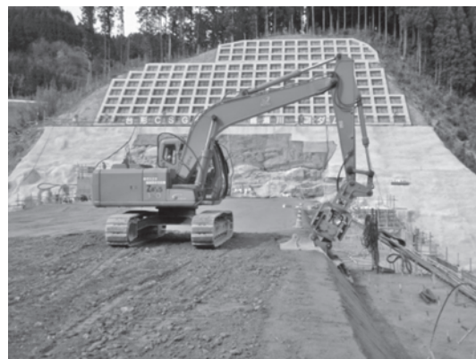
写真一 8 法肩締固め機施工状況
