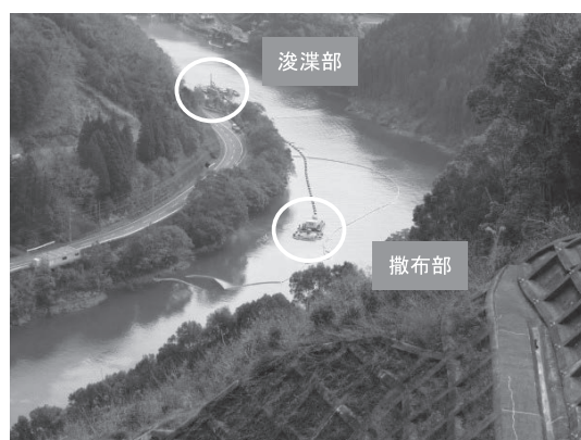
写真—8 貯水池内移動工法による試験工事
