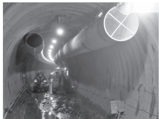
写真ー3 伸縮ダクト設置
