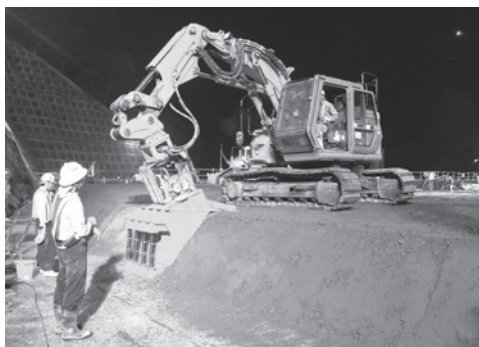
写真—4 1：0.8 端部法面締固め状況
