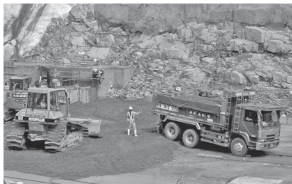
写真—4 堤体への運搬、敷均し施工状況
