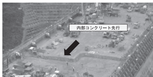
写真—1 巡航 RCD 施工状況
