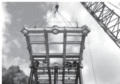
写真一八 パネル片持ち架設状況（ガイドホール）
