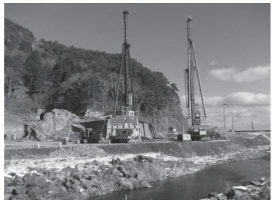
写真一七 松前川付近の地盤改良工施工状況
