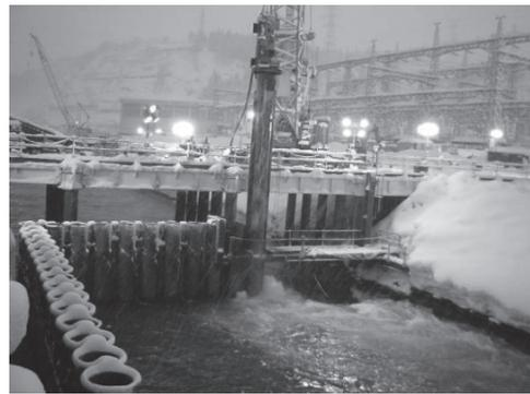
写真一九 夜間の鋼管矢板打設
