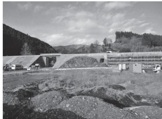
写真一9 RSS工法及びキャロットアンカーによる法面補強状況
