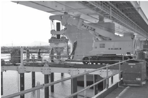
写真—13 桁下 5.8m の空間で杭打ち作業
