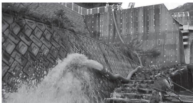
図-6 サイフォン作用による排水状況
