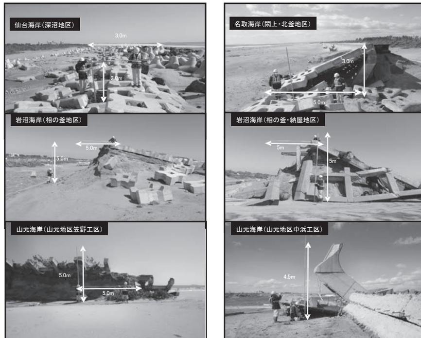
写真二2 海岸保全施設の被災状況
