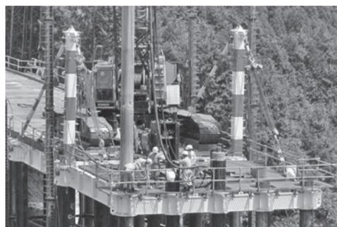
写真一七 「本工法」による栈橋架設工
