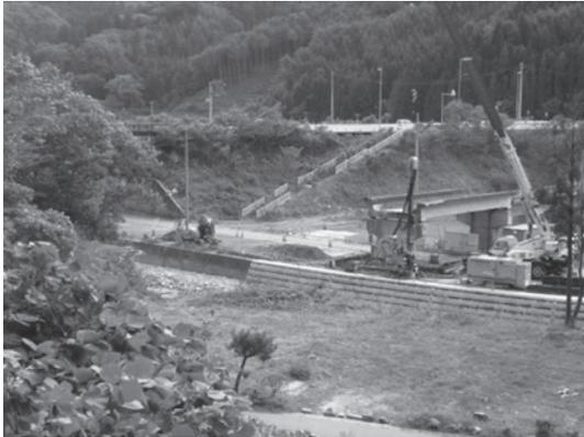
写真—12 荒川橋りょう P2 橋脚再構築状況
