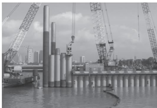
写真-2 海上部の鋼管矢板重防食
