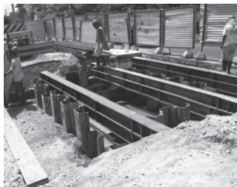
写真-9 立坑築造 (鋼矢板+路面覆工)
