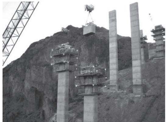
写真—4 橋脚セグメント架設
