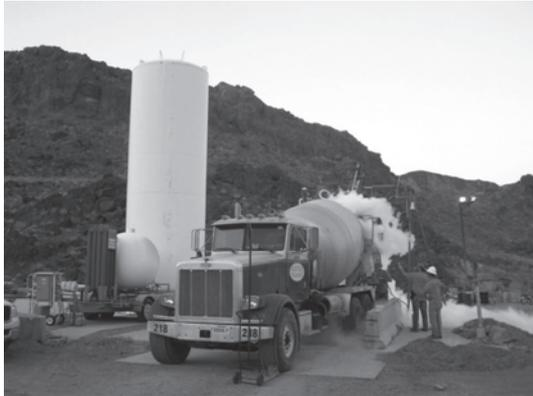
写真—10 液体窒素による生コン冷却
