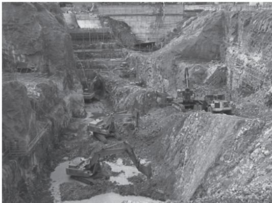
写真—2 転流後 河床掘削状況
