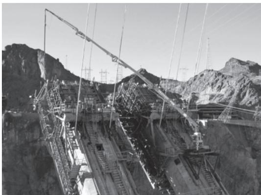
写真—11 コンクリート打設用ブーム
