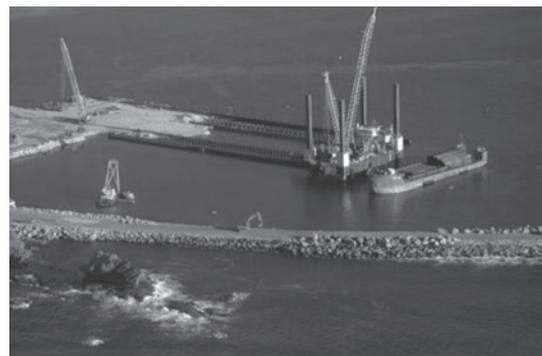
写真-16 SEP による鋼管矢板・杭打設状況
