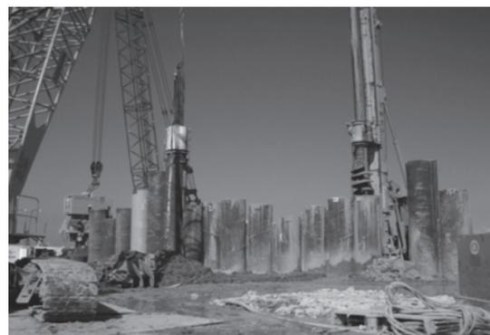
写真-5 中掘りおよび油圧ハンマー
