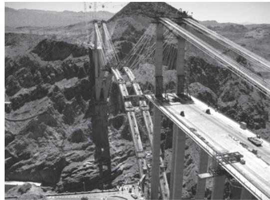
写真—7 ピロン柱と斜吊りケーブル
