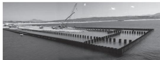
写真-17 鋼管矢板閉合。左奥ではタイロッドと裏込め施工中
