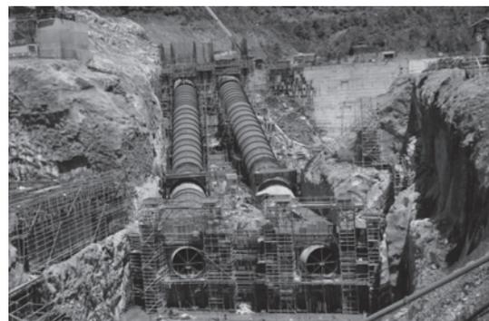
写真—4 導水鉄管据付状況全景
