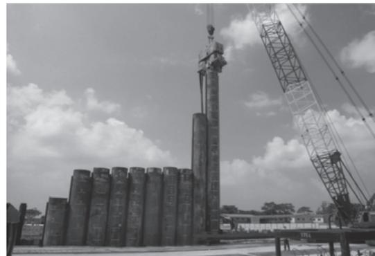
写真-4 鋼管矢板打設 (バイプロハンマー)
