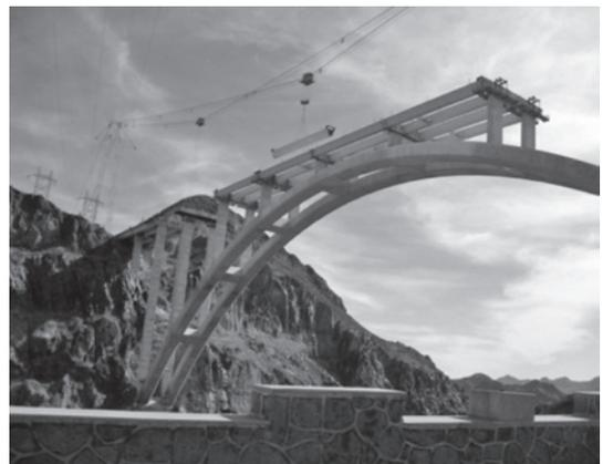
写真—5 鋼製桁運搬架設
