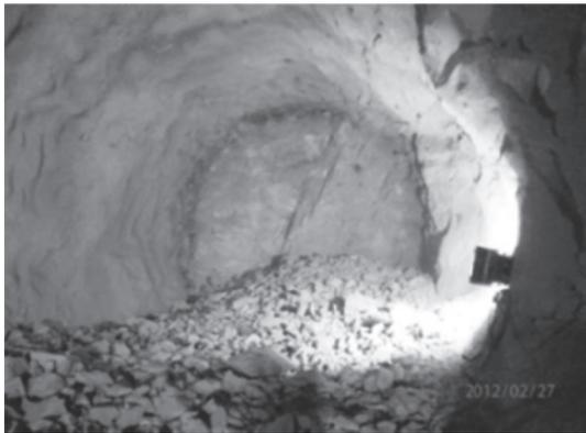
写真一 3 ダブルデッキ発破後
