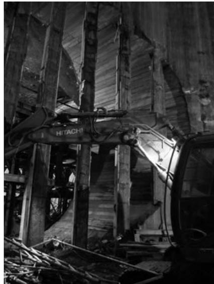
写真一9 仮支柱撤去状況
