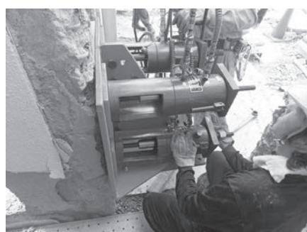
写真—3 左：柱以外の躯体切断状況，中：PC 鋼棒緊張，右：ブラケット取り付け状況
