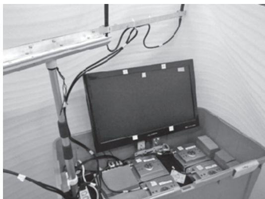
写真—3 コントロールボックス
