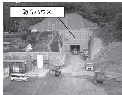
図一6 坑口周辺状況写真
