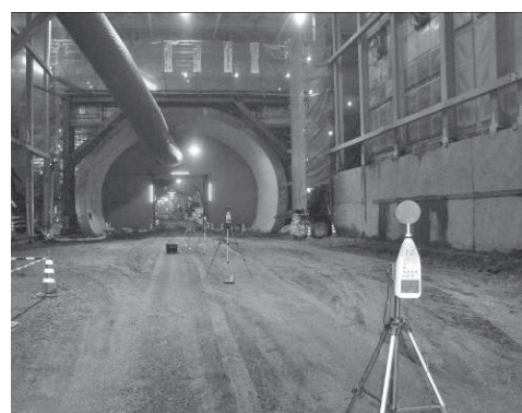
図一7 防音ハウス内測定状況写真
