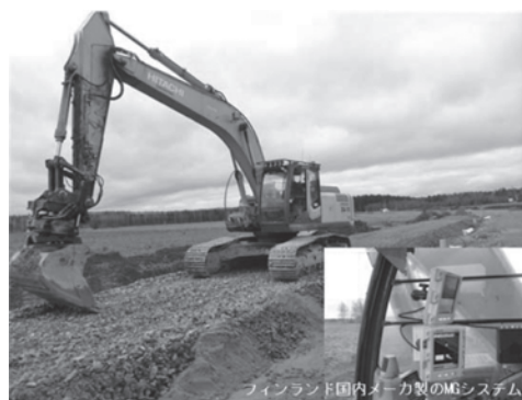
図—2 調査したフィンランドの施工現場
