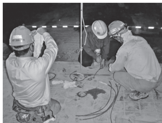
写真—4 基礎梁への装薬状況
