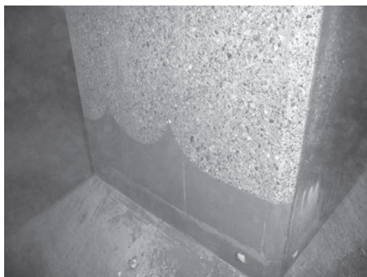
写真—7 WJ 表面処理機による処理面
