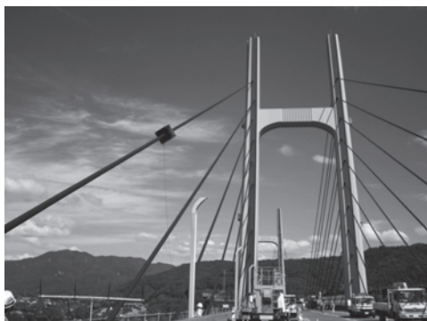
写真—6 点検状況
