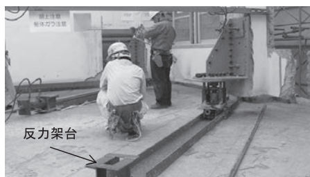
a 反力架台の設置
