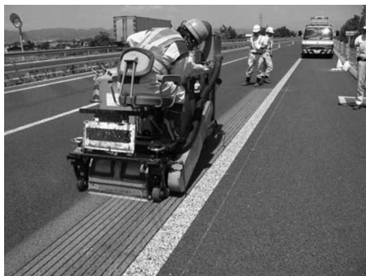
写真—1 グルーピング（安全溝設置）
