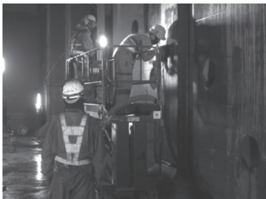
写真一五 人力による施工状況
