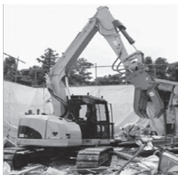
写真三 解体用つかみ機 (キャタピラー・ジャパン(株)製, 同社提供)
