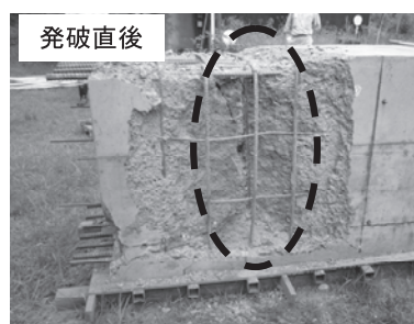
写真－2 「本工法」による鉄筋コンクリート部材の切断状況
