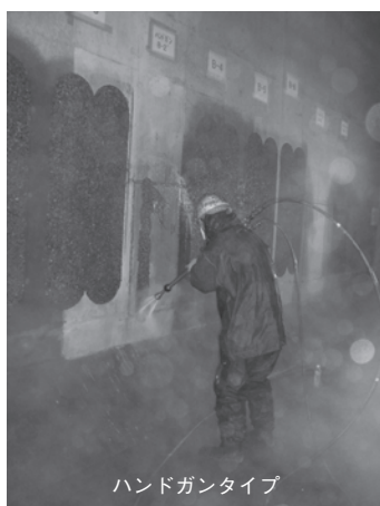
写真一六 研掃確認試験状況
