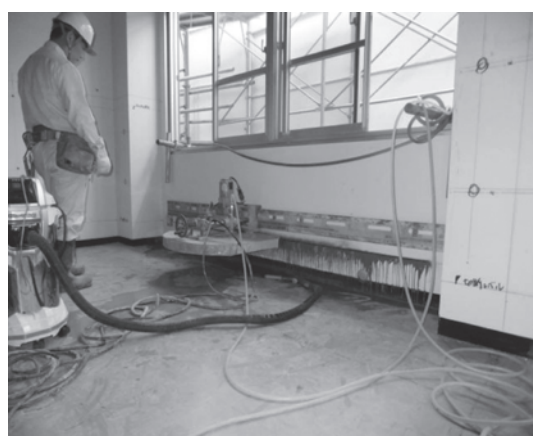
写真—1 ウォールソーによる壁の切断
