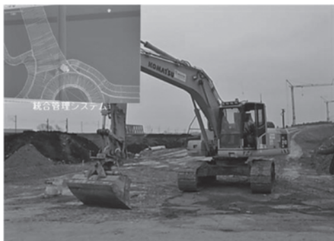
図—1 調査したドイツの施工現場
