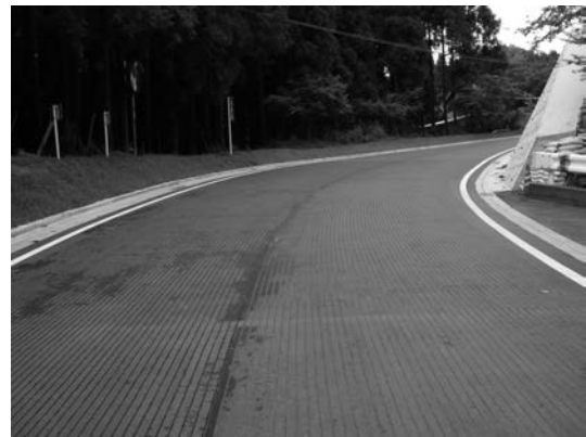
写真一6 カラー化した事例（右半分車線を赤ゴムで施工）
