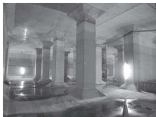
写真一 3 配水池内の外観
