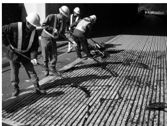
写真—3 凍結抑制材の充填
