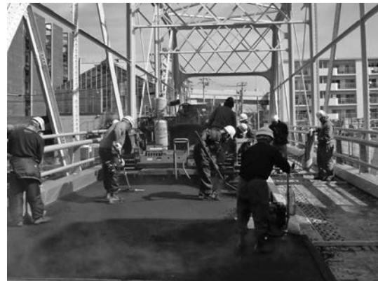
写真一3 AF による敷均し（鋼床版での適用例）
