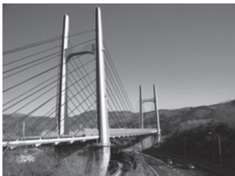
写真—5 東名足柄橋の全景
