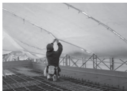
写真-2 養生シート設置状況
