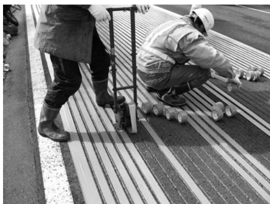
写真—2 特殊テープによる養生
