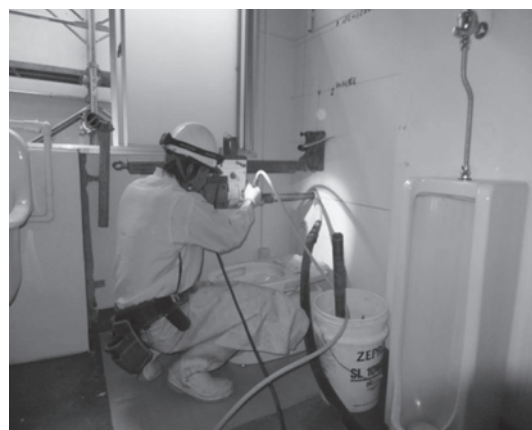
写真—2 柱のコア抜き
