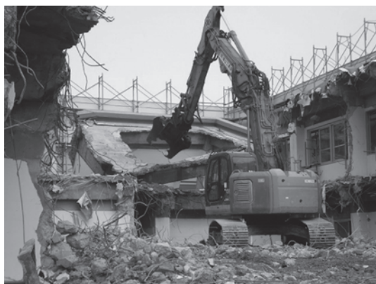
写真—6 階上解体の状況
