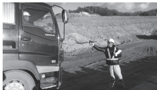
写真—2 盛土場における材料確認状況
