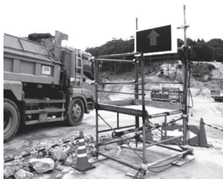
写真—1 分岐点における矢印の表示状況
