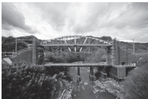
写真一3 第2回リフトアップ状況
