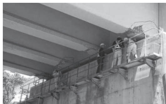
写真—1 検査路による近接点検
