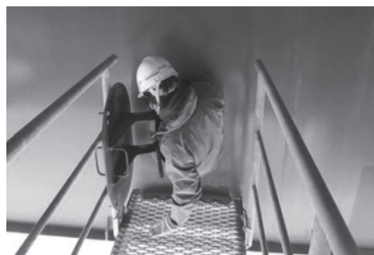
写真—3 点検や資機材の搬入が困難な例
