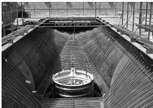
写真—4 PCa 型枠製作状況
