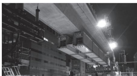
写真一5 走行タワーの先送り (Cbp17 架設時)
