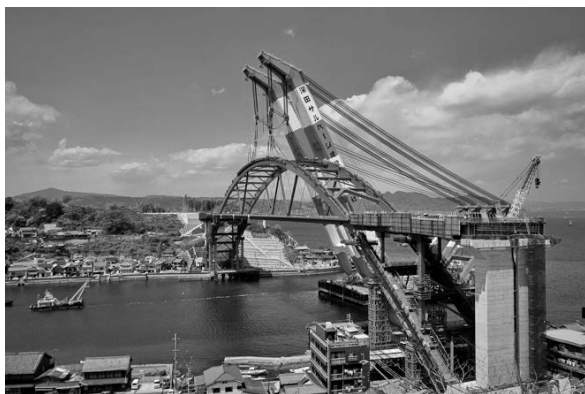
写真—9 荷重解放完了
