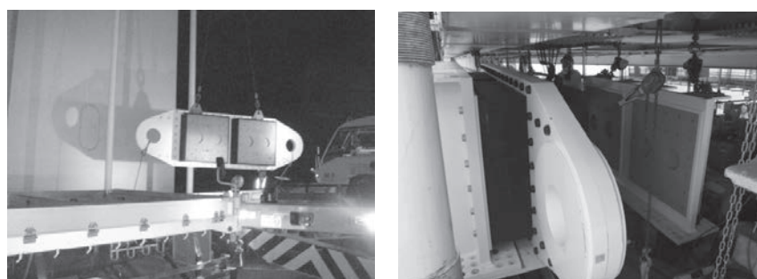
写真—4 積層ゴムダンパー架設・組立状況
