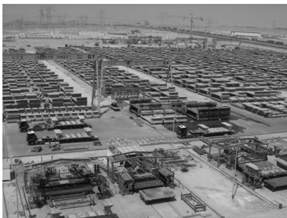
写真—7 プレキャストヤード全景
