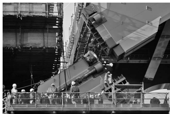
写真一7 引き寄せワイヤー設置
