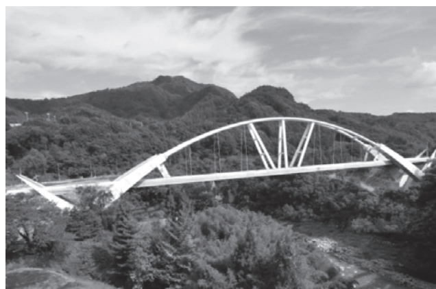
写真一 5 第三吾妻川橋りょうの完成
