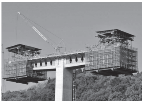
写真—3 張出し施工状況
