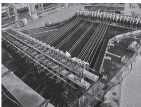
写真—1 「本構造」パネル製作状況
