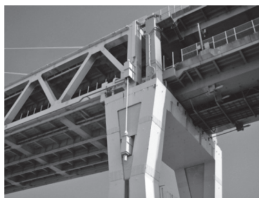
写真—6 端橋脚部の負反力ケーブル支承
