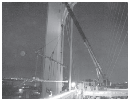
写真—5 ケーブル架設状況
