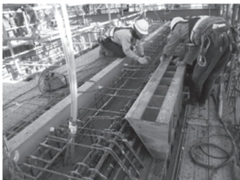
写真一 4 ハンチ型枠の設置
