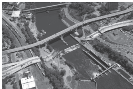
写真—6 崩落後のI-35W 橋の全景（出典 MN/DOT8）
