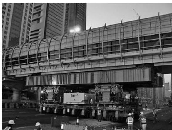
写真—11 歩道橋の運搬・架設状況
