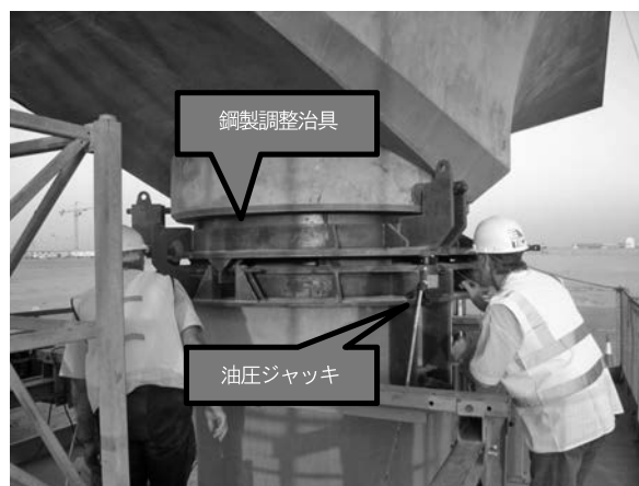
写真—6 特製治具による PCa 型枠の調整状況
