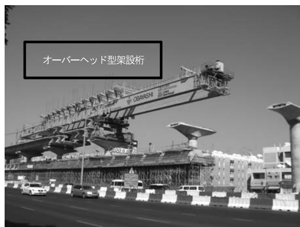
写真—8 架設桁によるスパンバイスパン架設
