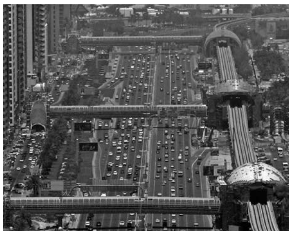
写真—12 架設が完了した歩道橋群
