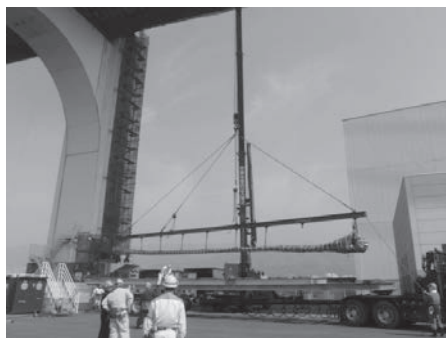
写真—5 ケーブル架設状況
