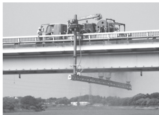
写真一四 橋梁洗浄の状況
