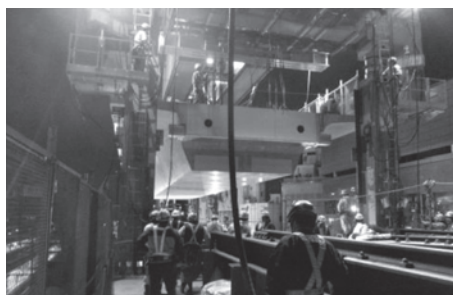
写真一6 桁の降下・架設 (Cbp7)
