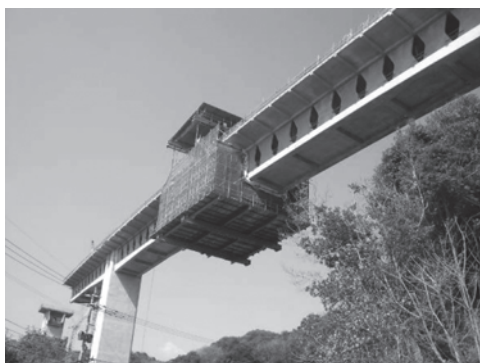
写真—4 中央閉合状況
