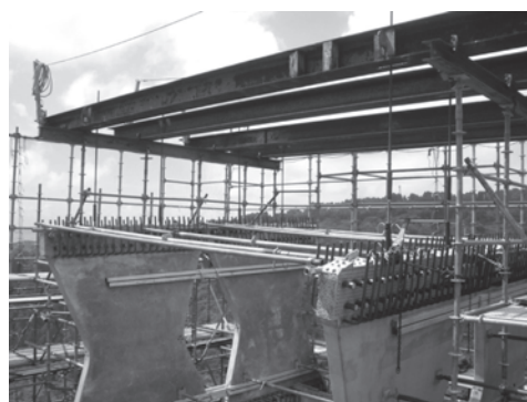
写真—2 柱頭部のパネル施工状況
