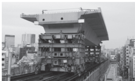
写真一4 昼間待機・自走台車上のPC桁 (Cbp16)
