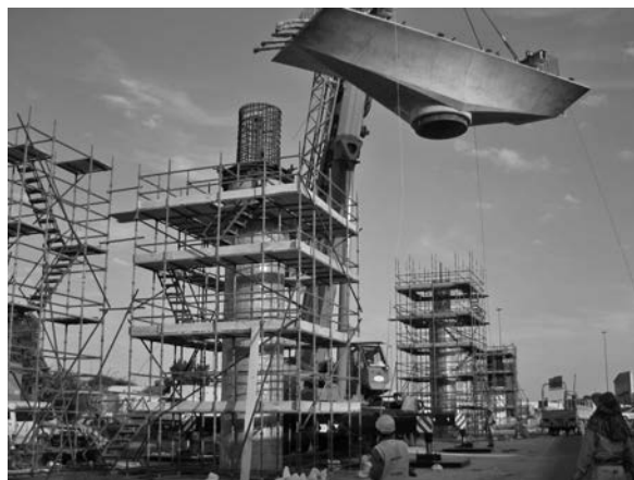
写真—5 PCa 型枠 吊込み状況
