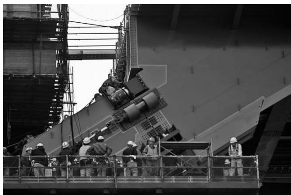
写真—8 「かんぬき」挿入
