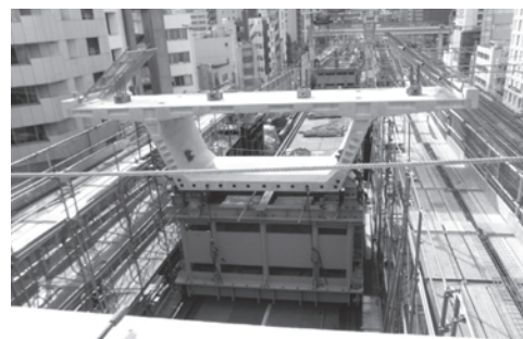
写真－1 搬入後・引寄せ台車上のPCブロック
