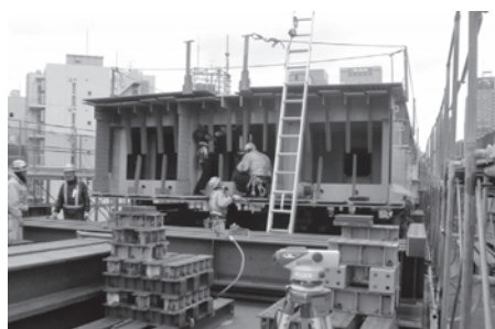
写真－2 鋼桁Gd1の組立状況
