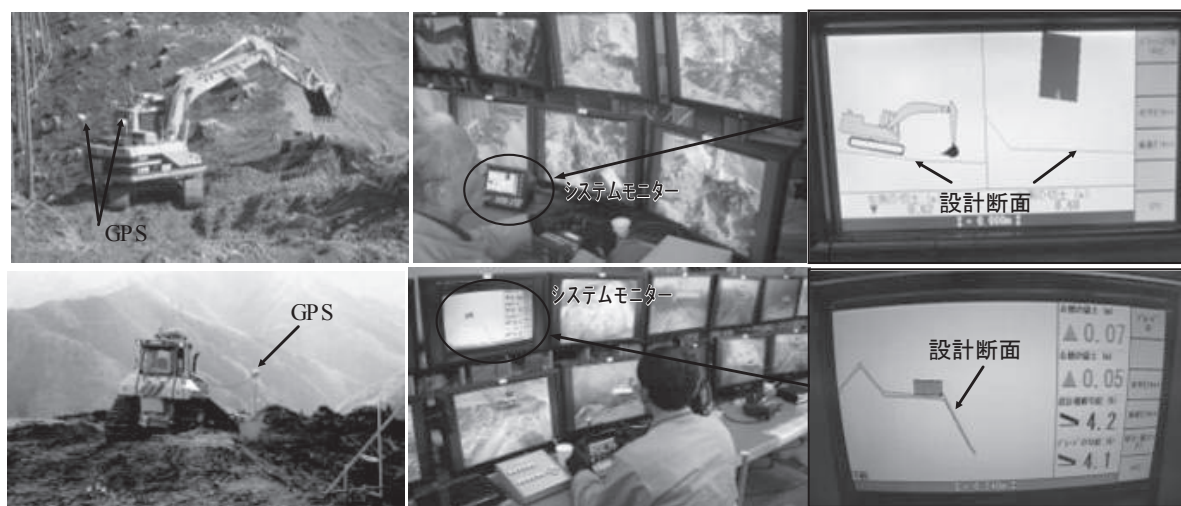
上段：油圧ショベルガイダンスシステム，下段：ブルドーザ排土板自動制御システム 写真-2 情報化施工システム
