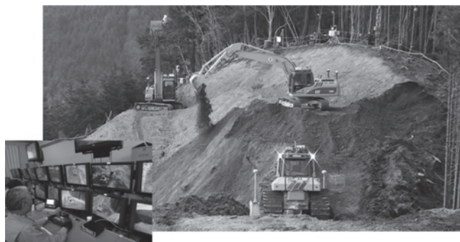
写真-1 北股地区無人化施工状況
