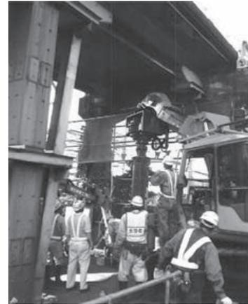
写真-2 油圧式リーダーレス型基礎機械による施工状況
