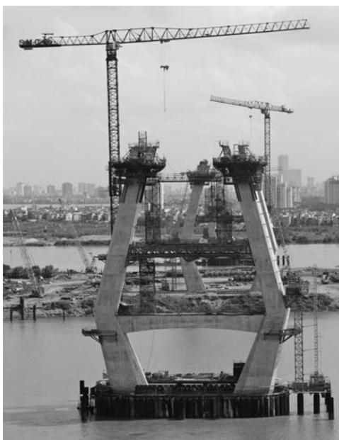
写真—1 主塔構築の仮締切も兼ねる鋼管矢板基礎
