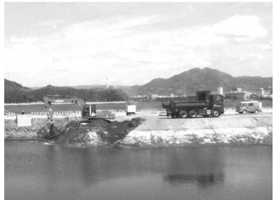
写真—7 バックホウ投入（水深5m以浅）
