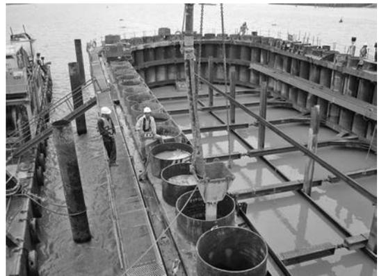
写真一 6 トレミー管による外周杭の中詰コンクリート打設
