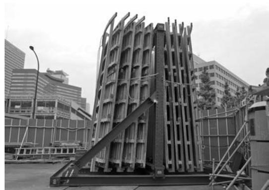
写真三 型枠ストックゲージ
