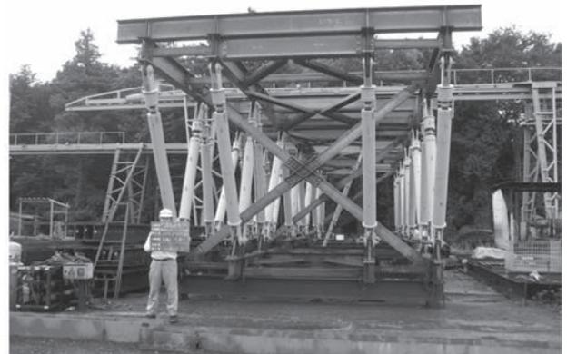
写真-3 工場製作時のアンダーピニング用トラス桁
