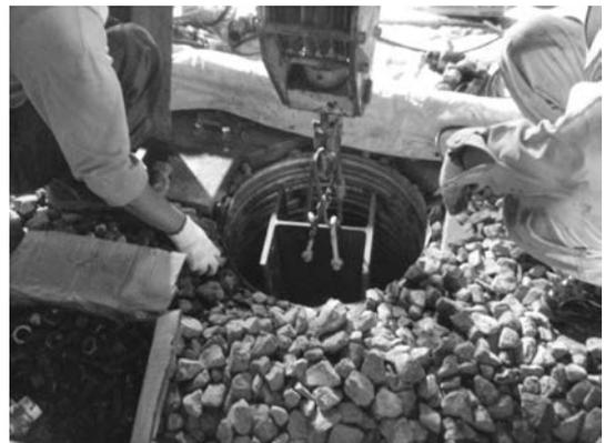
写真-5 芯材建て込み完了
