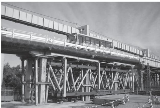
写真-4 現場に設置したトラス桁式アンダーピニング
