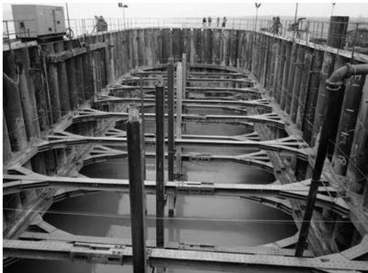
写真一8 山留掘削・底盤コンクリート打設後、排水準備完了
