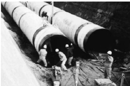
写真一 4 二連管路新設時 (鋼管)
