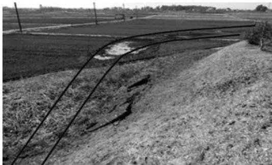
写真-3 埋設管直上の地表面の沈下・亀裂<sup>9)</sup>
