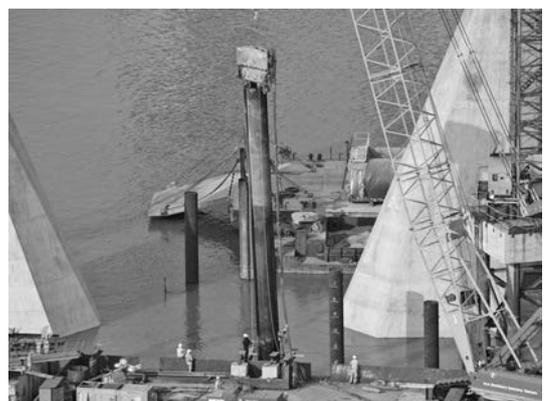
写真一 7 役目を終えた外周部仮締切り部鋼管矢板の撤去
