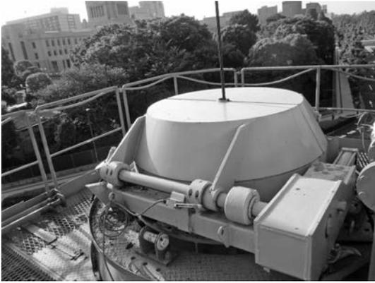
写真—9 ワイヤボックス消音装置（音イーター）
