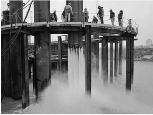
写真一 2 下杭の沈設に威力を発揮するウォータージェット
