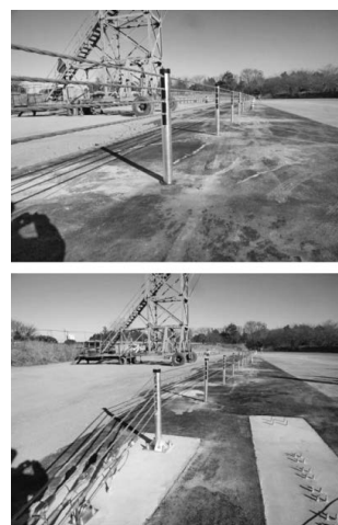
写真—4 防護柵設置状況
