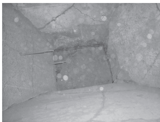
写真—5 エアパージ装置取付後の炭化物排出状況
