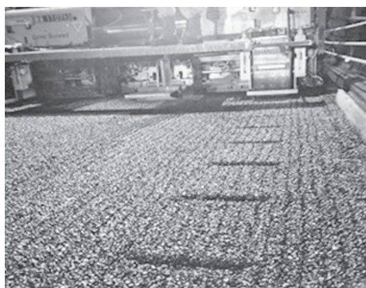
写真—10 横溝の設置状況
