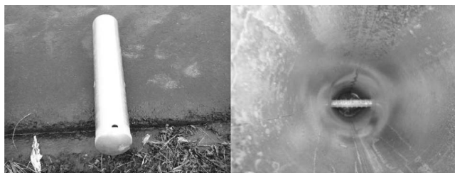
写真一七 スリーブ（左）と管内の支柱支え（右）
