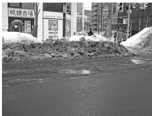
写真—1 北海道の排水性路面状況
