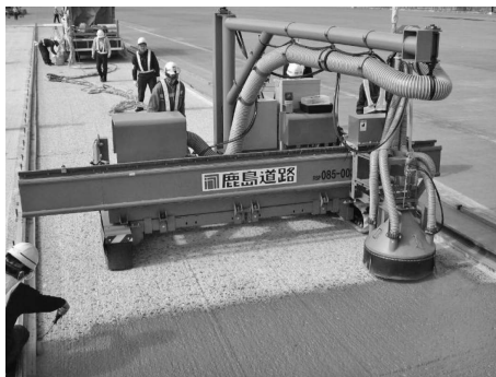
写真—7 大規模施工現場接着剤散布状況
