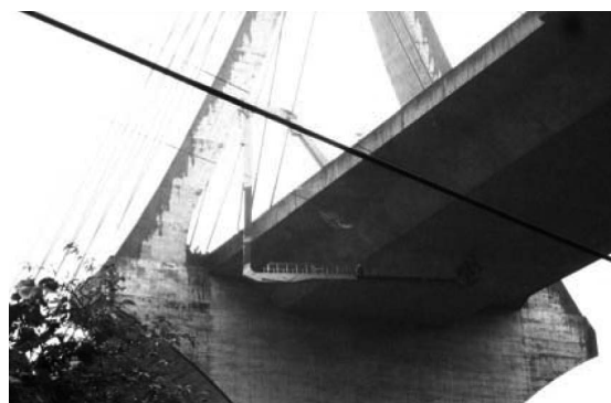
写真―2 橋梁点検車を用いた点検の様子
