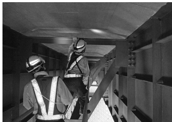
写真―1 ロッククライミング点検の様子
