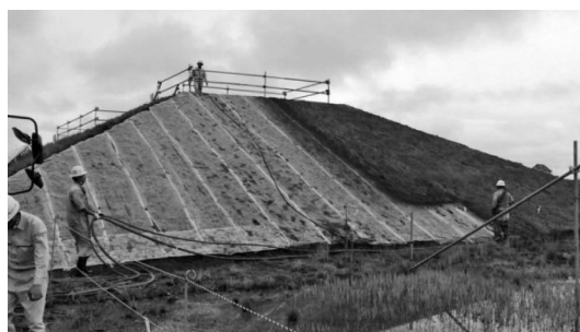
写真—10 緑化工事の様子
