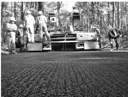
写真一 2 舗設状況
