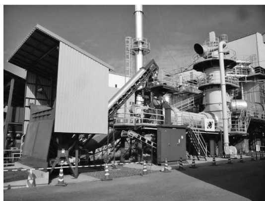
写真—3 固形燃料燃焼システム全景
