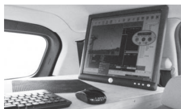
c) 車内機器設置状況 (後部) 表示用モニター及び、ワイヤレスポート
