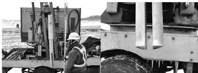
写真一八 打込み治具（左）と先端の形状（右）
