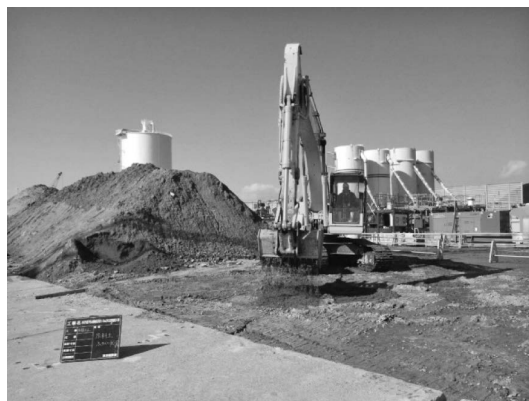
写真—8 ロータリー式スケルトンバケットによる事前ふるい分け状況
