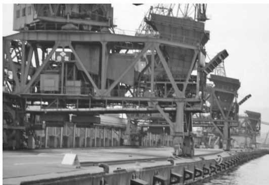
写真—1 被災した 7 号ふ頭岸壁（7-2）
