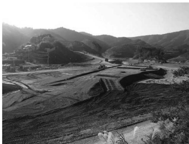
写真-1 女川町中心部の造成状況
