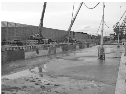
写真—6 トレミー管による打設状況
