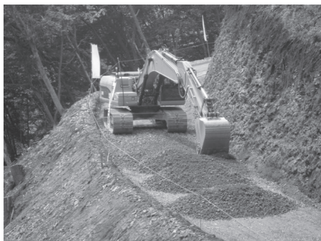
写真—4 震災がれき敷設状況
