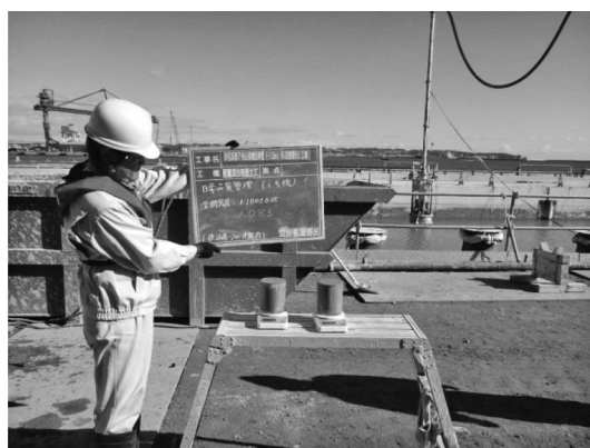
写真—3 筒先での処理土の密度確認
