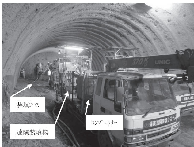
写真—2 爆薬遠隔装填システム使用状況
