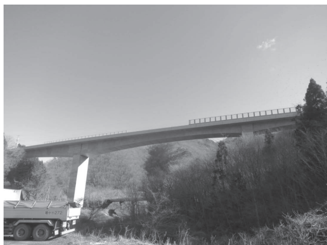
写真—3 施工状況（施工完了）
