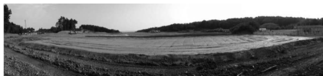
写真-2 女川町離半島部出島地区の造成状況
