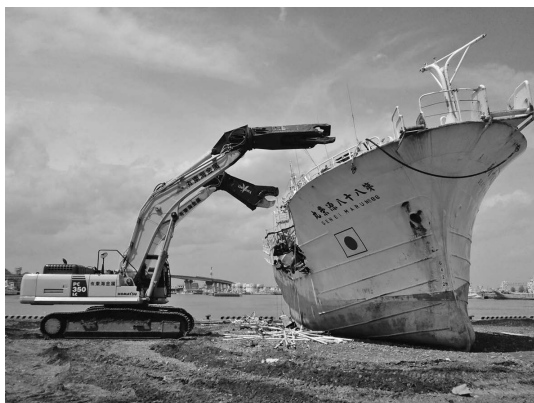
写真—3 青森県の海で津波被害を受けた船を解体
