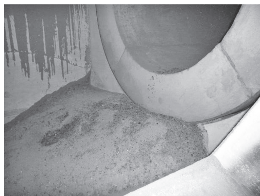
写真—5 木材チップ炭化物排出状況
