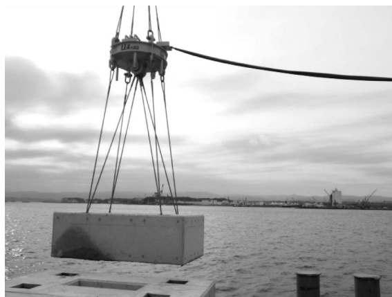
写真—2 施工状況
