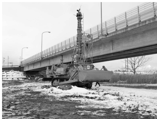
写真—12 宮城県名取川で稼働した水陸両用ブルドーザー
