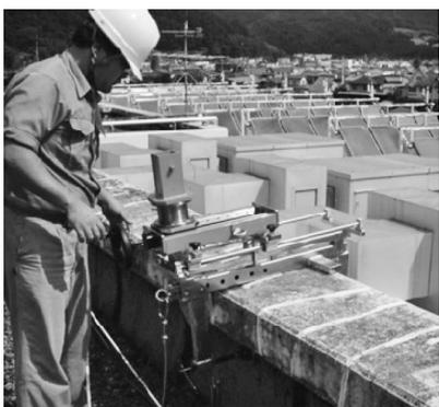
写真—4 吊りアーム保持部の取付け②
