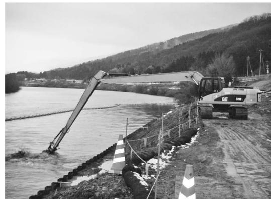
写真—5 河床掘削での導入例
