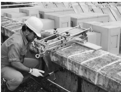
写真—3 吊りアーム保持部の取付け①
