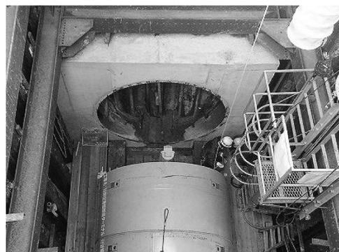
写真一 3 FRP 製矢板工法を用いた推進工事での発進前状況
