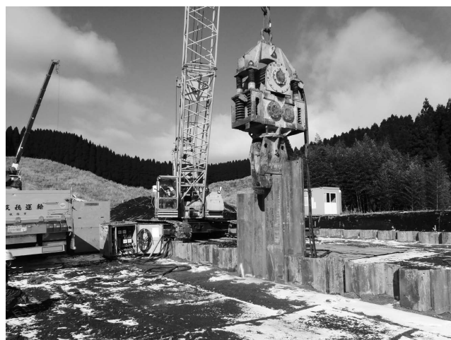
写真一九 空洞部継矢板パイプロ打設
