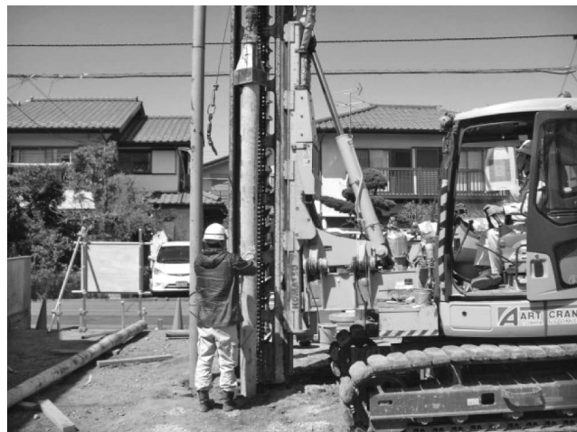
写真—1 丸太の打設状況
