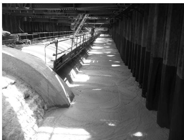
写真—36 発泡モルタル施工状況
