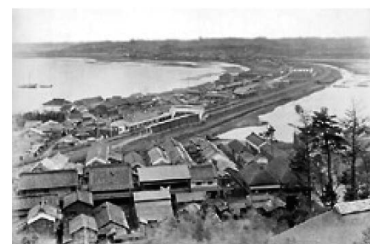
写真一6 品川沖の築堤敷設
