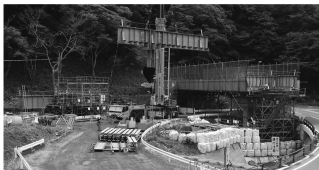
写真一4 鋼部材架設状況（終点方架設時）
