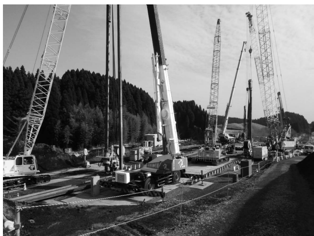
写真一七 鋼矢板打設状況
