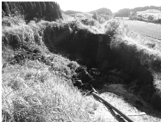
写真－3 トンネル崩落部の地表陥没状況
