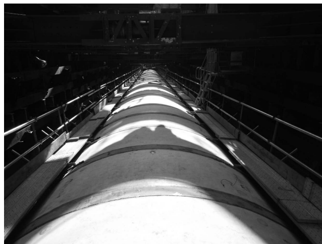
写真-28 モジュラーチ据付完了（上部）
