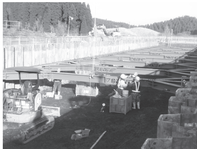
写真－5 切梁・腹起し架設状況
