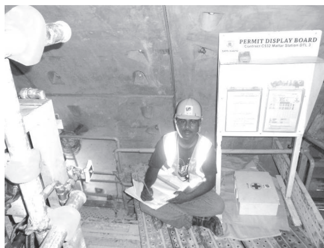
写真一 6 圧気作業時の専用通路（マンロック側）
