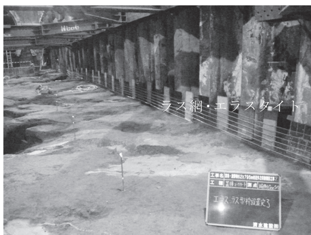
写真-21 縁切型枠組立完了
