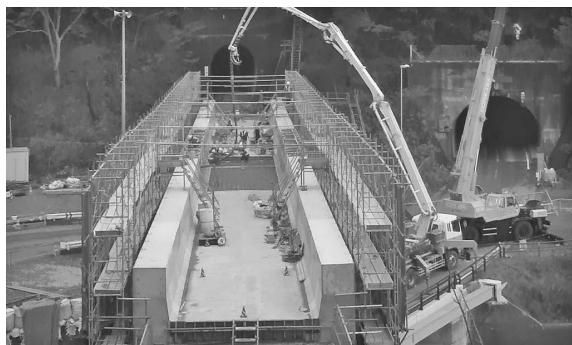
写真-5 コンクリート打設状況
