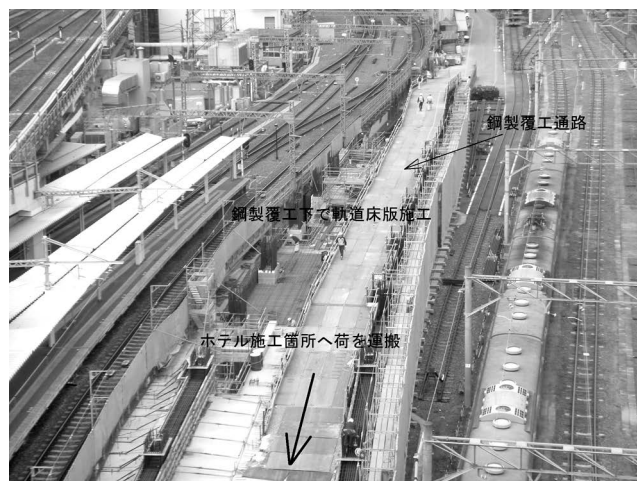
写真—4 鋼製覆工通路
