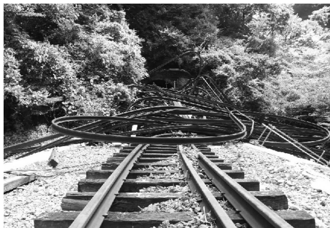
写真－1 熊本方坑口でのレール流出状況
