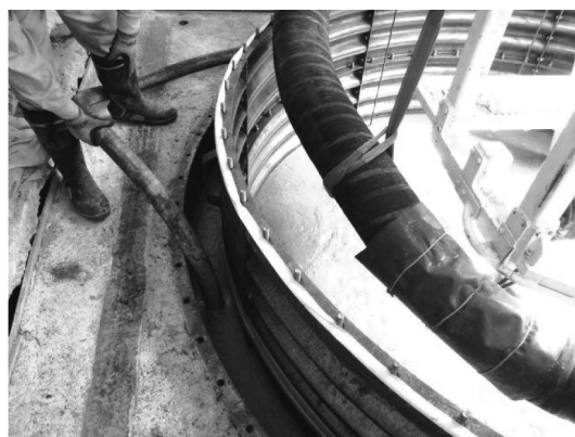
写真一5 裏込め材充填
