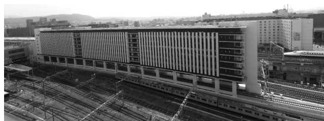
写真—7 完成後（京都駅ビルより望む）
