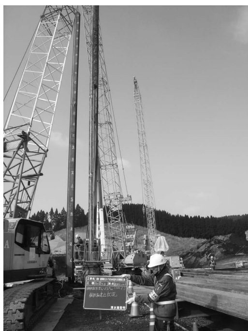
写真一八 鋼矢板建込状況
