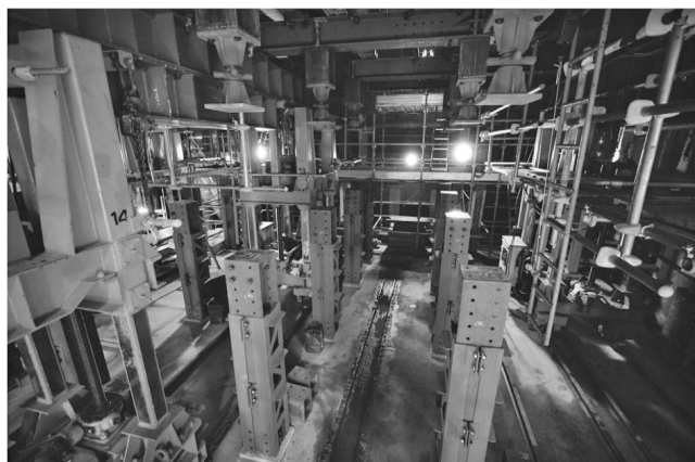
写真－3 ジャッキアップ後（鋼製支保工内側）
