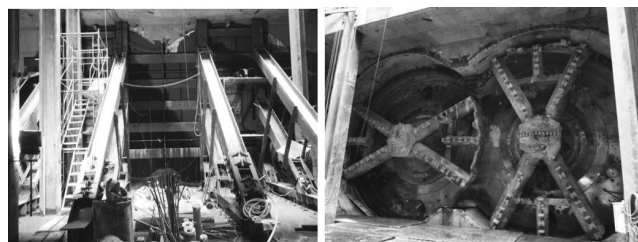
写真—11 シールド機到達状況
