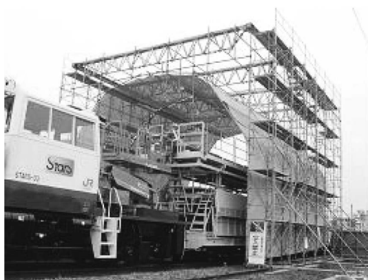
写真—9 模擬トンネル
