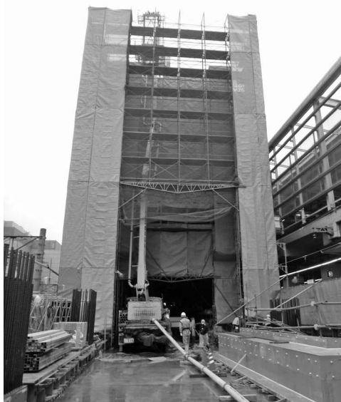
写真—6 中継ポンプ車による打設状況
