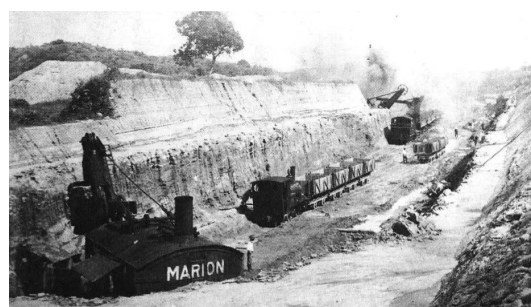
写真—21 嘉南大圳の水路掘削
