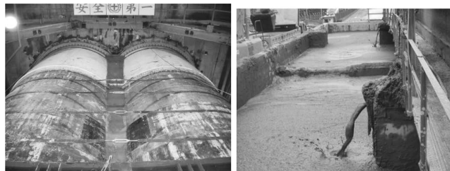
写真—6 残土搬出状況とシールド発進状況
