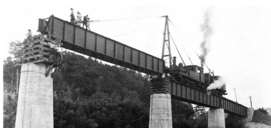
写真—19 SL による架桁（因美線）
