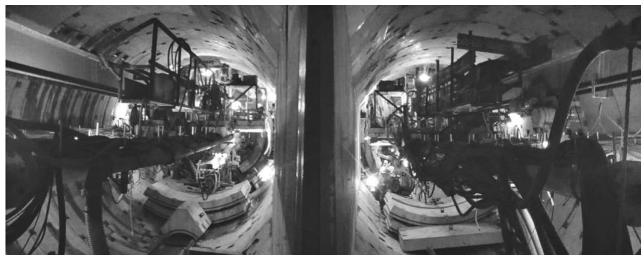
写真—7 本掘進切羽状況
