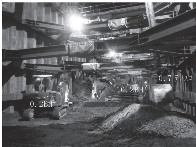
写真一11 掘削内部状況
