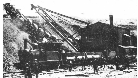
写真—11 長梯鋤簾式掘鑿機と 20 t SL
