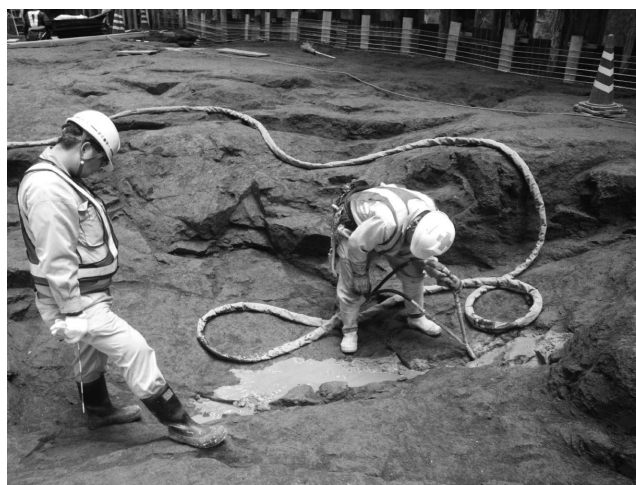
写真一13 亀裂箇所セメントミルク注入状況
