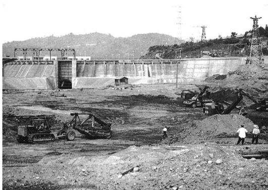
写真—27 山本貯水池工事
