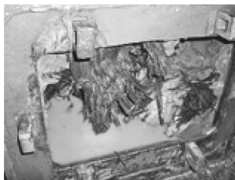
写真—10 スクリーンの閉塞状況
