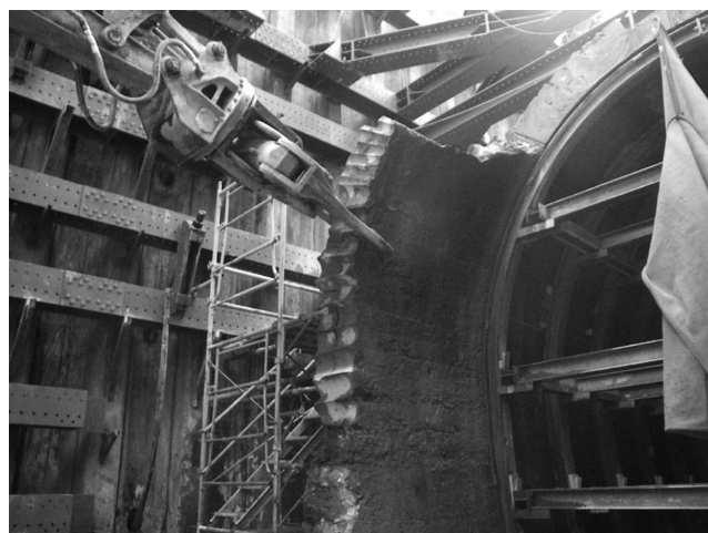
写真—18 取合部取壊し状況
