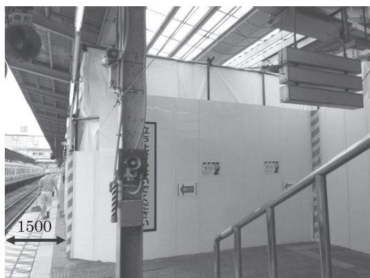
写真一2 ホーム上仮囲い
