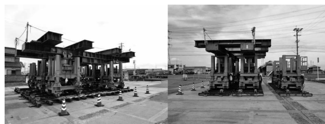
写真一 試験施工
