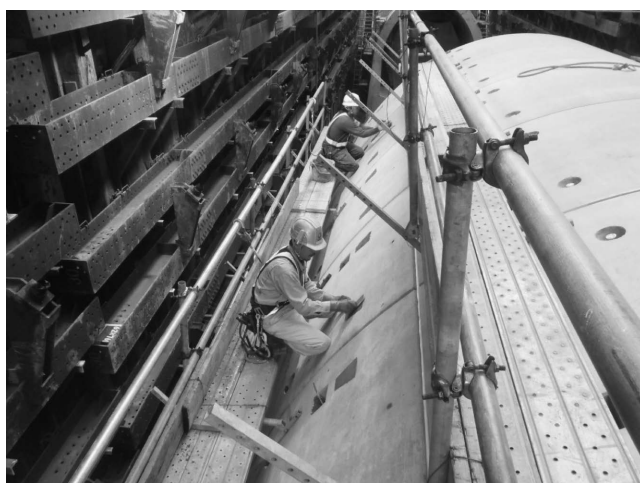
写真-27 切欠部への無収縮モルタル詰め
