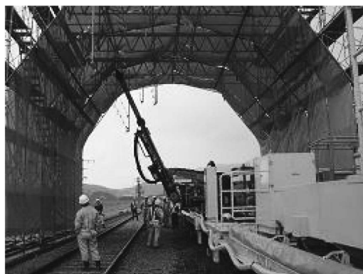
写真—10 施工訓練状況
