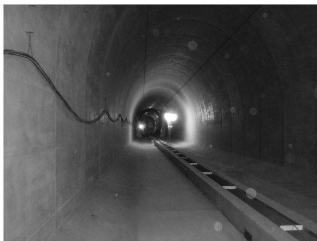
写真—34 インバート施工完了
