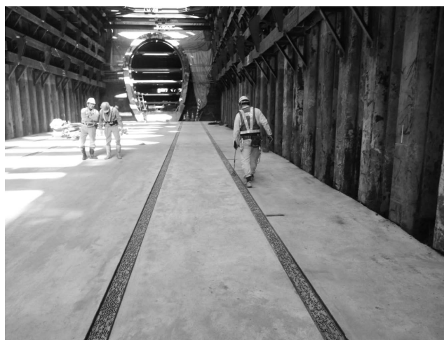
写真-23 鋼球敷均し状況
