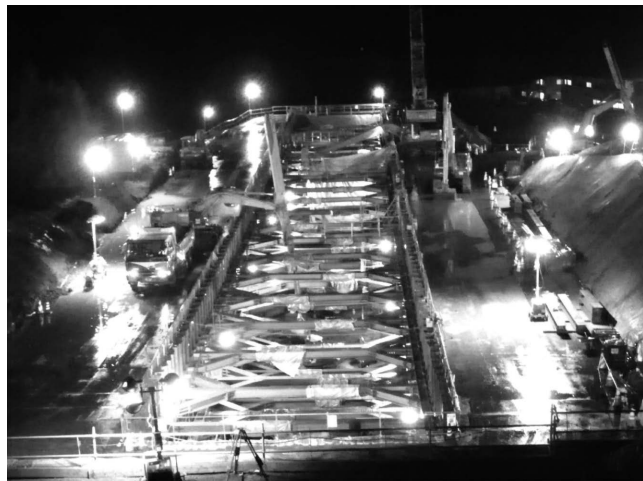
写真一10 掘削全景
