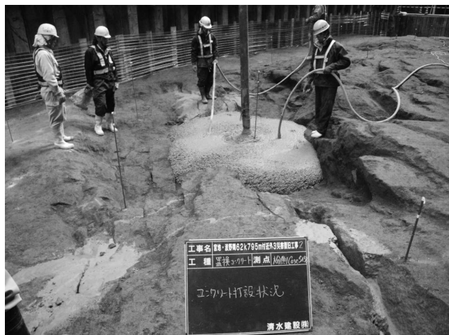
写真-20 置換コンクリート施工状況
