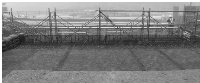
写真一2 ジオテキスタイル敷設・溶接金網設置状況
