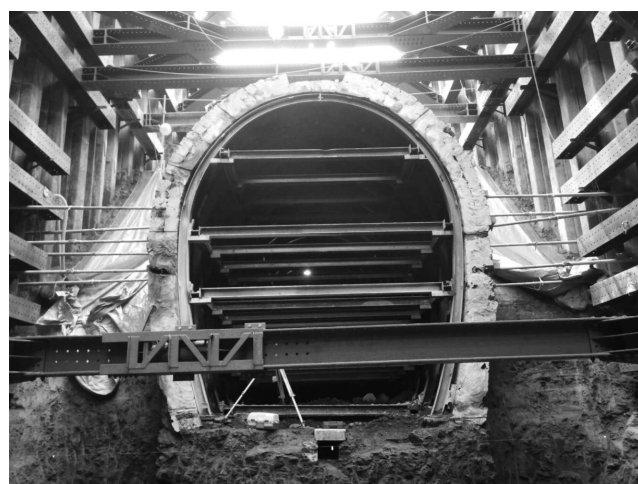
写真—19 切断および取壊し完了
