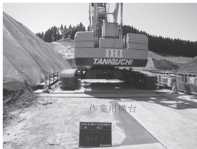
写真-22 120tクレーン作業構台
