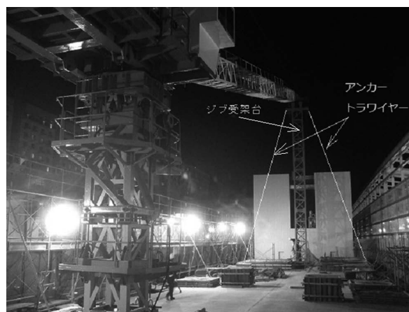
写真—2 タワークレーン台風対策状況
