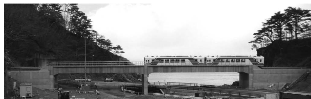
写真-7 運転再開した北リアス線 (ハイベ沢橋梁)
