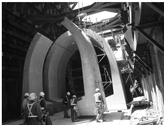
写真-24 モジュラーチ組立状況
