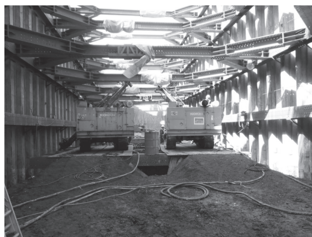
写真－6 グラウンドアンカー削孔状況
