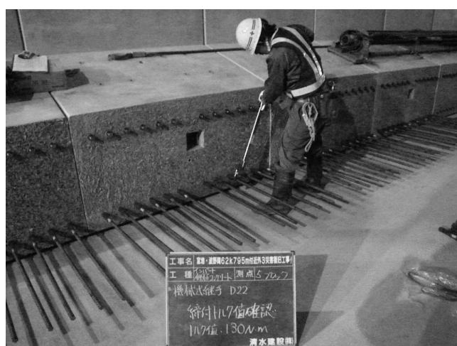
写真—32 機械式継手トルク管理
