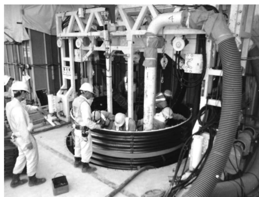
写真一4 ライナープレート組立
