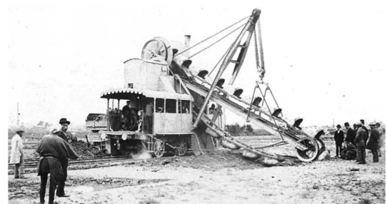
写真—10 淀川改修工事のラダーエキスカベータ
