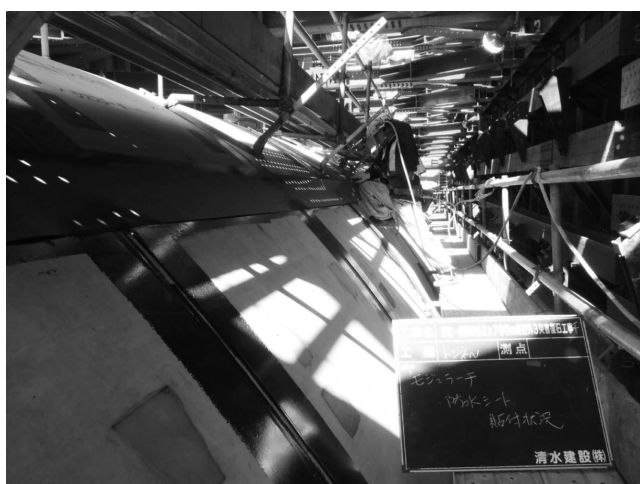
写真-26 アスファルト系外防水
