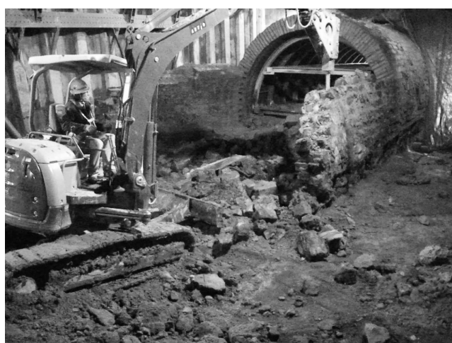
写真—17 取壊し状況
