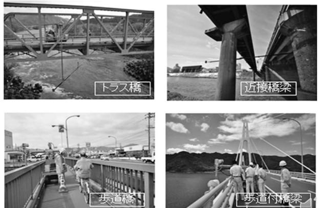
写真一15 点検車が利用出来ない橋梁の例
