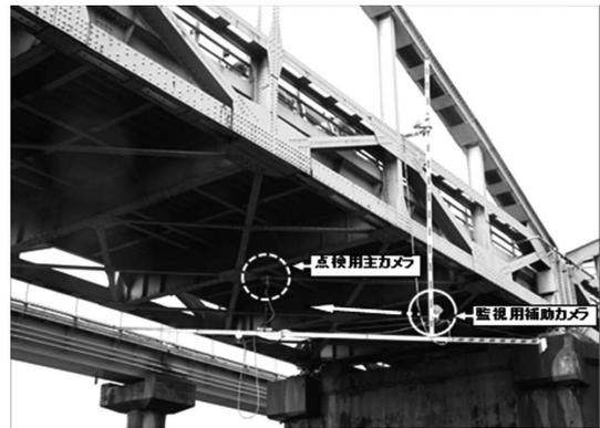
写真-4 監視用補助カメラ設置状況
