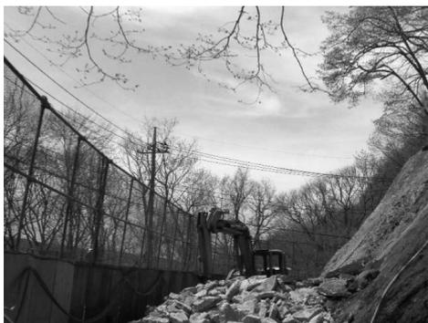
写真一五 重機によるはつり取り (例)
