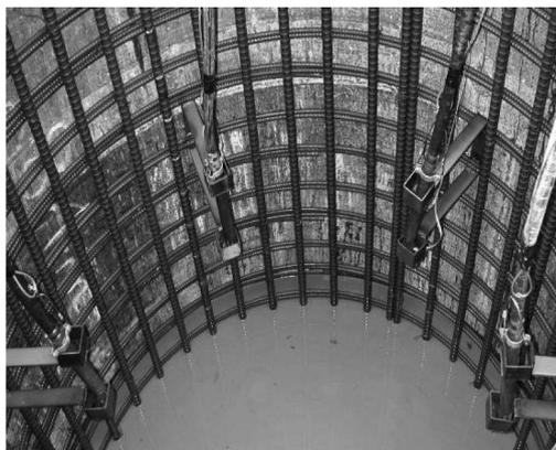
写真-1 杭頭バイブレータ設置状況
