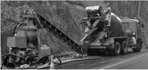
写真一七 湿式吹付機の設置状況 (例)
