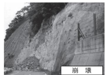
写真一2 吹付材自体の劣化による劣化現象 (例)
