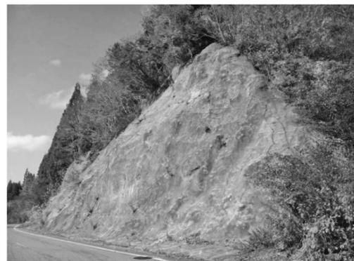
写真—1 吹付工の施工（例）
