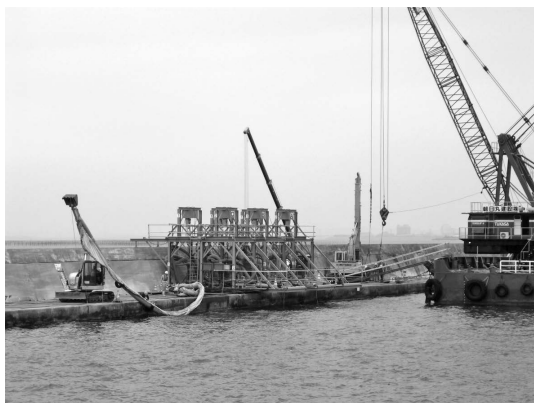
写真—3 中詰材撤去設備
