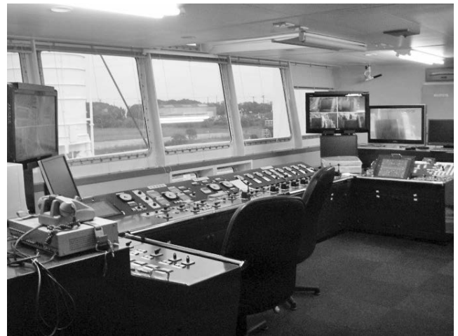
写真一六 新設船橋（操作卓）
