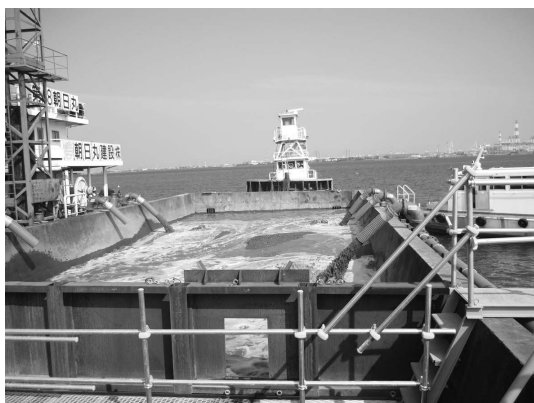
写真—4 中詰材の積込状況
