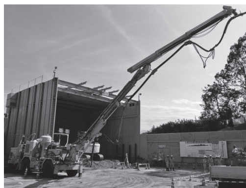
写真—11 ロングブーム機による高所吹付け事例
