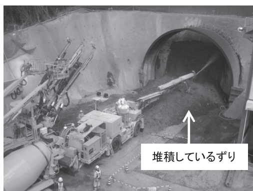
写真―8 本技術による坑口部の吹付け
