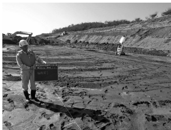
写真—5 施工状況 (床掘)
