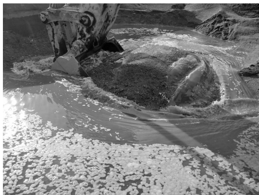
写真一六 中詰材の揚土状況
