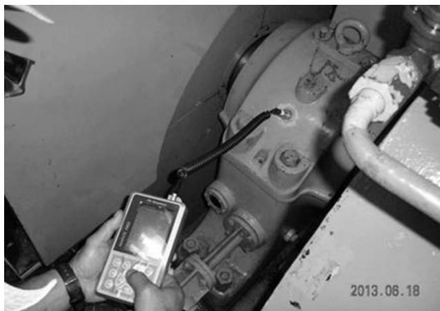
写真—1 軸受の振動計測作業
