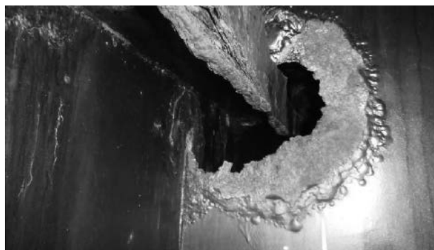
写真-2 バラストタンク内における腐食事例
