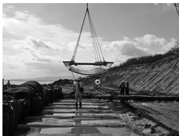
写真—6 施工状況 (アスファルトマット敷設)
