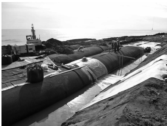
写真一八 施工状況（中詰材充填）
