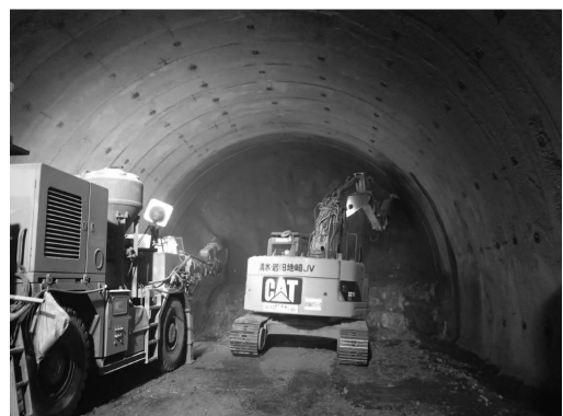
写真―10 吹付けと支保工清掃の同時作業
