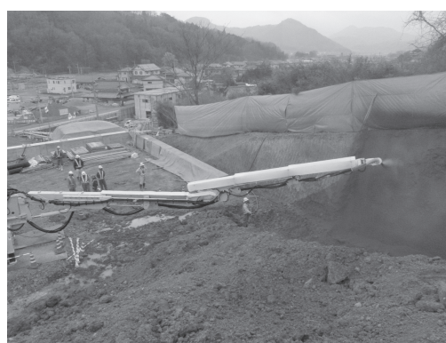
写真—12 掘削土砂越しの狭所吹付け事例
