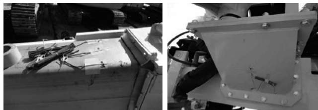
写真—6 ひずみゲージ取付状況
