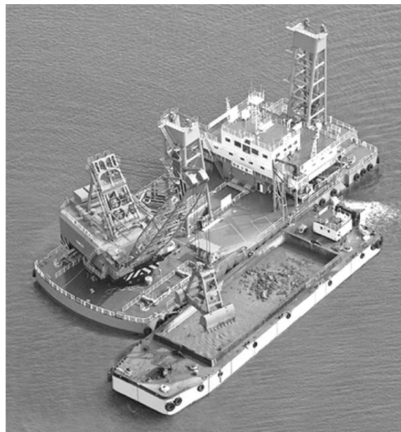
写真-2 施工状況
