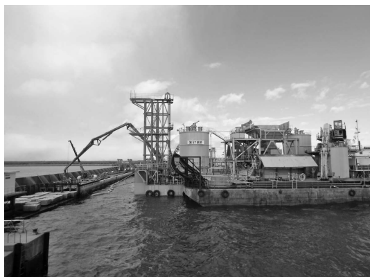
写真一八 ディストリビューターによる打設状況
