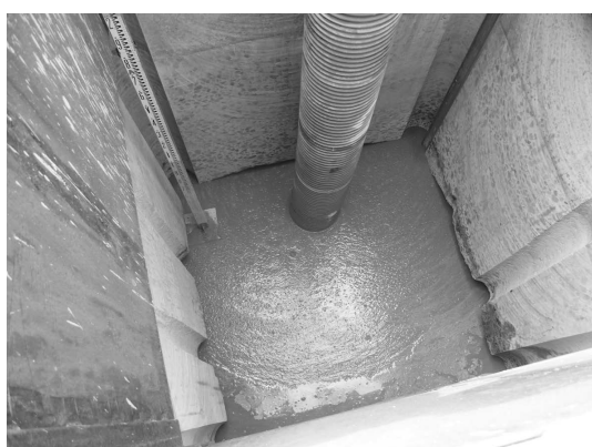
写真一九 打設完了
