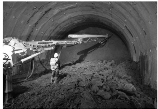
写真―9 坑内でのずり越しの吹付け
