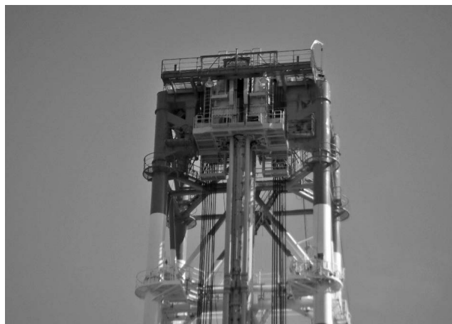
写真—5 櫓頂部（処理機巻上時）
