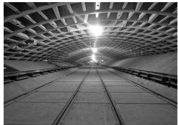
写真ー4 上部アーチセグメント設置完了
