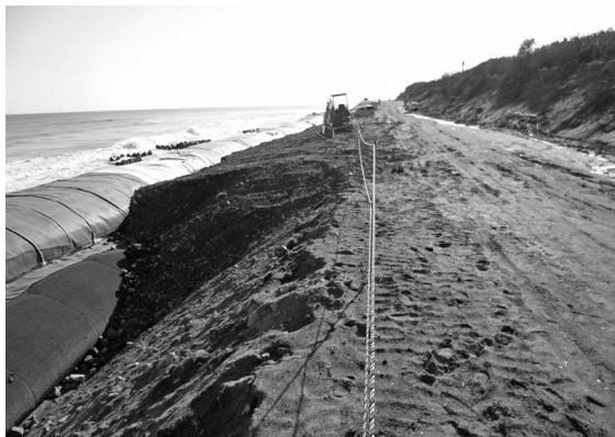
写真一九 施工状況（サンドバック背後養浜）
