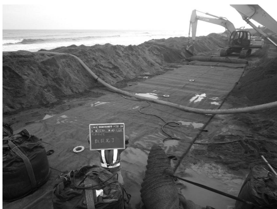
写真一七 施工状況（袋材敷設）
