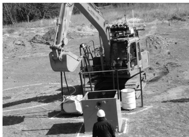
写真-4 モデルタスクⅠでの固形対象物の移設状況
