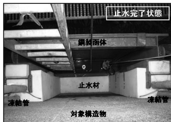
写真一2 実海洋環境実験（実験Ⅱ）での止水性確認
