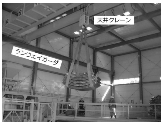
写真—8 防音ハウス内天井クレーン作業
