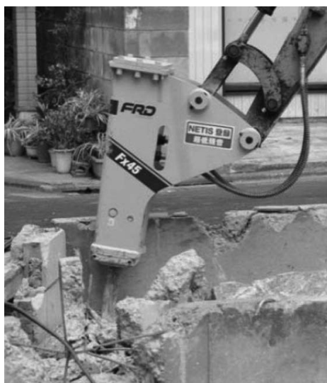
写真—2 住宅の基礎解体
