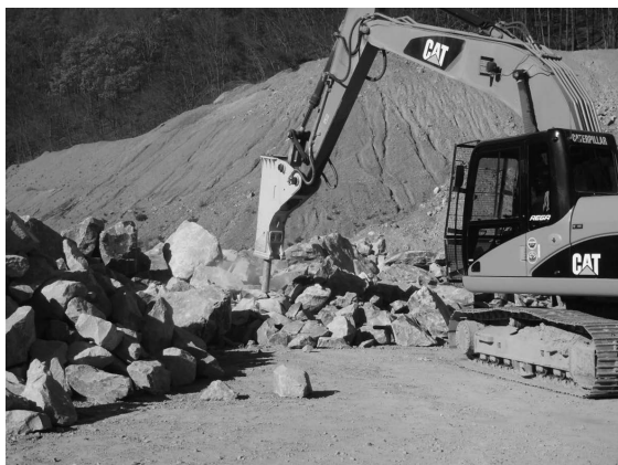
写真—1 採石場での2次破碎
