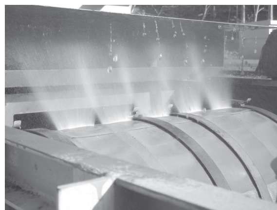
写真—6 フィルター洗浄状況
