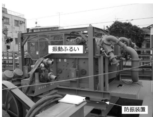
写真—6 防振装置設置完了
