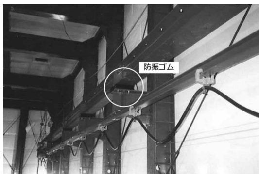
写真—9 防振ゴム施工例1
