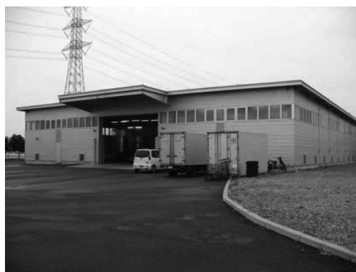
写真—2 製造工場全景
