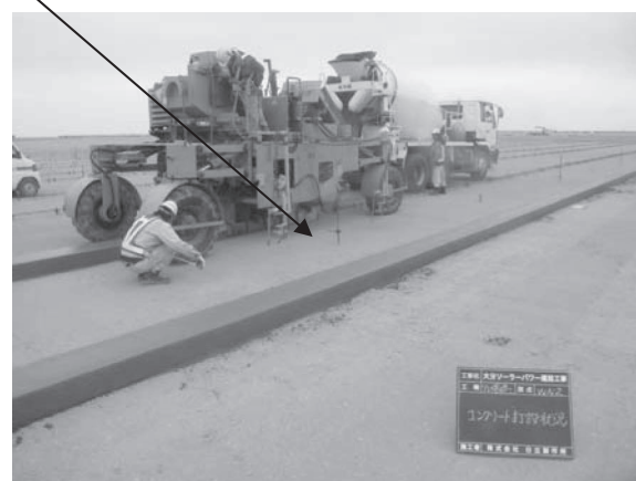
写真—18 打設後目視確認
