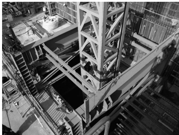
写真-1 支持架台先行設置状況
