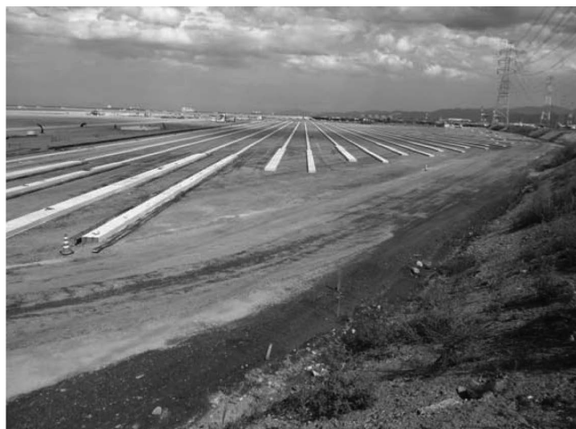
写真—6 基礎全景
