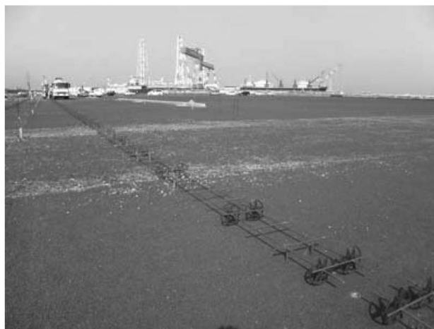
写真15 鉄筋固定状況
