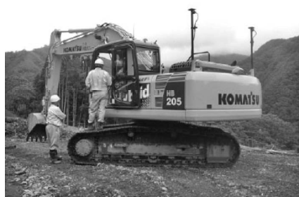
写真—1 情報化施工機器の設置状況（MGバックハウ）
