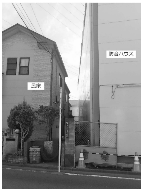
写真—7 民家に隣接した防音ハウス
