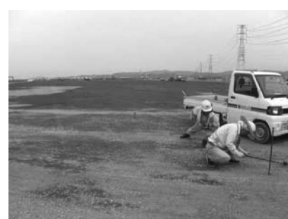
写真—20 ガイドロープ設置状況
