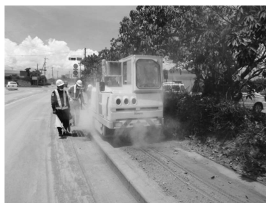
写真一 現場踏査状況
