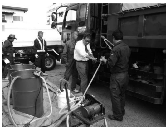
写真—5 B100 への燃料入れ替え状況
