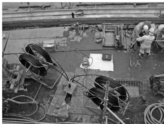
写真一7 高速配管建て込み装置
