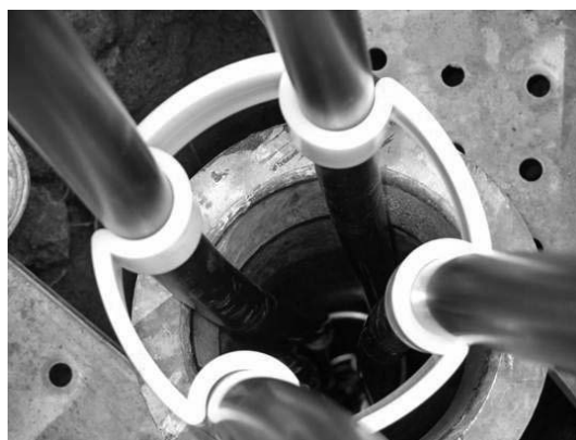
写真—5 専用ストッパーの装着状況
