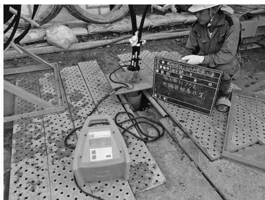
写真—4 EFコントローラーによる電気融着
