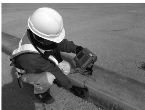
写真16 プロコメーターによる鉄筋かぶり測定
