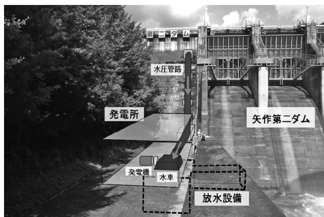
写真一 新串原水力発電所概略図
