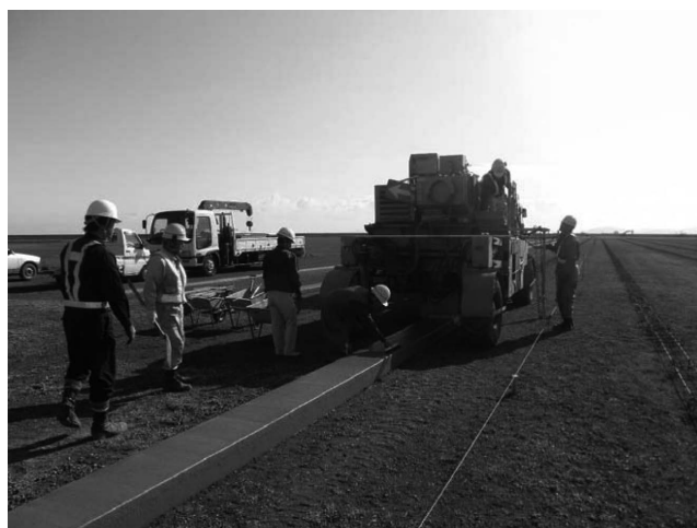
写真—8 スリップフォームによる打設
