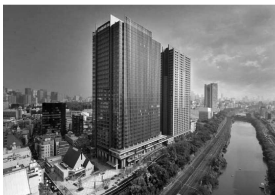
写真—1 B100適用車両導入工事の完成写真
