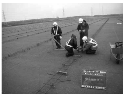
②鉄筋組み
