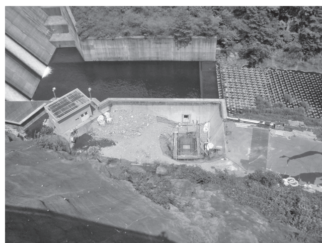
写真—4 阿多岐工事状況図
