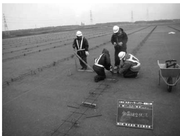
写真14 鉄筋組立状況
