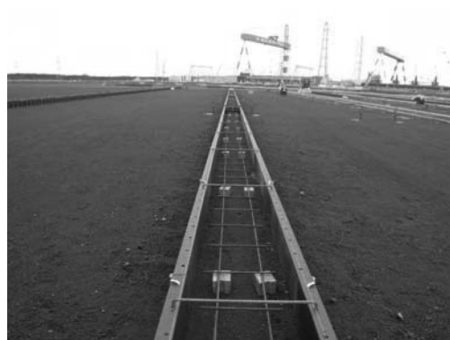
③鉄筋組み
