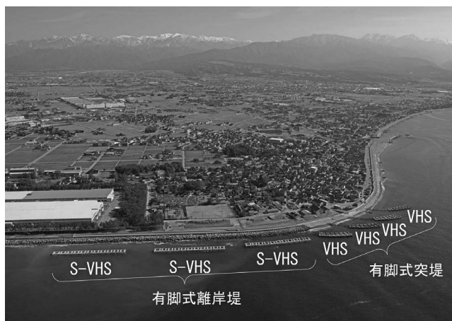
写真—2 富山県下新川海岸の有脚式離岸堤
