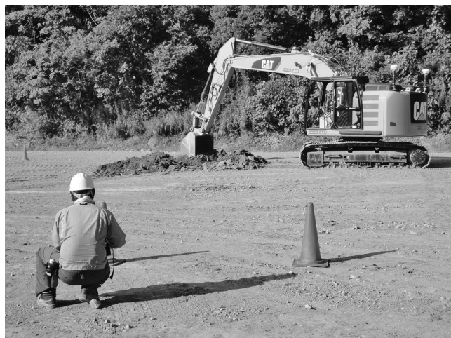
写真—5 遠隔操縦ロボットを搭載した建機
