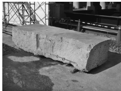
写真—6 ブロック化の状況
