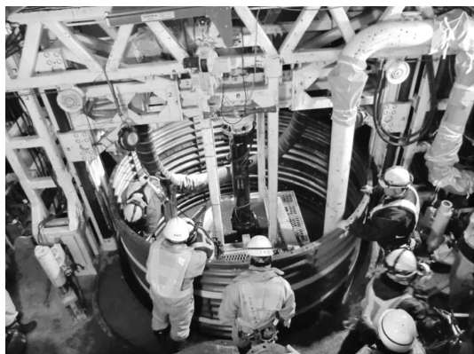
写真-3 施工状況
