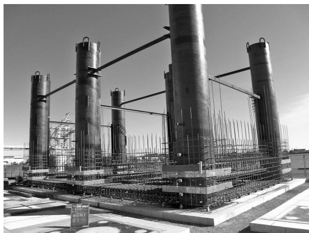
写真—3 ガイド管および鉄筋組立て
