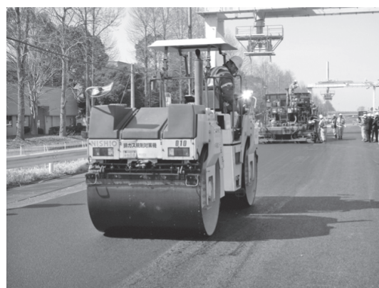
写真—2 低燃費舗装の試験施工状況
