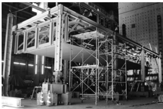
写真—2 大規模天井の加振実験
