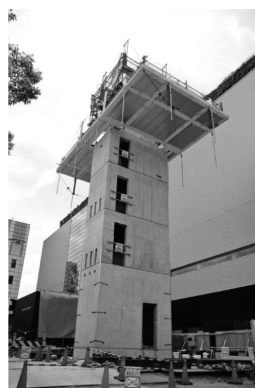
写真-3 リフトアップ工法による屋上階床スラブの施工
