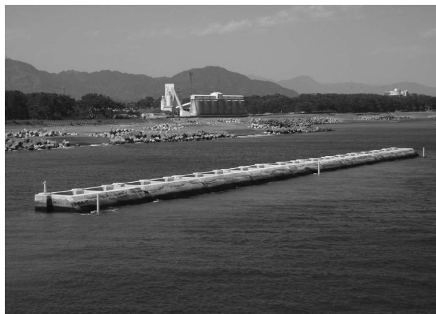
写真-11 完成した本工法による離岸堤（沖側）
