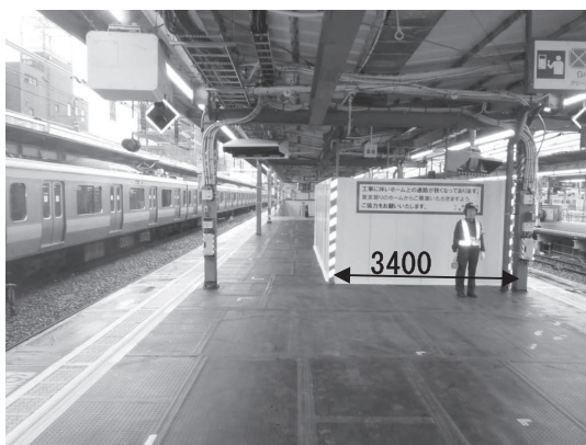
写真—5 仮囲い (3.4 m × 6.5 m)
