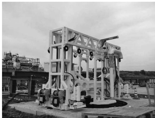
写真—1 ポータル JET-32 全景
