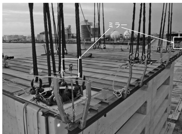
写真一九 函体陸側両端2箇所に設置されたミラー
