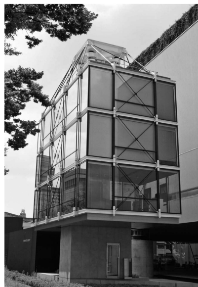
写真一1 本免震構造館
