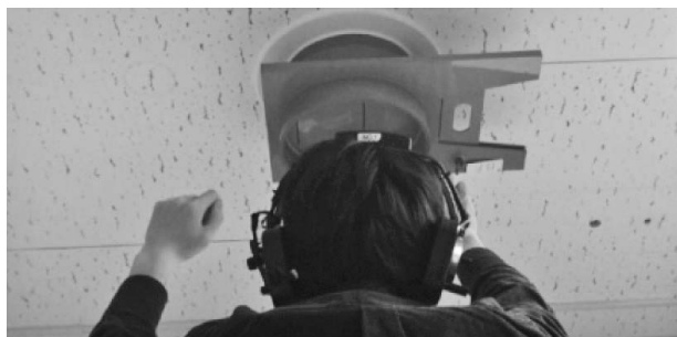
高所での作業
