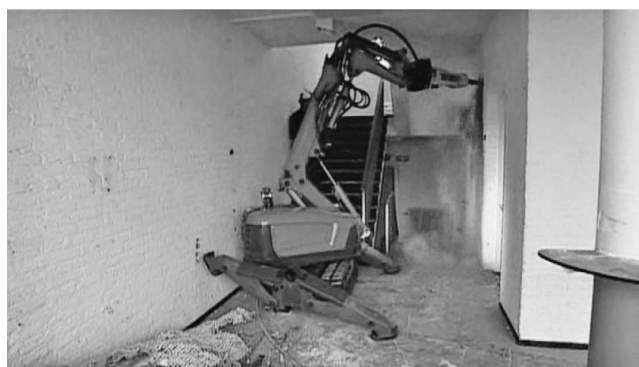
写真—3 屋内現場施工例
