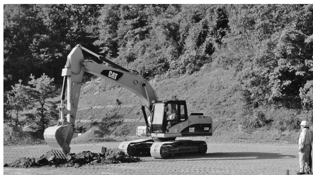
写真—4 リモコン仕様の建機
