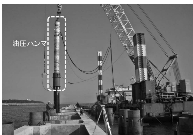
写真一八 油圧ハンマによる鋼管杭打設
