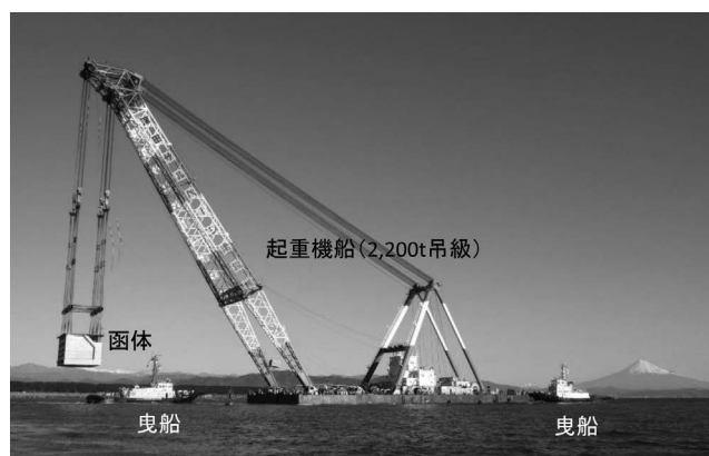
写真—5 起重機船による函体曳航
