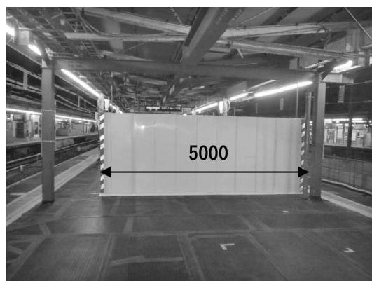
写真—2 仮囲い設置状況 (5m × 8m)
