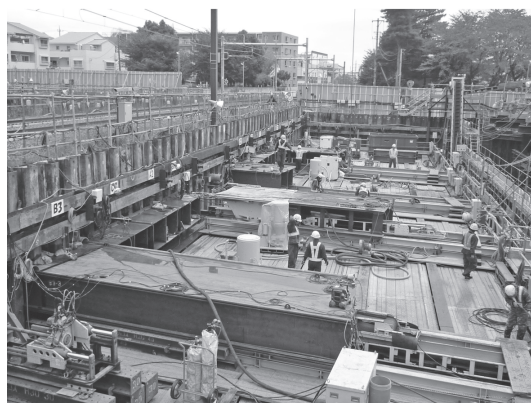
写真一 8 ニツ家 Bv 施工状況
