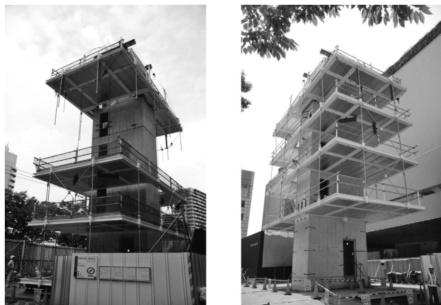
写真ー4 リフトアップ工法による2階～4階床スラブの施工
