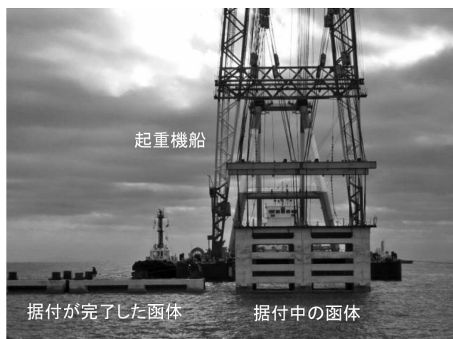
写真—6 起重機船による函体据付
