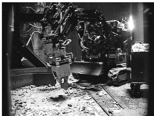
写真-10 建屋内での瓦礫撤去
