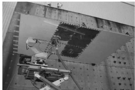
写真一2 実証実験による表面処理状況
