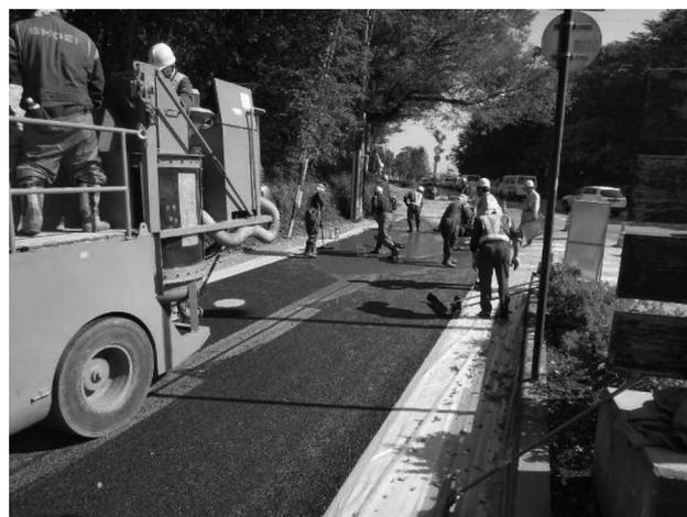
写真—11 一般道半たわみ舗装工事（昼間）
