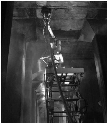
写真—5 施工状況（塗膜除去）
