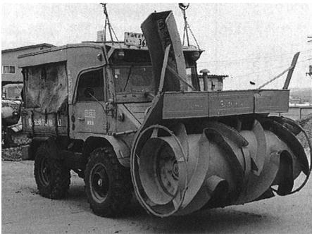
写真 2-103 シュミットカッター形ワンステージ 走行動力 32PS, 作業動力 110PS シュミット社 昭和 37 年<sup>2)</sup>
