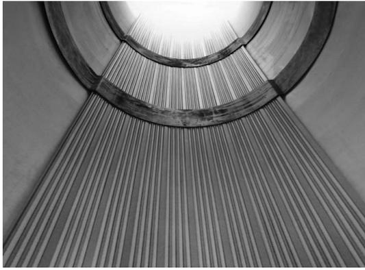
写真-3 管底設置型の設置例
