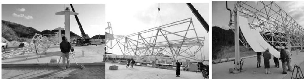
写真-2 大型集熱装置の組立
