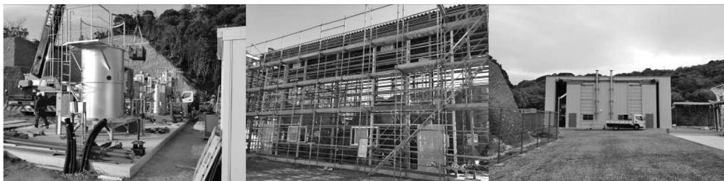
写真一4 ボイラー据付, 建屋建設
