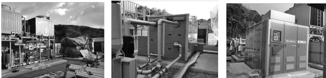
写真一3 バイナリー発電装置の据付
