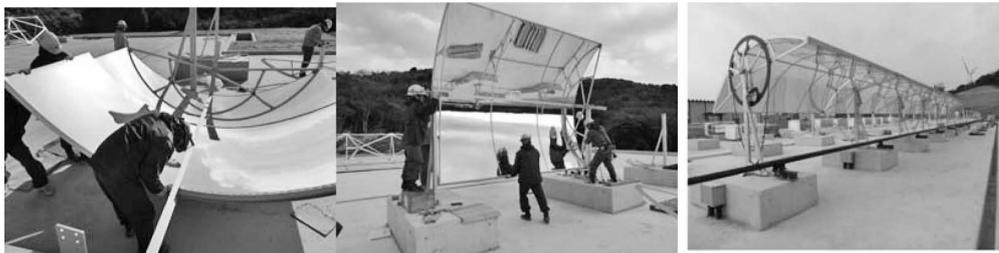
写真-1 小型集熱装置の組立
