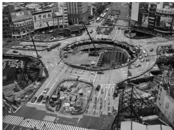
写真—2 円形地下鉄美麗島駅の構築状況
