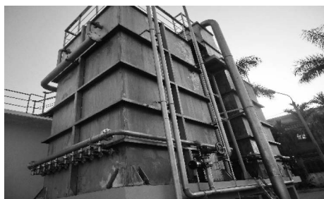
写真—5 ビンバオ浄水場の U-BCF
