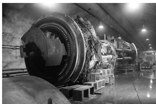
写真—12 TBM-2 発進基地到達状況
