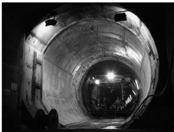
写真—12 沈埋トンネルとの接続完了
