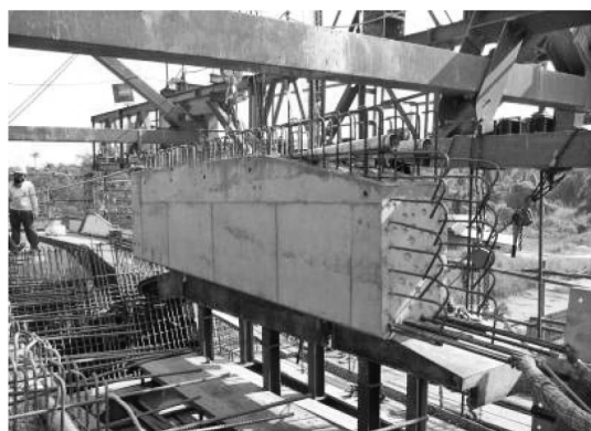
写真—10 プレキャストリブの設置
