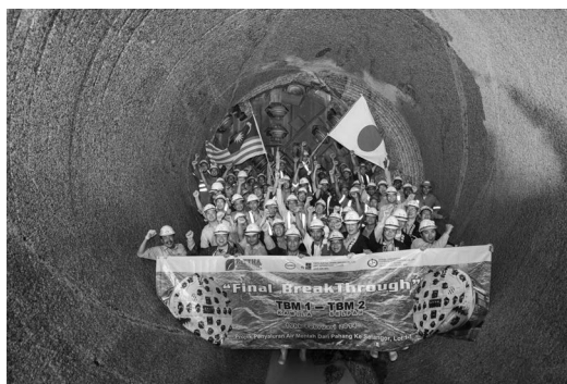
写真—14 最終貫通状況
