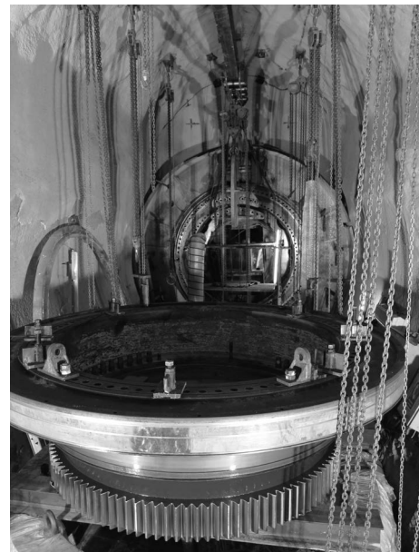
写真一九 TBM-2 メインベアリング交換状況
