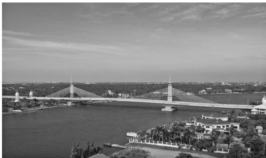
写真—16 メイン橋完成 2014年12月の撮影
