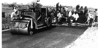
写真-21 アスファルト舗装状況
