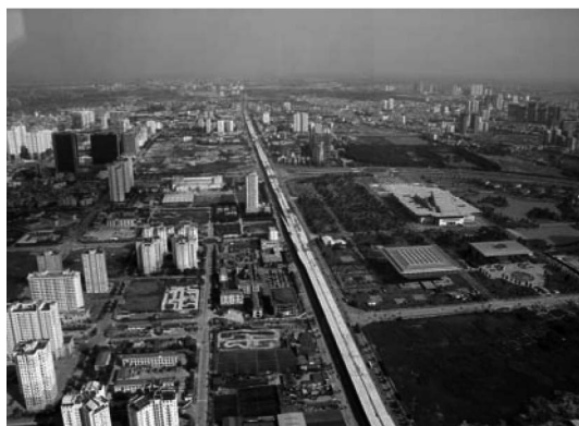
写真一 1 工事中の写真 (パッケージ 1 とパッケージ 2)
