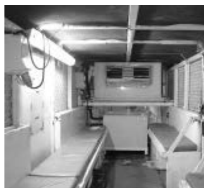
写真一5 作業員坑内移動車への冷却設備搭載 (奥がエアコン)
