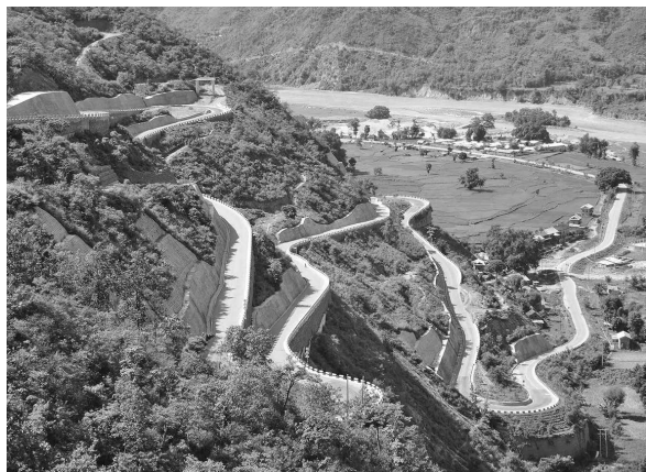
写真—7 第3工区つづら折り区間の完成写真
