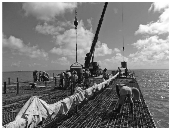
写真—12 コンクリート打設状況
