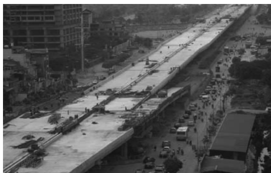
写真一 3 工事中の写真 (パッケージ 2)
