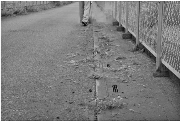
写真一一 三笠産業 MCG-50 溝掃除機の作業後風景
