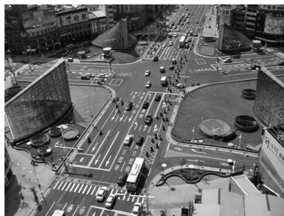
写真—3 美麗島駅の地上部完成状況
