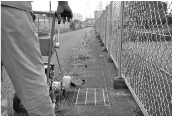
写真一〇 三笠産業 MCG-50 溝掃除機での作業風景
