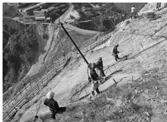
写真—5 ウィンチを用いたロックボルト施工
