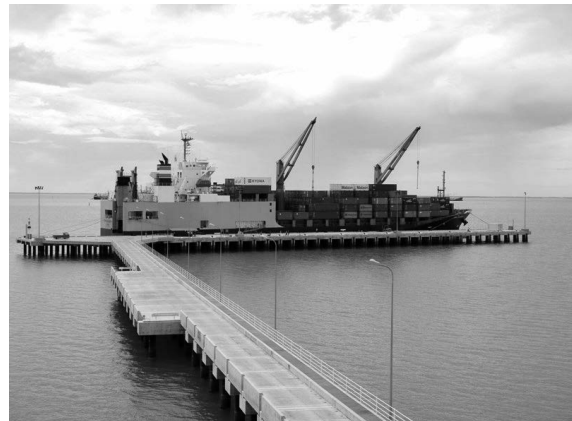
写真－14 供用開始したベシオ港
