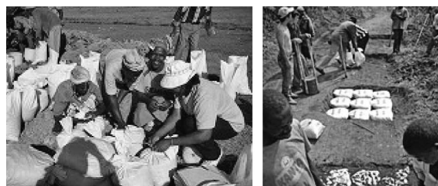
写真-1 住民が土嚢を用い道路を整備 短期間に施工可、雇用創出にも貢献 (出典：JICA ホームページ)
