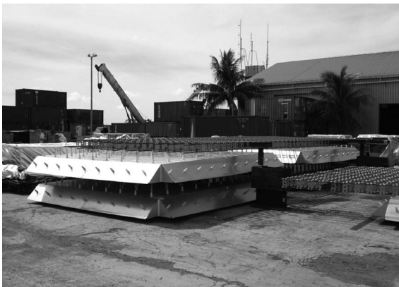
写真一五 スラブ大組み完了
