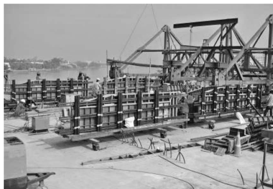
写真—9 橋面上でのプレキャストリブの製作
