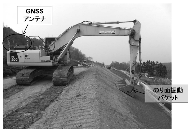
写真—1 施工状況
