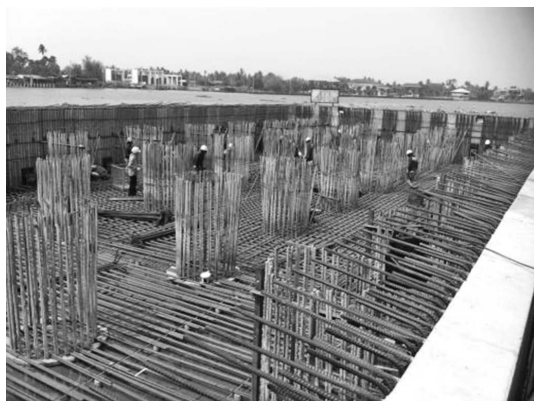
写真-4 内部をドライにした状況での作業
