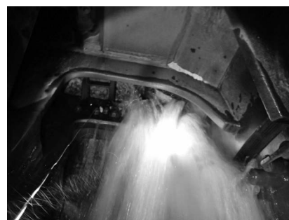
写真—2 TBM-1 突発湧水状況 (TBM カッタヘッド部)
