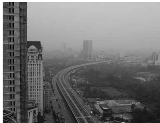
写真一 5 完成後の写真 (パッケージ 1)
