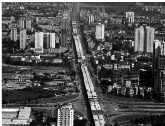
写真一 2 工事中の写真 (パッケージ 2)
