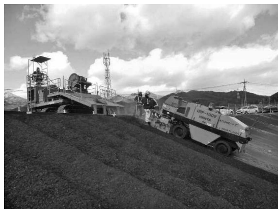
写真—2 切削機作業現場写真
