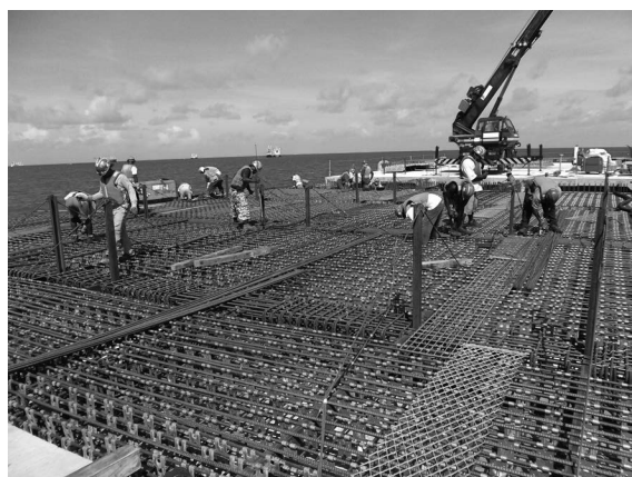
写真—10 スラブ鉄筋組立状況
