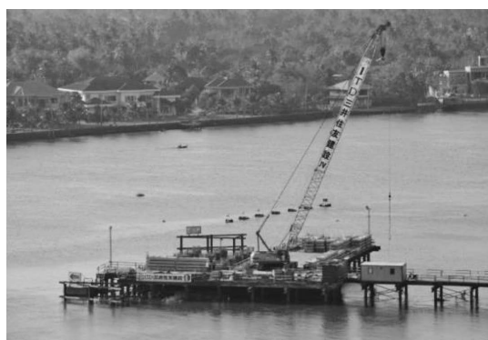
写真ー 2 河川内に設置した栈橋と作業構台上での下部工工事
