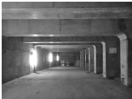
写真—11 桁内部の状況
