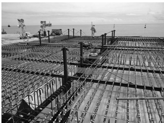
写真—11 C型鋼及び丸鋼設置完了
