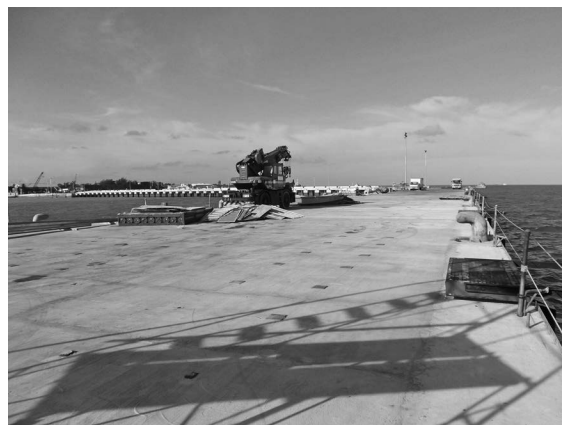
写真—13 コンクリート完了
