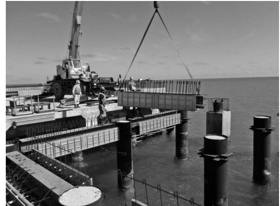
写真一六 梁据付状況
