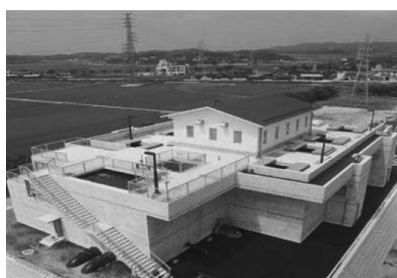
写真—1 U-BCF 施設 (本城浄水場)
