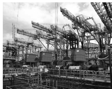
土砂搬出設備状況
