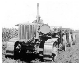
写真-17 3連スクレーパ牽引
