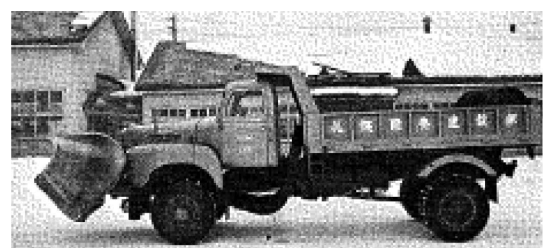
写真3-34 建機形プラウ特殊懸架装置 北海道開発局 昭和39年 1)
