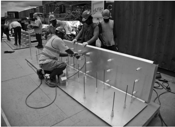
写真一三 梁大組み状況
