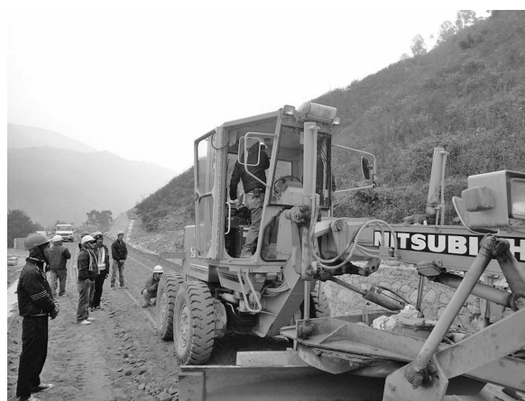
写真—3 作業員対象の車輛の死角体験
