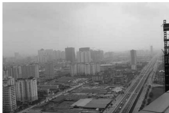
写真一 6 完成後の写真 (パッケージ 1)
