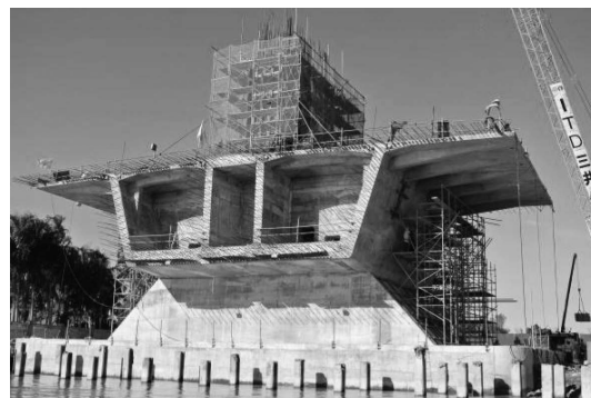
写真-5 M3 柱頭部施工完了
