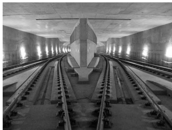
写真—5 クロスオーバー部の構造
