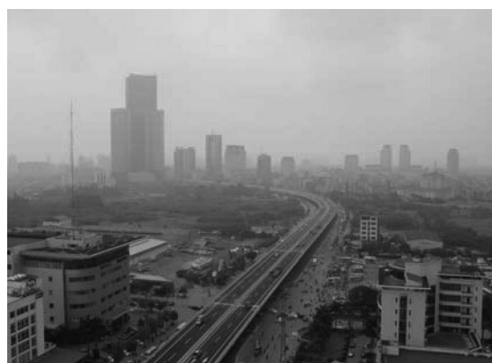
写真一 4 完成後の写真 (パッケージ 1)
