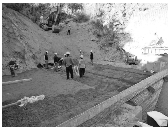
写真—2 補強盛土壁工事写真
