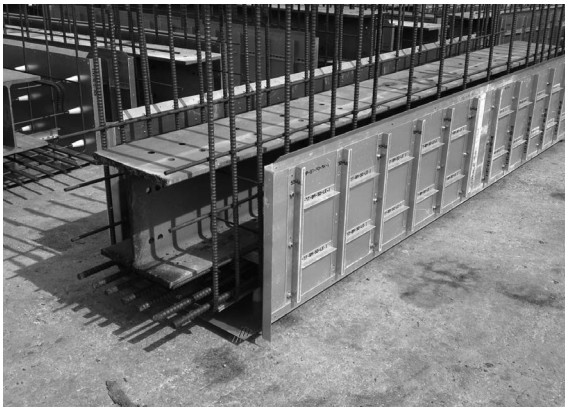
写真一四 梁大組み完了
