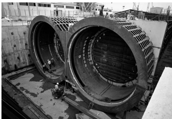
写真—10 鋼殻スリーブ管の設置
