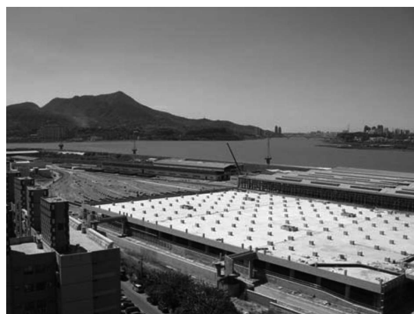
写真—6 蘆洲操車場の全景
