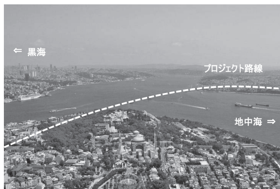
写真—1 ボスポラス海峡横断部
