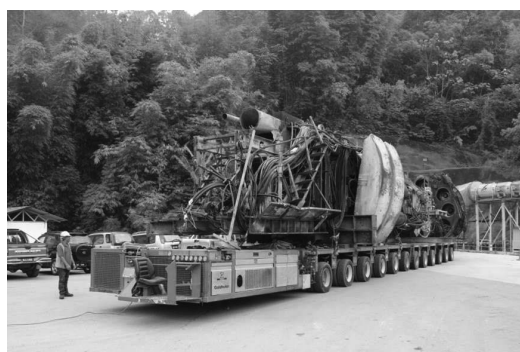
写真—13 TBM-2 坑外搬出状況（多軸台車にて）
