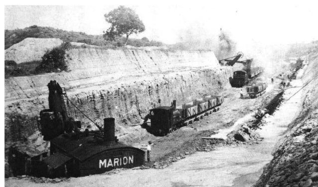
写真—1 嘉南大圳の灌漑用水路掘削
