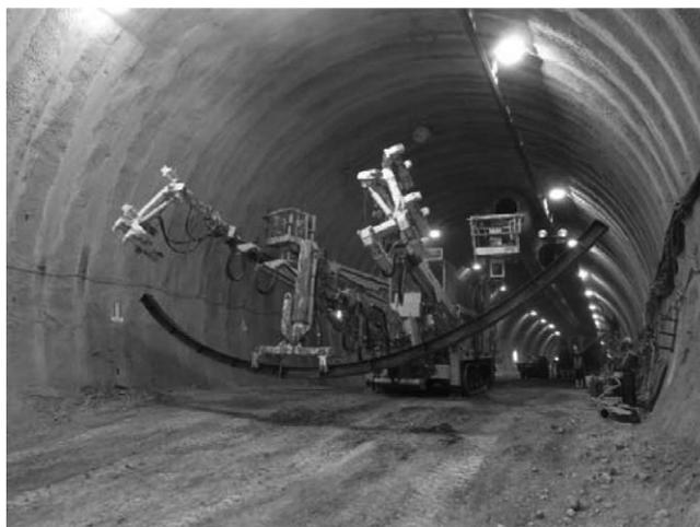
写真-1 インバート支保工の一括化
