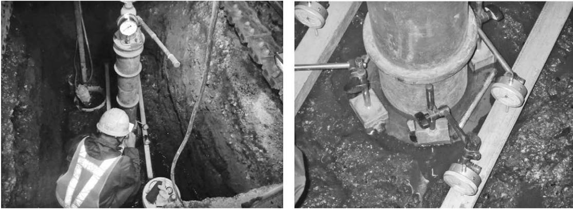
写真—1 平板載荷試験状況
