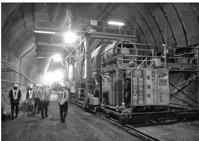
写真-4 送気・吸引捕集方式（集塵機）
