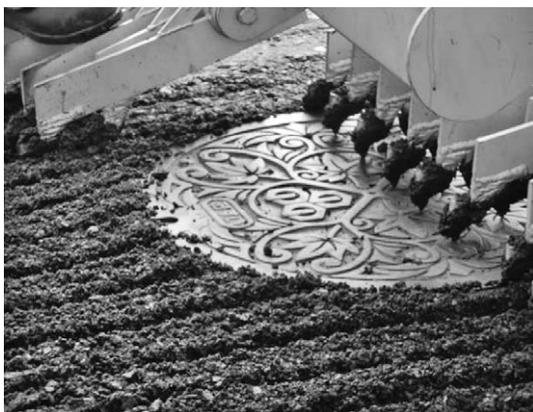
写真一3 マンホール部施工状況
