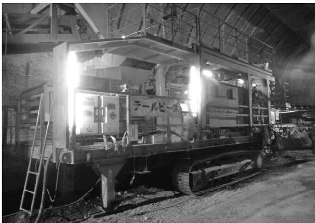
写真-3 連続ベルトコンベアシステム
