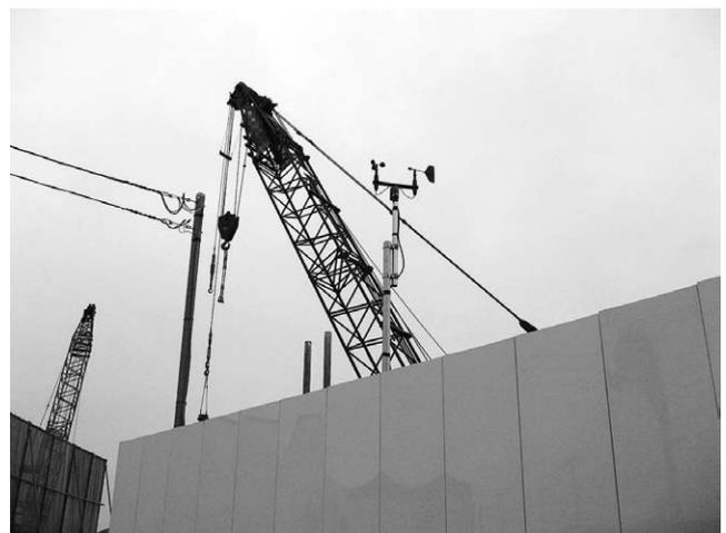
写真—6 風向風速監視システム
