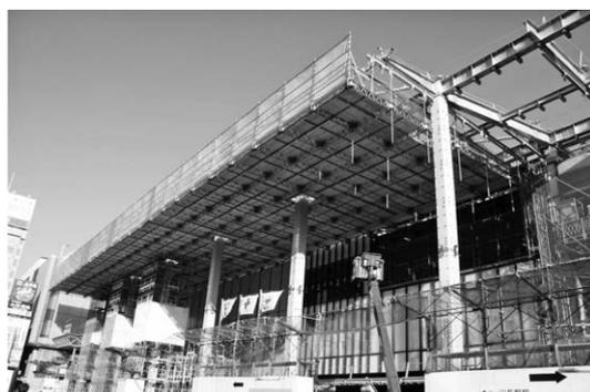
写真-1 駅舎の大庇新築工事
